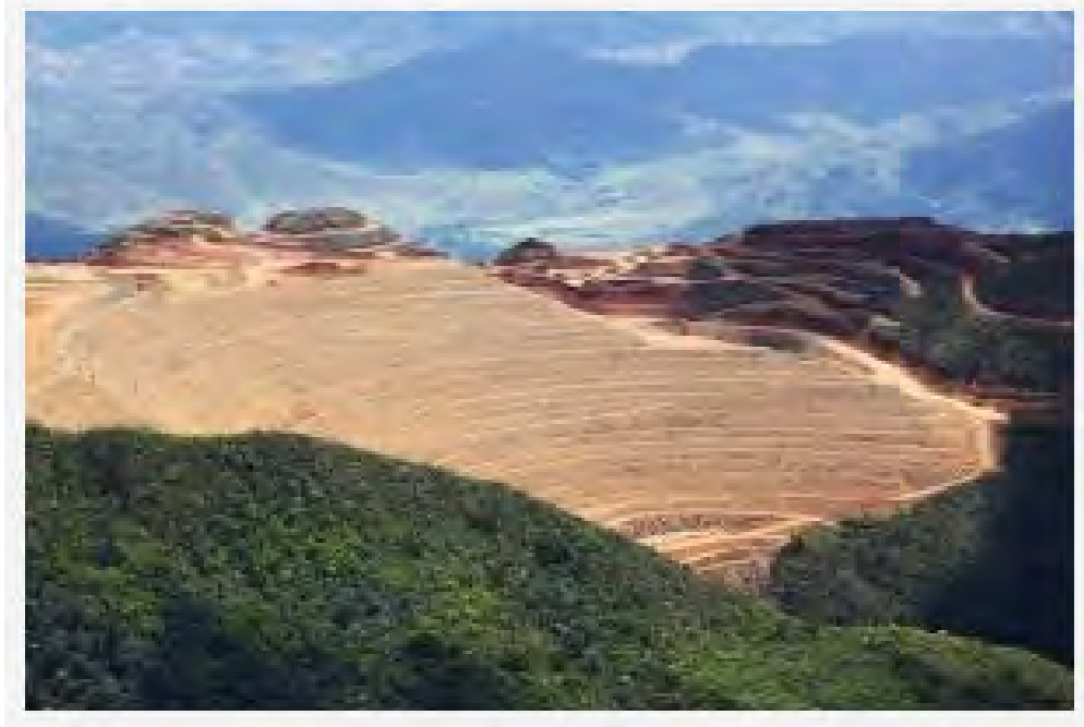
FIGURE 1.13 – Extraction sur gradin source :[SLN, 2018]
