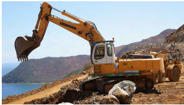
FIGURE 1.11 – Le décapage avant l'extraction source : [SLN, 2018]
