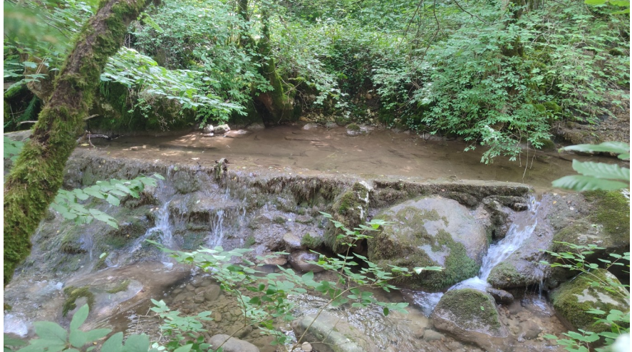
Illustration 13 : Seuil du moulin entre Le Noyer et Saint-François de Sales sur le Nant de Saint-François
