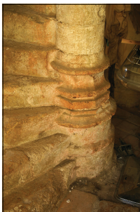
Figure 77 : Vestiges des remaniements du début du XVI e siècle. De haut en bas et de gauche à droite : Tour aveugle sud-ouest ; Détails du collage des tours sur le logis primitif ; Tour d'escalier et détail de la base du noyau de l'escalier. Clichés : F. Boisserie.
