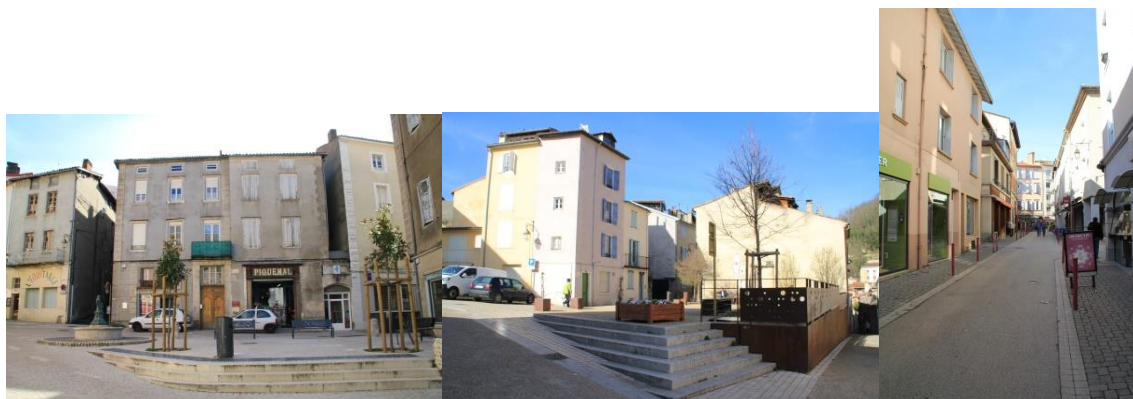
Photo 4 : Exemples de places et rues réhabilitées (Réalisation : Céline Dubarle)
