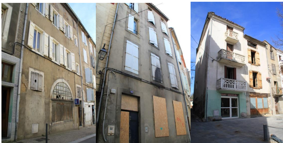
Photo 5 : Exemples d'immeubles vétustes (Réalisation: Céline Dubarle)
