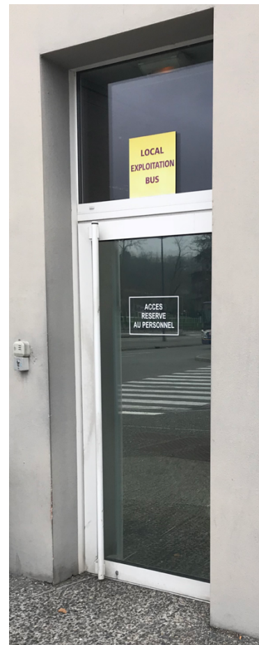
Porte d'accès d'un local conducteur dans le pôle Paul Sabatier
