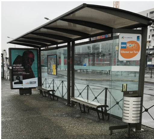
Abris bus à un arrêt interurbain de Borderouge
