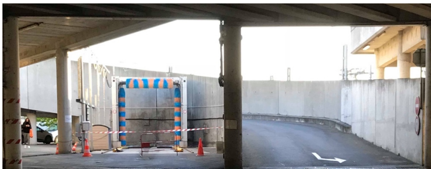
Espace d'entretien et descente de la dalle de stationnement
