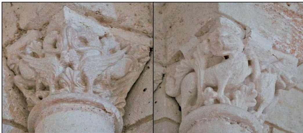
Figure 393 – Église Saint-Cybard de Plassac à Plassac-Rouffiac, chapiteaux au sud de la baie axiale.
