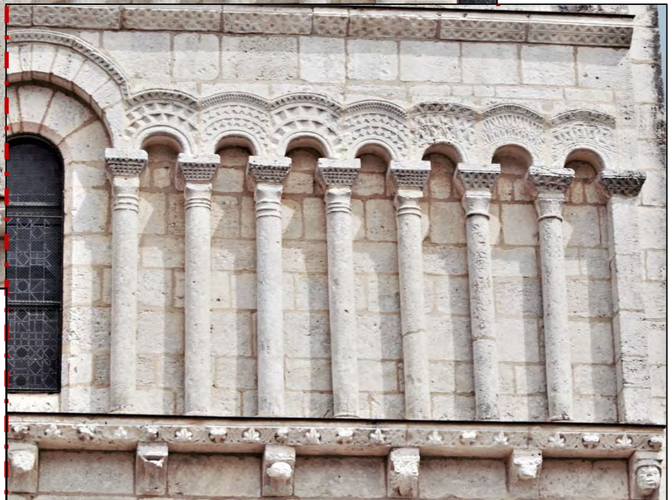
Figure 171 – Bourg-sur- Charente, église Saint- Jean-Baptiste, façade occidentale, second registre. En haut : moitié nord. En bas : moitié sud.
