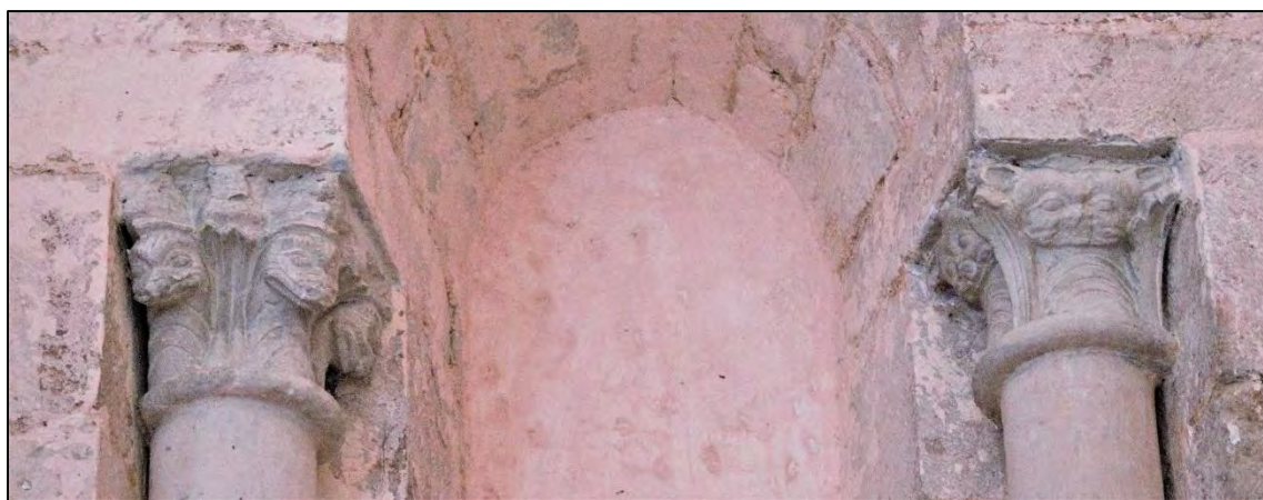
Figure 304 – Église Saint-Denis de Vars, mur gouttereau sud de la travée droite de chœur.
