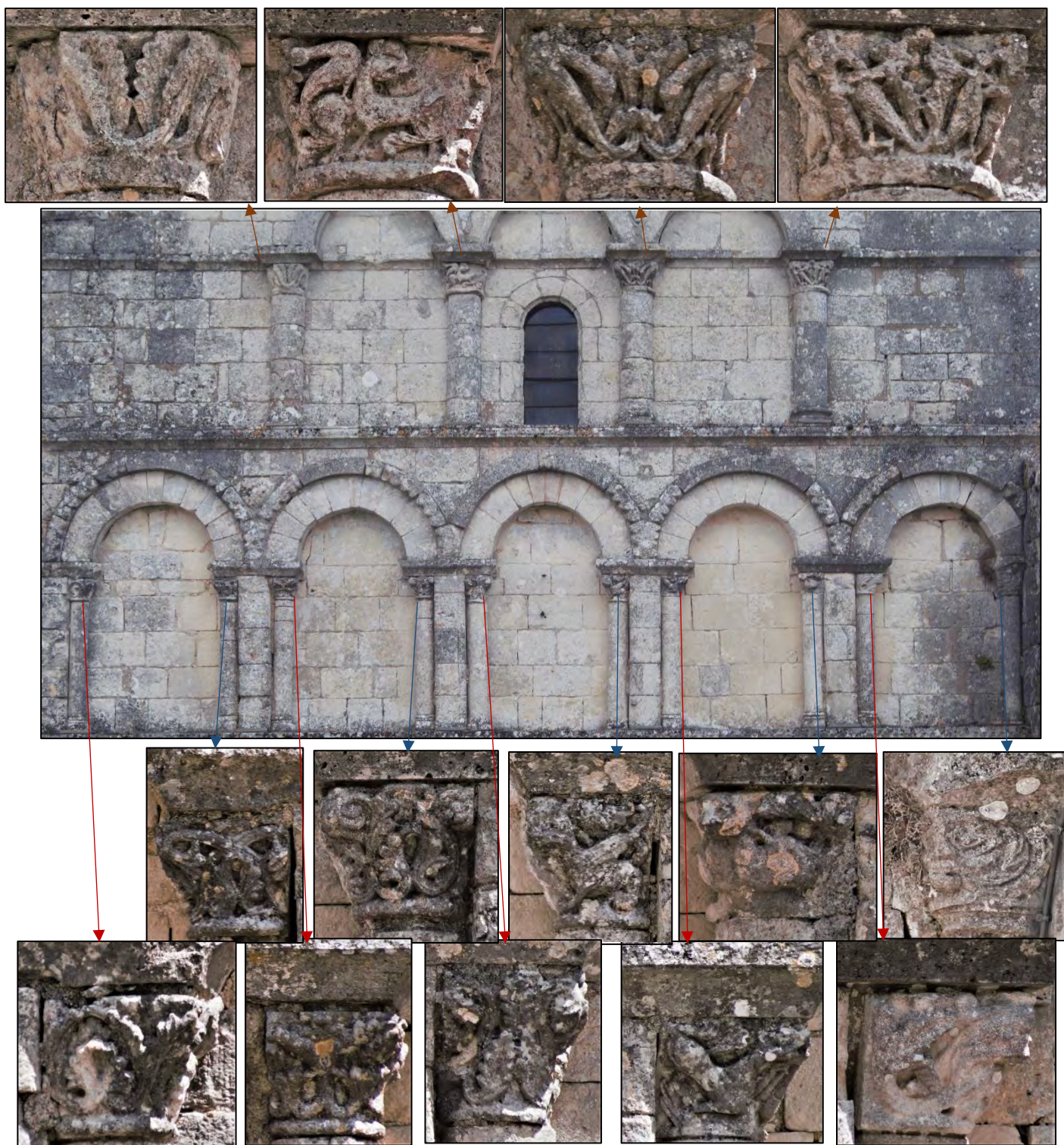
Figure 166 – Plassac, église Saint-Cybard, façade occidentale, registres supérieurs, détails des motifs des chapiteaux des arcatures.
