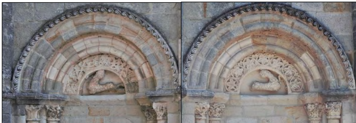
Figure 154 – Montmoreau-Saint-Cybard, église Saint-Denis, façade occidentale. À gauche : arcature au nord de la façade. À droite : arcature au sud de la façade.
