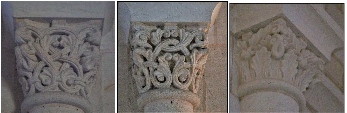
Figure 361 – Église Notre-Dame de Trois-Palis, chapiteaux de l'abside. De gauche à droite : au nord-est de l'abside, à l'est et sur l'extrémité sud-est.
