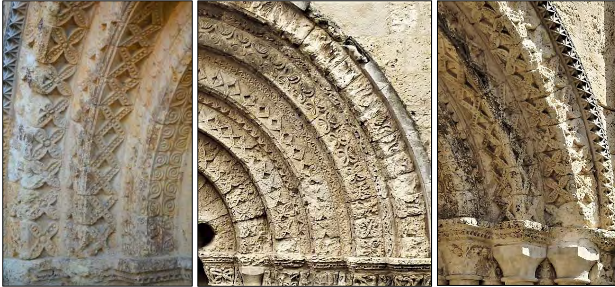
Figure 183 –Aubeterre-sur-Dronne, église Saint-Jacques, façade occidentale, voussures des portails nord (à gauche), central (au centre) et sud (à droite).
