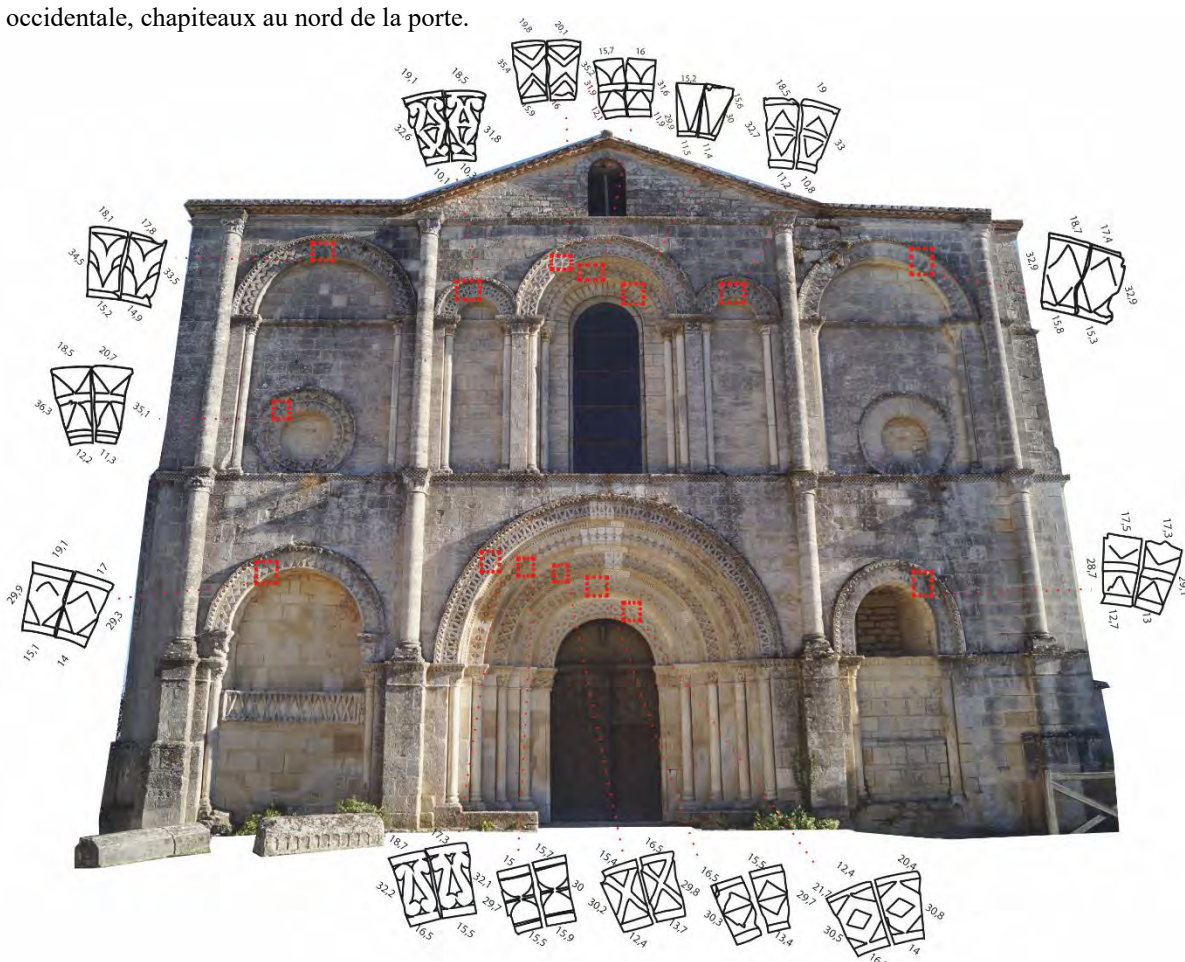
Figure 129 – Saint-Amant-de-Boixe, église abbatiale, façade occidentale, dessins et mesures de tous les types de claveaux des voûtures. DAO : E. Chargé.
