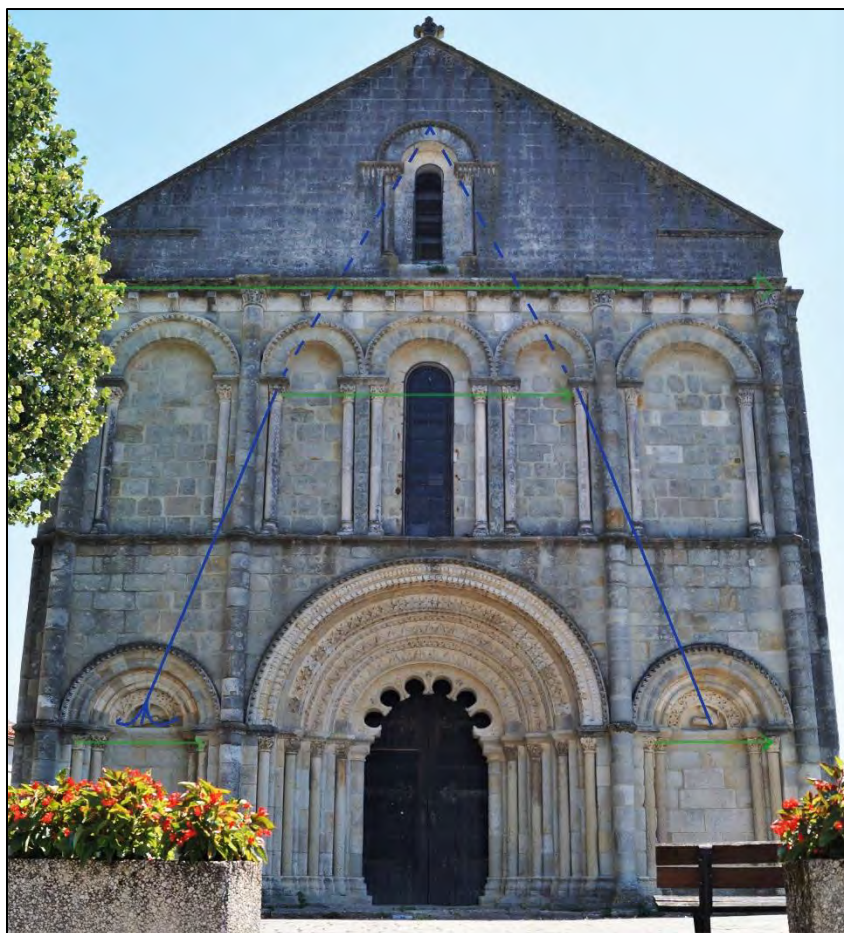
Figure 194 – Montmoreau-Saint-Cybard, église Saint-Denis, façade occidentale, schéma d'associations sémantiques et formelles entre les différents niveaux de la façade et des mouvements engagés par les formes végétales.
