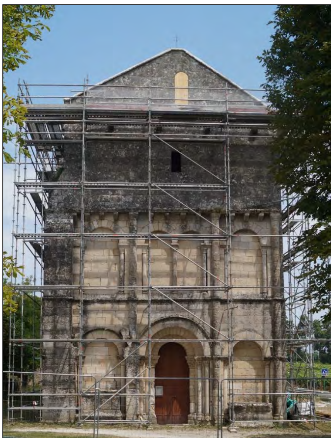
Figure 41 – Façade occidentale de l'église Saint-Vincent de Champmillon, durant la campagne de restauration 2021-2022.
