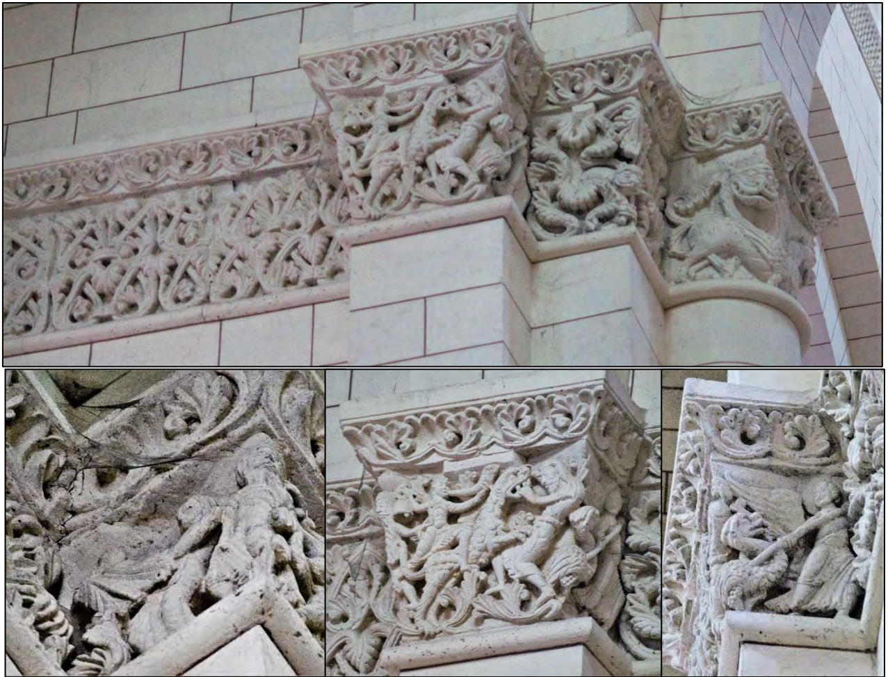
Figure 295 – Cathédrale d'Angoulême. En haut : partie occidentale de l'arc triomphal ouvrant sur la chapelle du bras nord du transept. En bas : détails du chapiteau de pilastre. La face occidentale (à gauche) est presque contre le mur.
