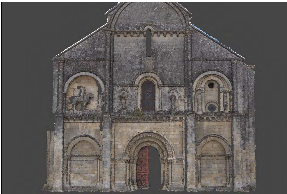
Figure 67 – Façade occidentale de Saint-Pierre de Châteauneuf-sur-Charente. Nuage de points dense, une des étapes de la modélisation sur Agisoft Metashape©. Photographies et photogrammétrie : E. Chargé.
