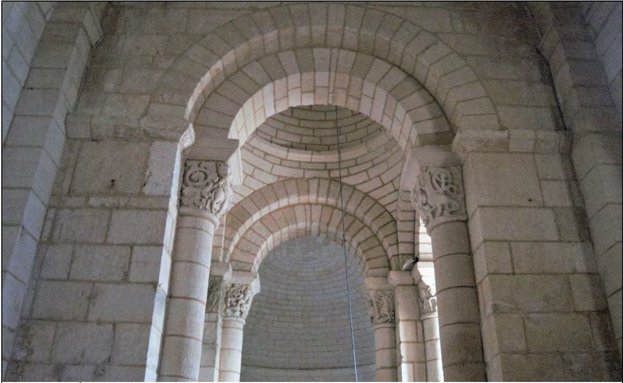
Figure 416 – Église Notre-Dame de Trois-Palis, vue depuis la partie orientale centrale de la nef.
