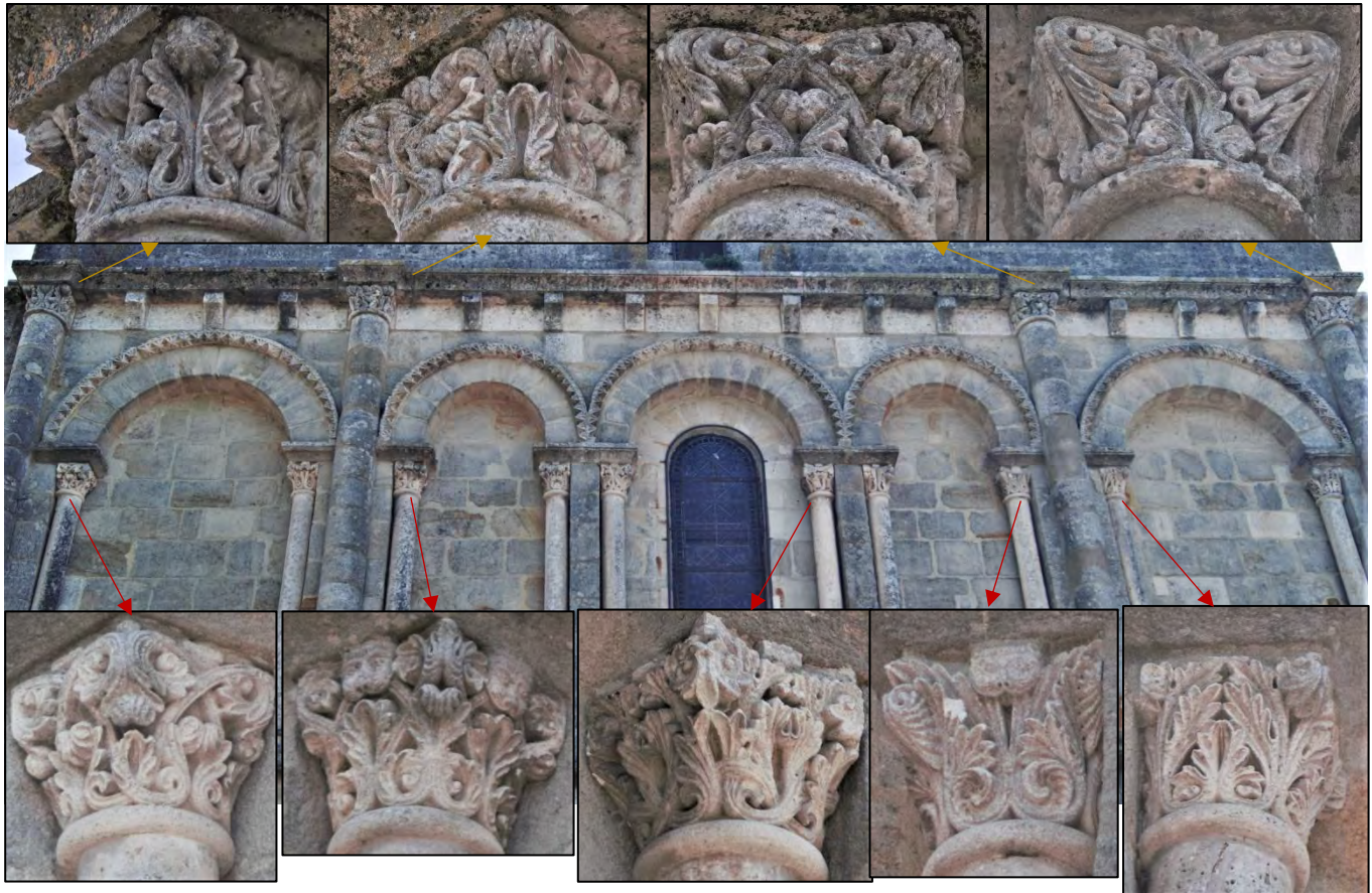
Figure 174 – Montmoreau-Saint-Cybard, église Saint-Denis, façade occidentale, second registre détails des motifs des chapiteaux des arcatures et des colonnes-contreforts.
