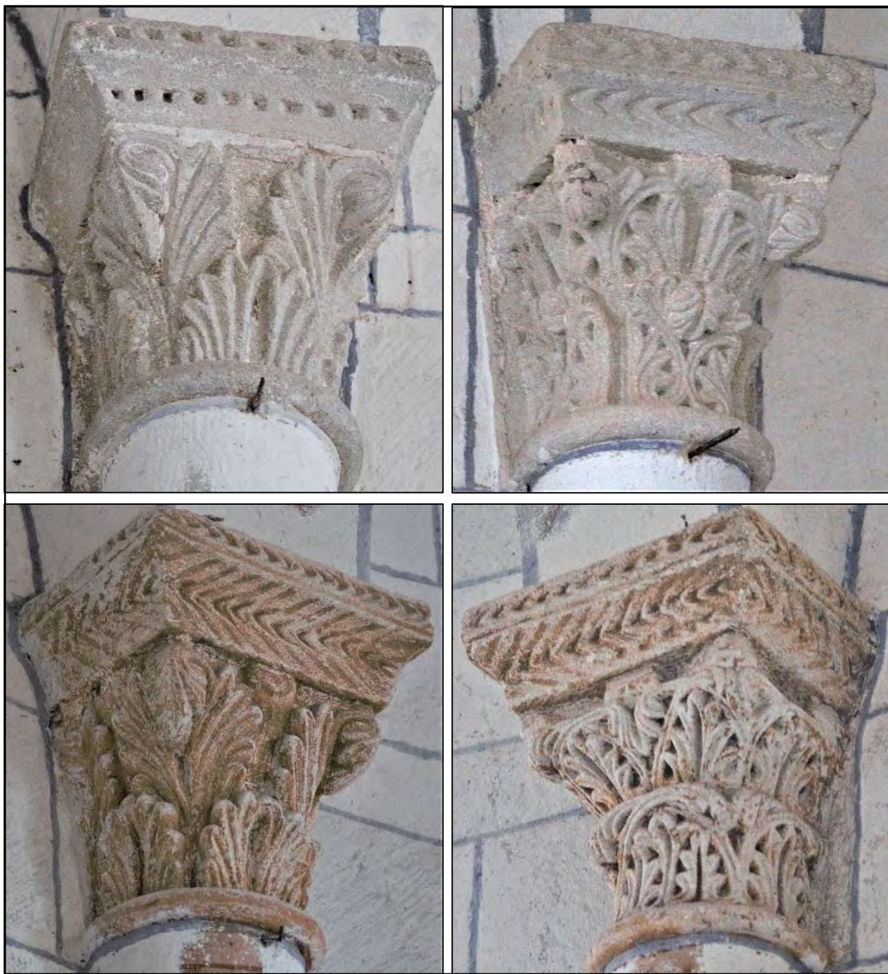
Figure 340 – Église Saint-Gervais-Saint-Protais de Pérignac, chapiteaux de l'abside. En haut, les chapiteaux en vis-à-vis sur les parties occidentales de l'abside, au nord (à gauche) et au sud (à droite). En bas, les chapiteaux en vis-à-vis au nord-est (à gauche) et au sud-est (à gauche) de l'abside.
