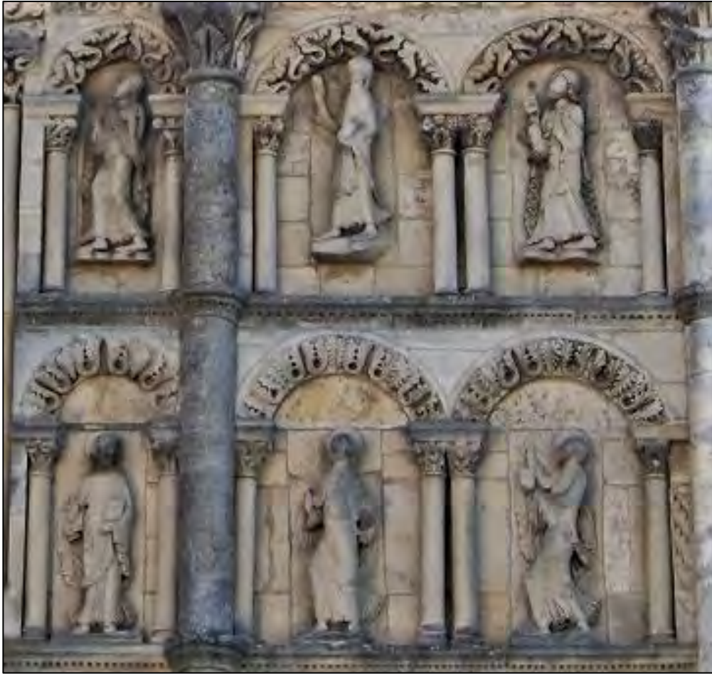
Figure 112 – Angoulême, cathédrale, façade occidentale, partie sud, second niveau avec figures sous arcades.
