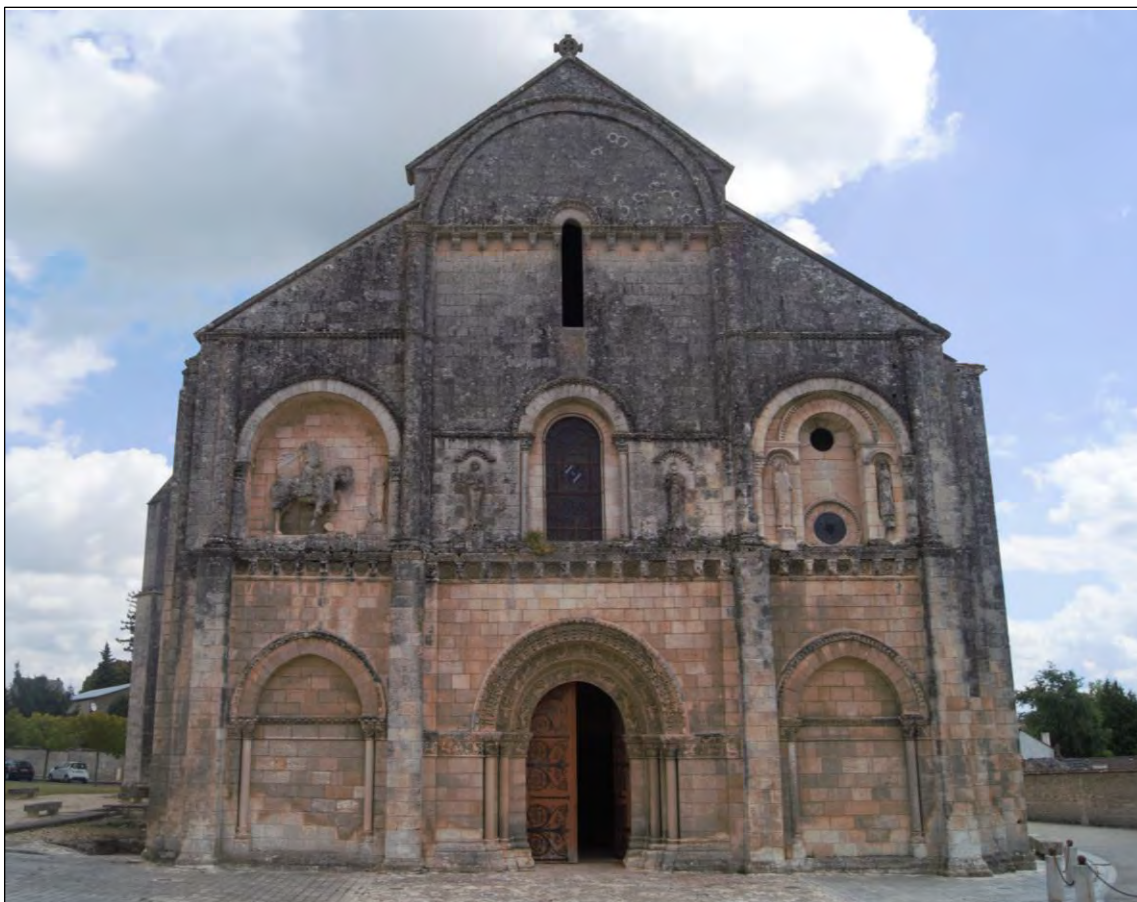
Figure 27 – Façade occidentale de l'église abbatiale Saint-Pierre de Châteauneuf-sur-Charente.
