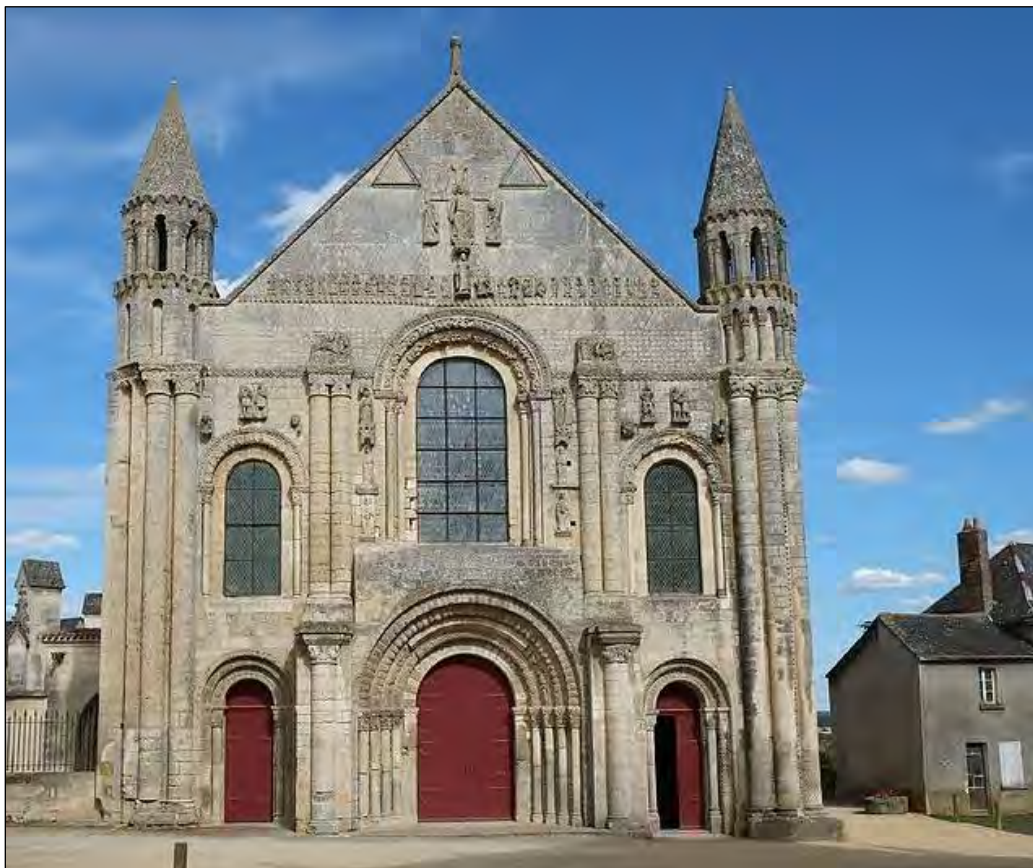
Figure 28 – Façade occidentale de l'église abbatiale de Saint-Jouin-de-Marnes (79). © P. Despoix.
