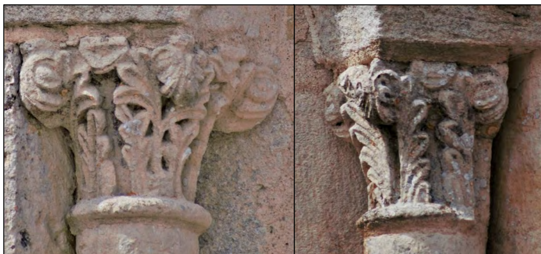
Figure 380 – Église Saint-Gervais-Saint-Protais de Pérignac, chevet. À gauche : chapiteau à l'ouest de la baie sud-est à l'extérieur de l'abside. À droite : chapiteau à l'est de la même baie.
