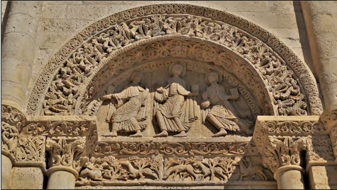
Figure 116 – Angoulême, cathédrale, façade occidentale, premier registre, travée sud (2022, après restaurations).
