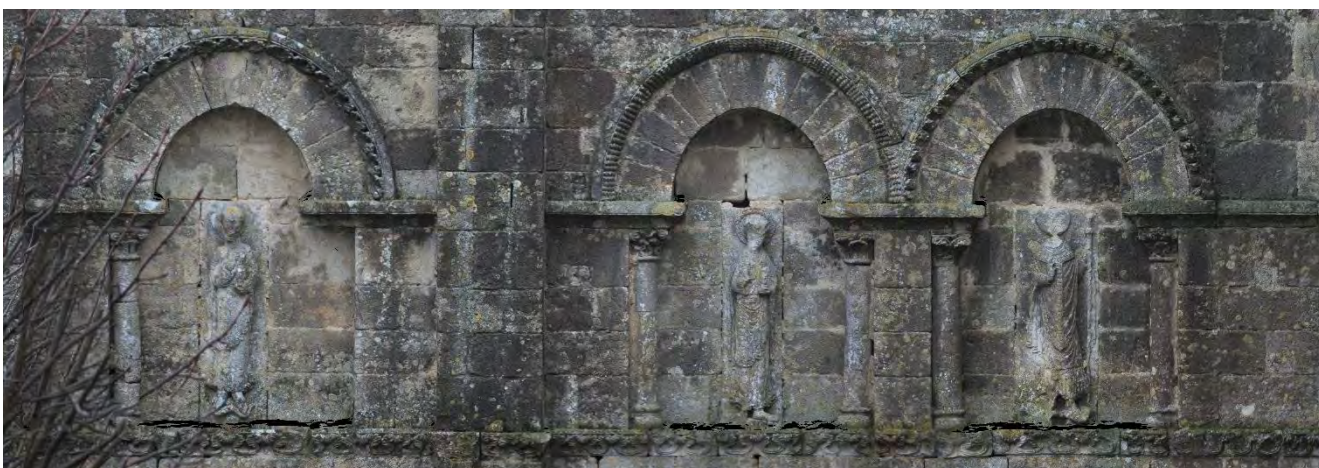
Figure 162 – Saint-Amant-de-Boixe, église abbatiale, bras nord du transept, façade occidentale, orthophotographie du second niveau. E. Chargé.
