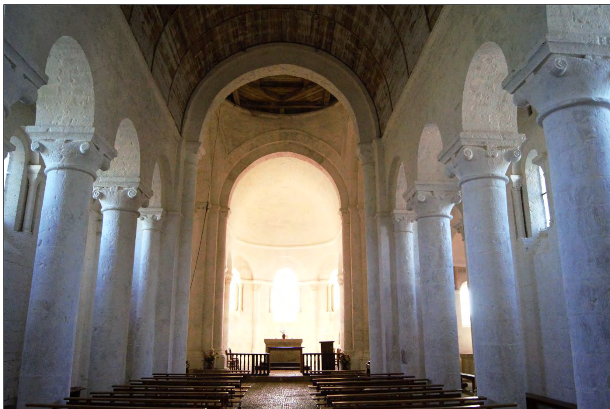
Figure 49 – Vue générale de la nef de l'église Saint-Denis de Lichères.
