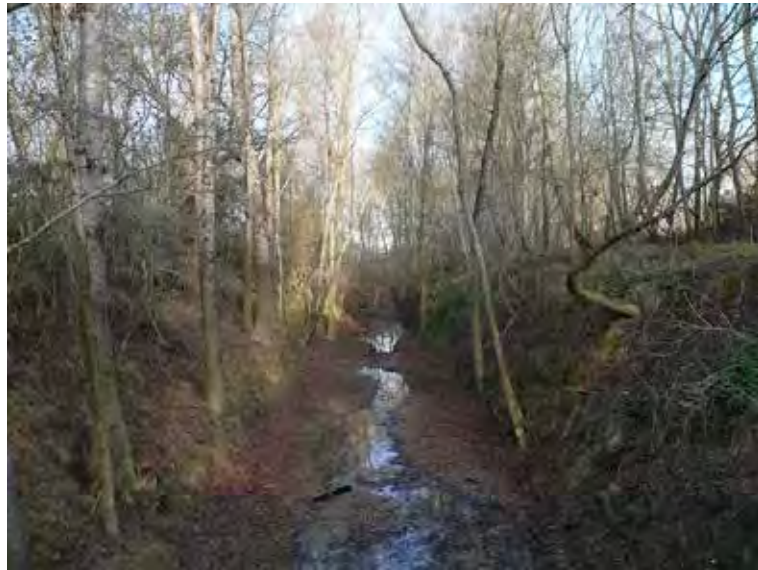
Figure 27 : Levées de terres destinées à drainer les crues dans la plaine de la Save en amont de l'Isle-Jourdain (Auradé)
