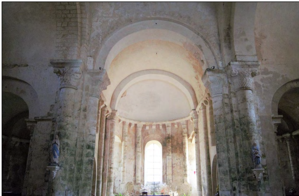
Figure III.3.5 – Vue intérieure de l'abside du chevet depuis la croisée du transept.
