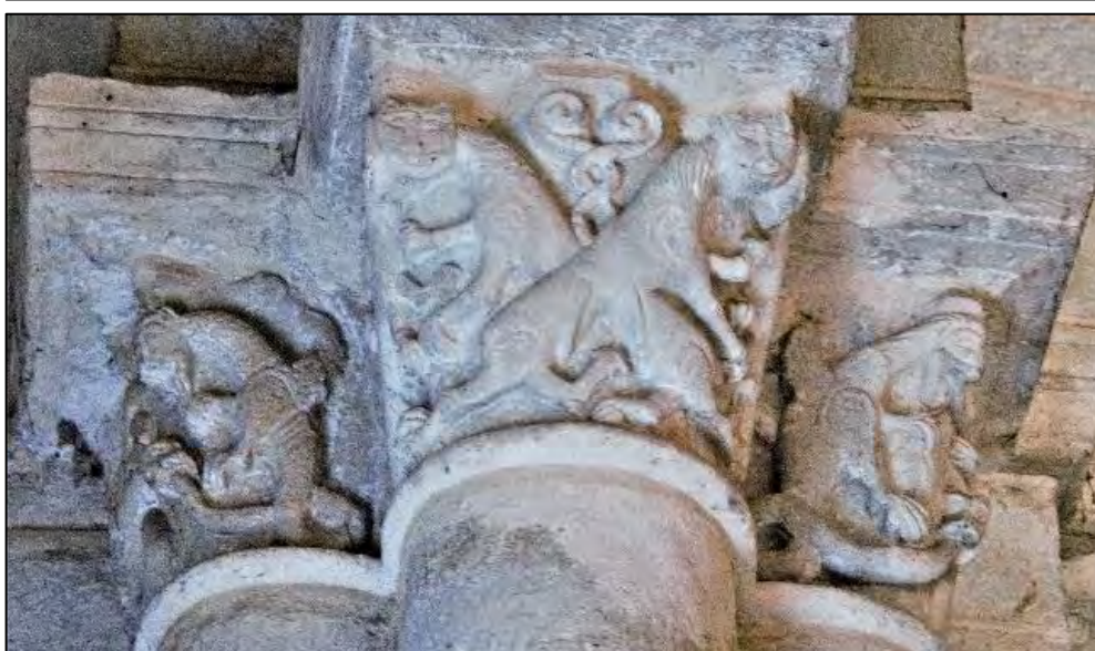
Figure III.7.19 – Vue depuis l'ouest des chapiteaux de la pile composée au nord-est de la croisée du transept.
