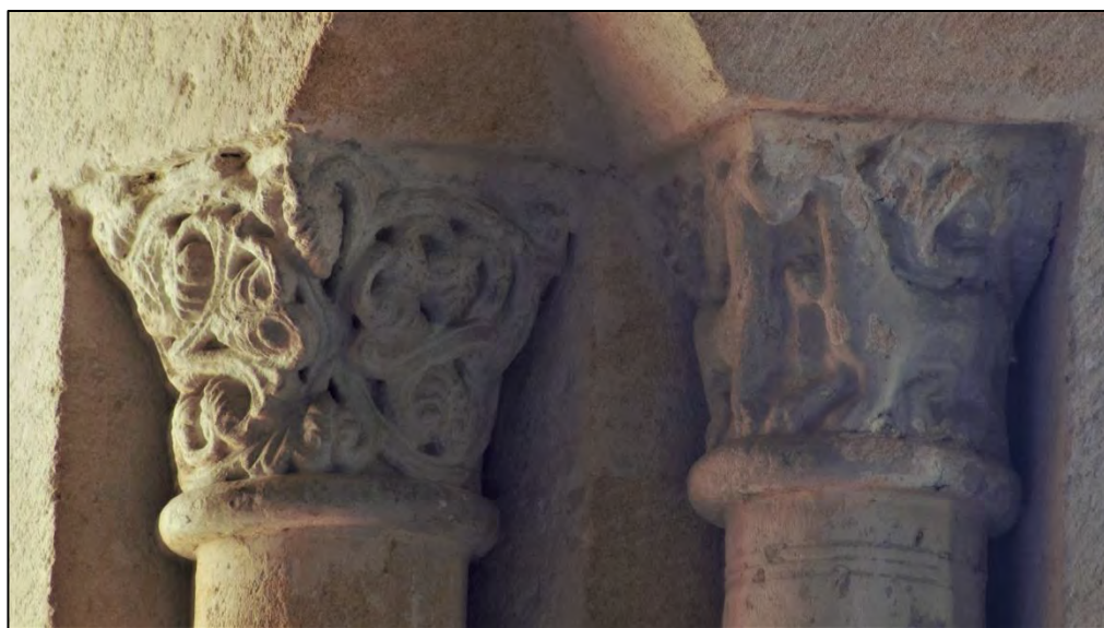
Figure III.4.33 – Chapiteaux de colonnettes situés à l'est de la baie intermédiaire au nord de l'abside.
