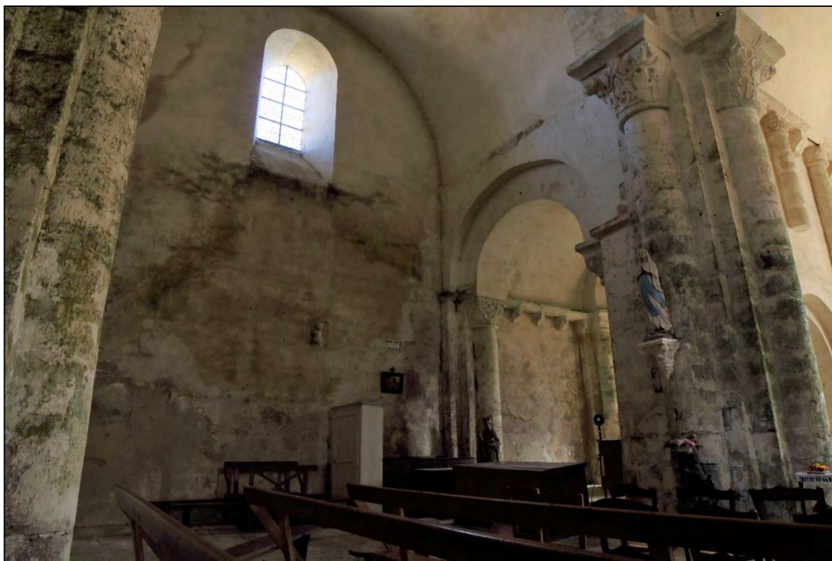
Figure III.3.4 – Vue intérieure du mur pignon du bras nord du transept depuis la croisée du transept.
