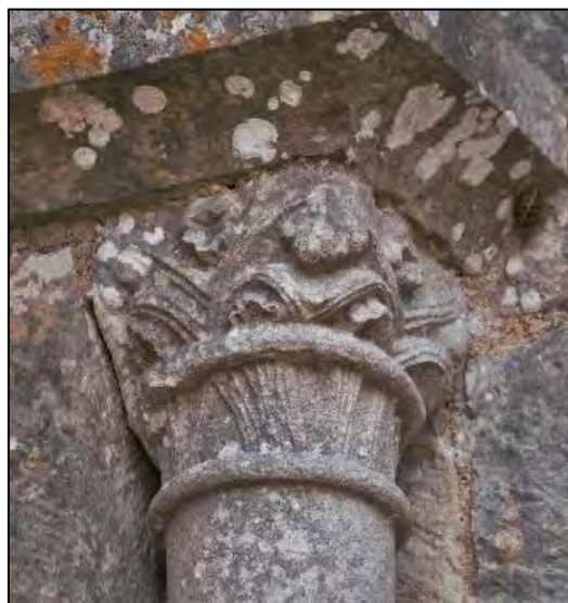
Figure III.6.59 – Chapiteau situé à l'extérieur au nord de la baie nord du mur gouttereau ouest du bras sud du transept.
