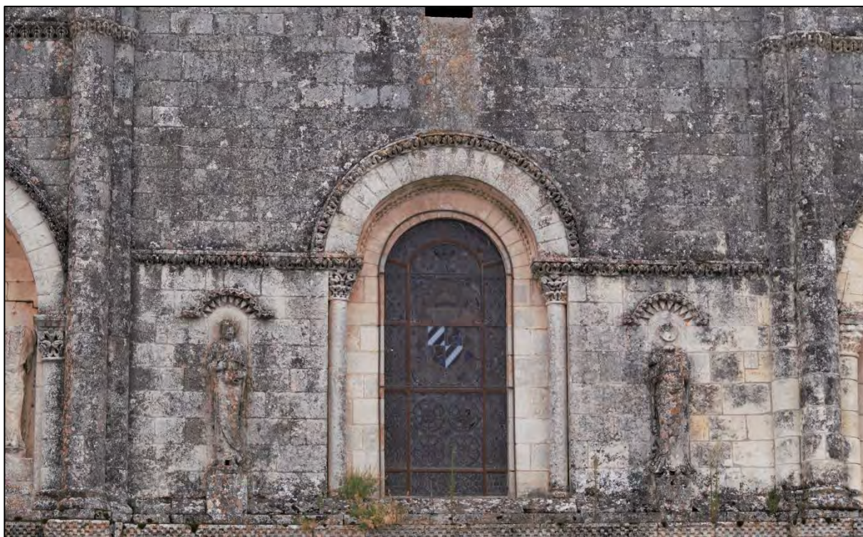
Figure III.5.16 – Façade occidentale, travée centrale, second niveau.
