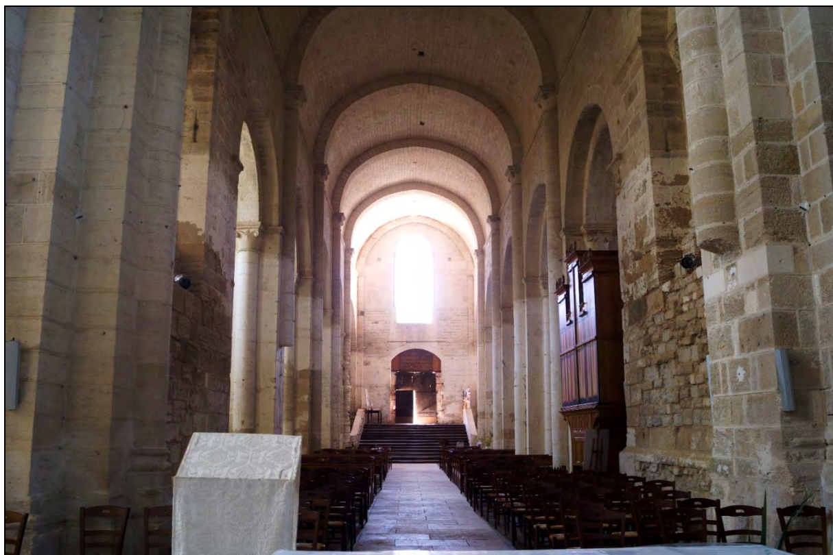
Figure III.8.9 – Vue de la nef vers l'ouest et de l'arcature surmontant les murs bahuts de la travée orientale de la nef.
