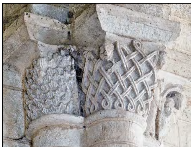
Figure III.7.16 – Vue depuis le nord-est des chapiteaux à l'ouest de la pile composée au sud-ouest de la croisée du transept.
