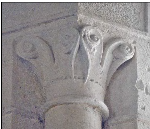
Figure III.2.60 – Chapiteau à l'ouest de la baie au nord-est de la travée avant l'abside.
