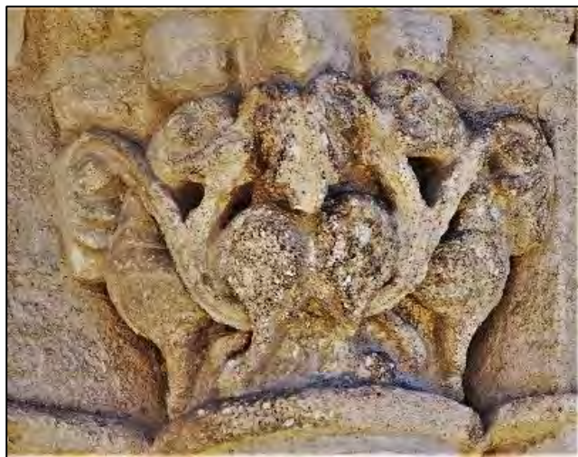
Figure III.8.80 – Chapiteau de colonnette conservé au sud de la façade.
