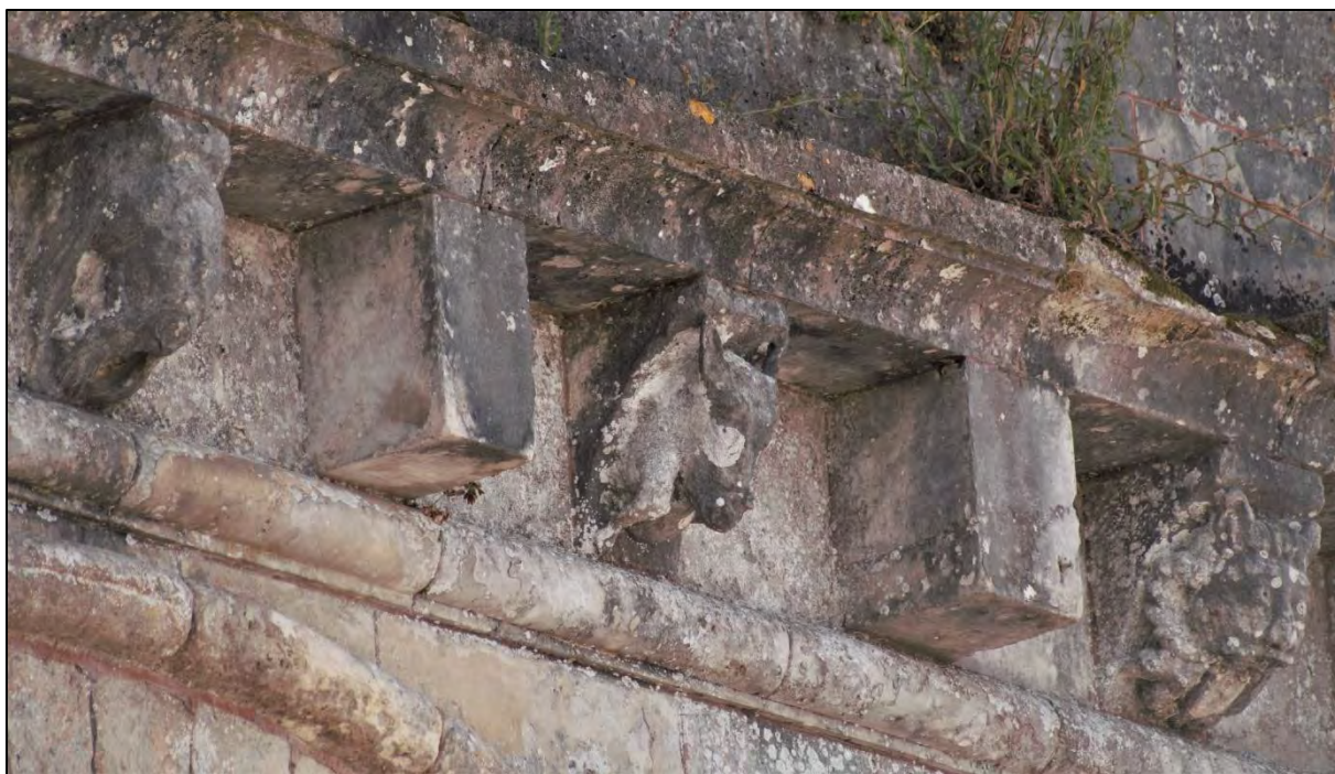
Figure III.5.30 – Modillons conservés et modifiés (blocs) sur la partie occidentale du gouttereau sud.
