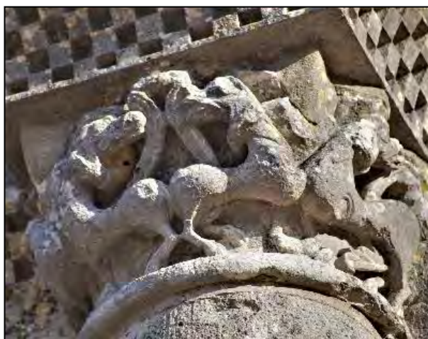
Figure III.8.75 – Chapiteau de colonne engagée au second niveau au nord de la façade.
