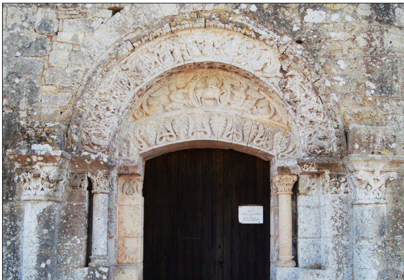
Figure III.6.10 – Portail de la façade occidentale.
