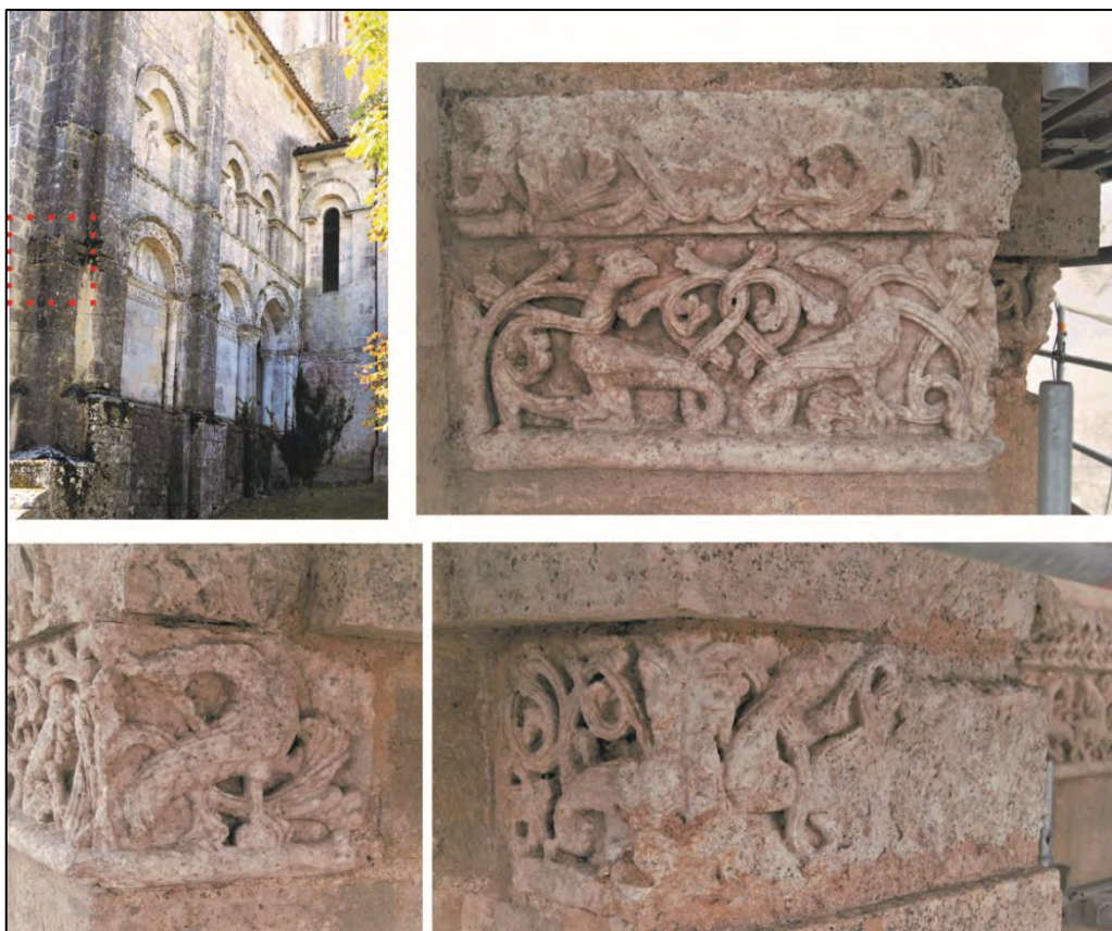
Figure III.8.23 – Éléments de frise à l'extrémité nord du bras du transept.
