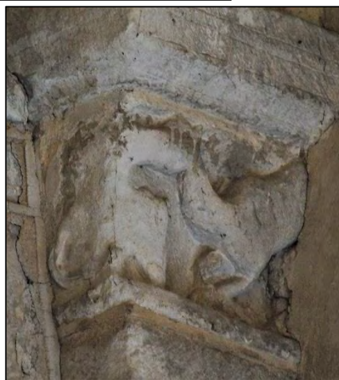
Figure III.7.14 – frise sur le départ du mur occidental de l'ancien bras nord du transept.
