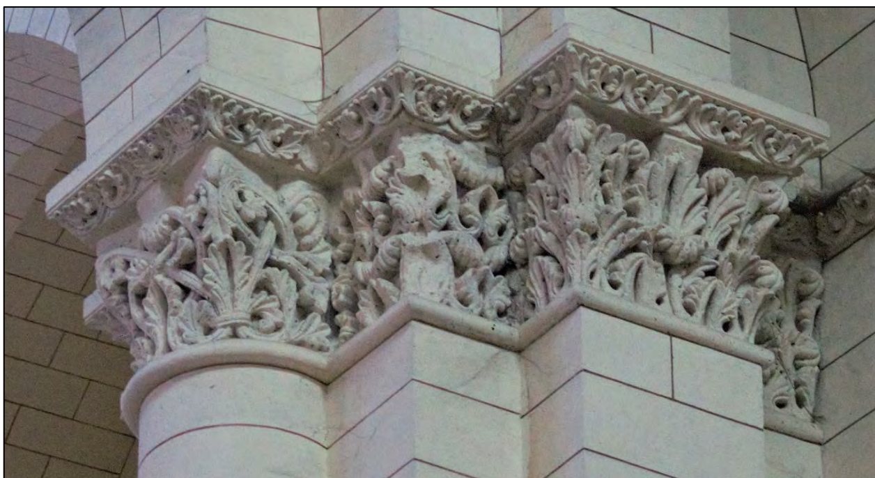
Figure III.1.70 – Chapiteaux continus au sud-est de travée nord du transept.
