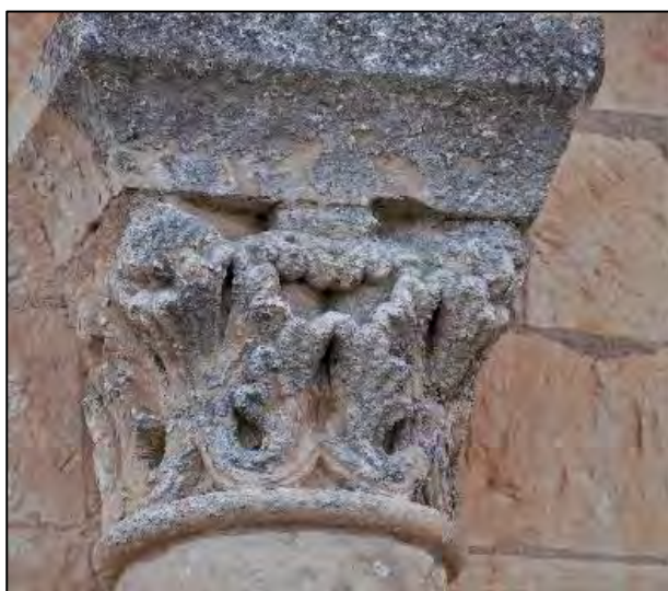
Figure III.6.78 – Chapiteau au nord de la baie axiale du chevet.
