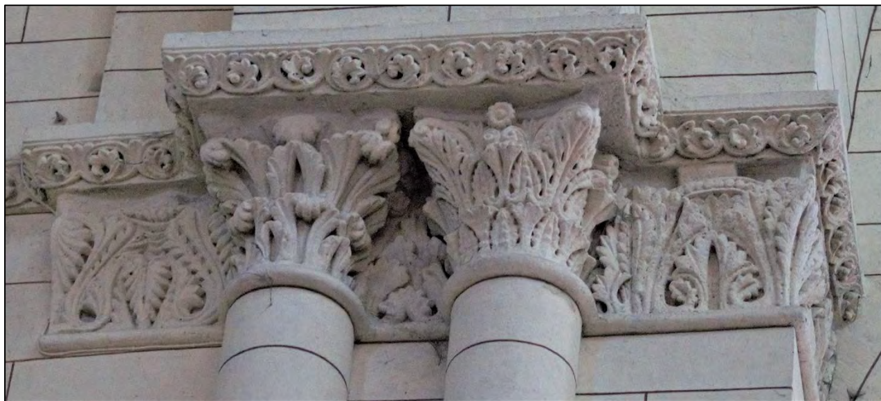
Figure III.1.63 – Chapiteaux continus au sud-ouest de la croisée du transept.
