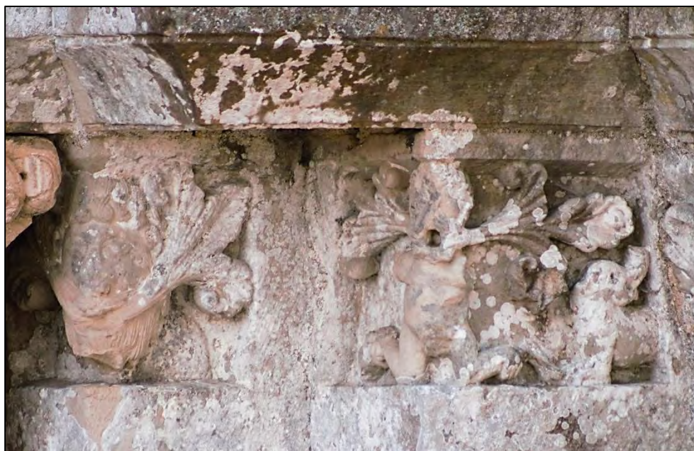
Figure III.6.16 – Façade occidentale, partie sud, extérieur de l'ébrasement du portail.
