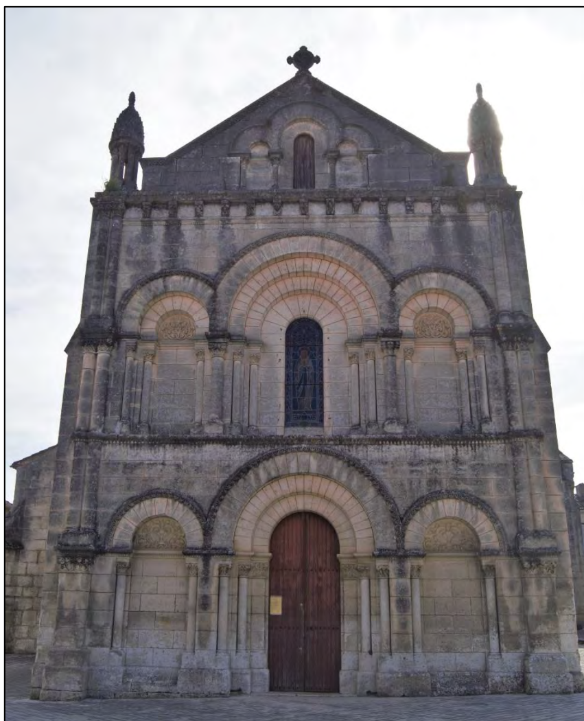
Figure III.4.5 – Vue de la façade occidentale.
