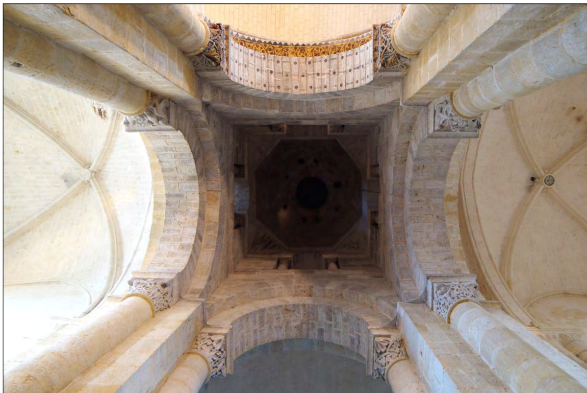
Figure III.2.3 – Vue inférieure de la tour de croisée.
