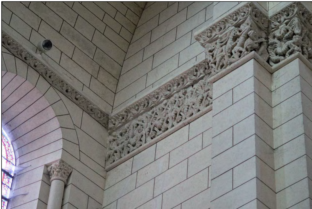
Figure III.1.7– Vue de la jonction entre le mur occidental du transept (à gauche) et la travée nord du transept (à droite).
