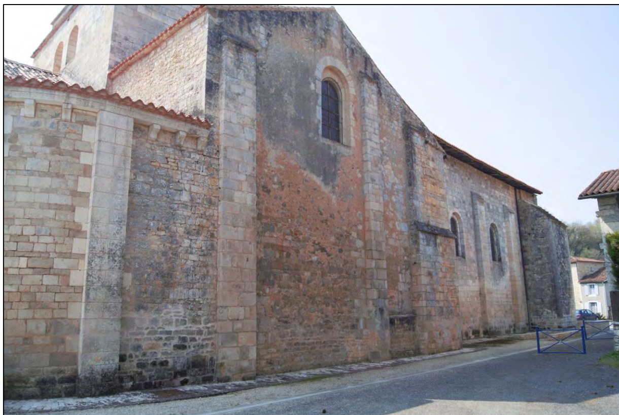
Figure III.3.2 – Vue extérieure du mur gouttereau du bras nord du transept, vers l'ouest.
