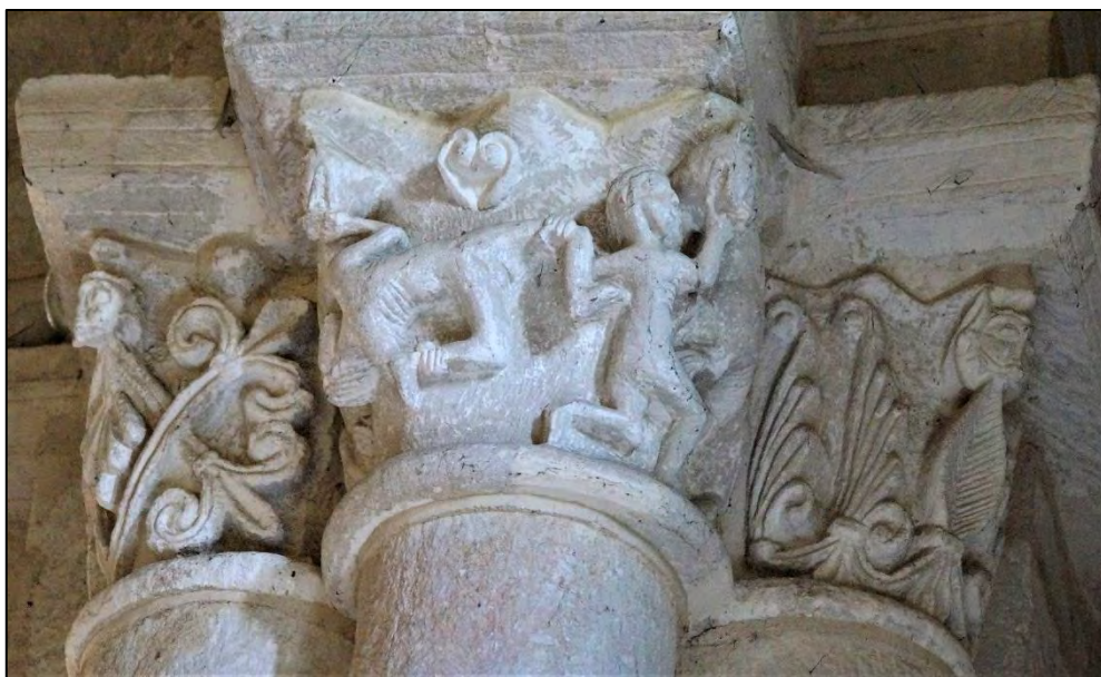
Figure III.7.12 – Vue depuis l'est des chapiteaux de la pile composée au nord-ouest de la croisée du transept.
