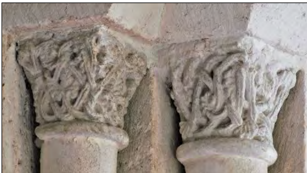
Figure III.4.24 – Chapiteaux de colonnette à l'est du passage nord entre la transept et l'abside, côté abside.
