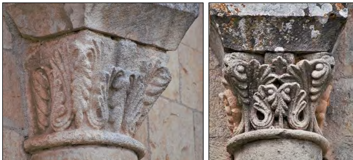
Figure III.6.76 – Chapiteaux à l'extérieur du chevet. À gauche : second chapiteau au nord-ouest. À droite : premier chapiteau au nord-ouest.
