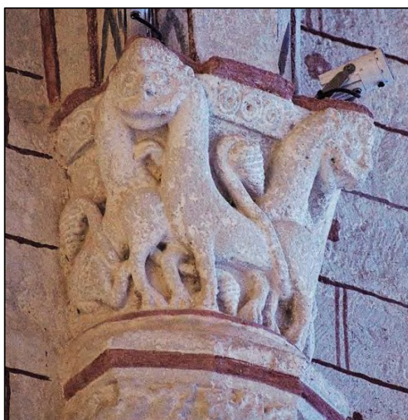
Figure III.8.61 – Chapiteau remployé sur le gouttereau nord du chevet gothique.
