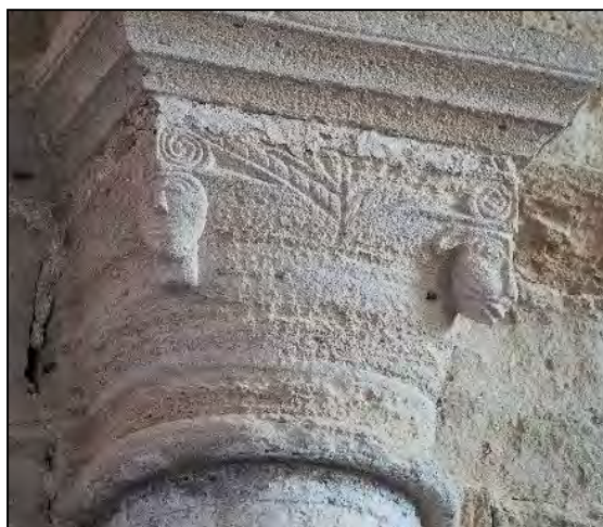
Figure III.8.100 – Chapiteau situé à l'est de la première pile au sud de la nef.
