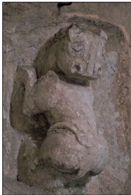
Figure III.3.50 – Modillon conservé dans le mur pignon du bras nord du transept.
