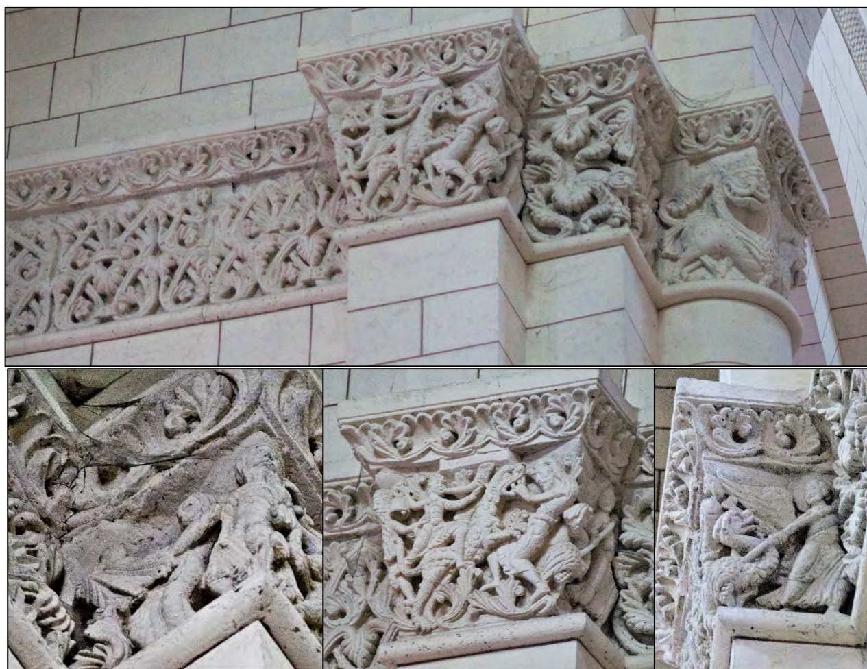
Figure III.1.69 – Cathédrale d'Angoulême. En haut : partie occidentale de l'arc triomphal ouvrant sur la chapelle du bras nord du transept. En bas : détails du chapiteau de pilastre. La face occidentale (à gauche) est presque contre le mur.
