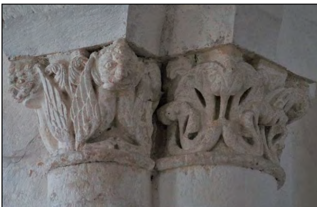
Figure III.6.63 – Chapiteaux à l'ouest et au nord de la pile composée au sud-est de la croisée du transept.
