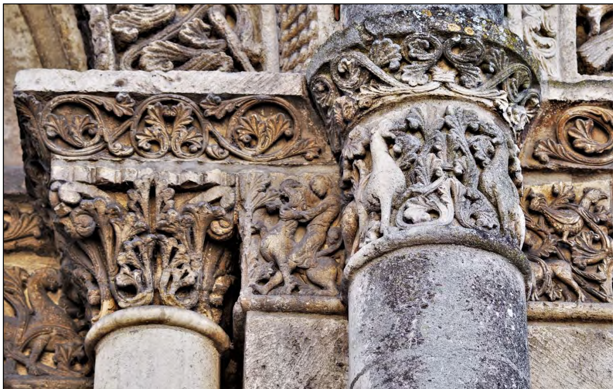
Figure III.1.23 – Frise, chapiteau, ligne d'imposte, voussures et archivoltas à l'interface entre les deux tympanes au nord du rez-de-chaussée de la façade occidentale.
