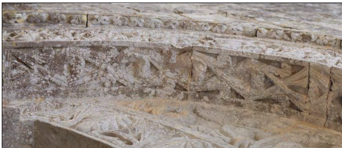
Figure III.6.13 – Façade occidentale, intrados de la voussure du portail.
