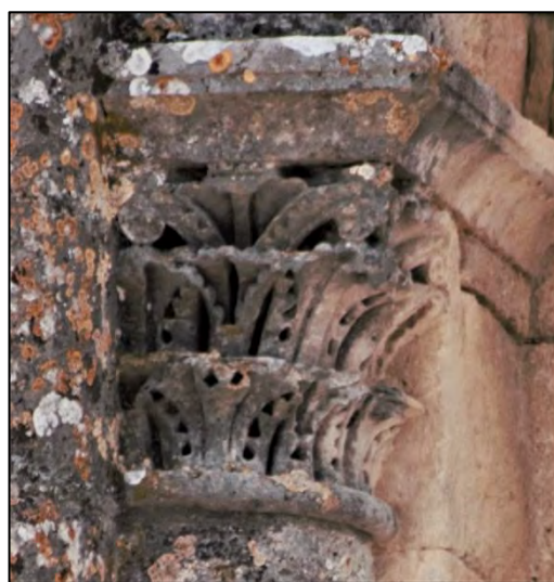
Figure III.5.21 – Chapiteau au nord de la travée nord du second niveau.
