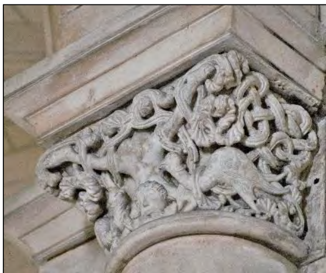
Figure III.5.55 – Chapiteau à l'est de l'arc ouvrant sur la travée sud du bras sud du transept.
