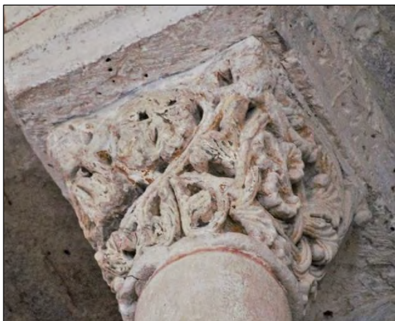
Figure III.2.17 – Chapiteau au centre de la baie gémisée en plein-cintre. Vue sud-ouest.
