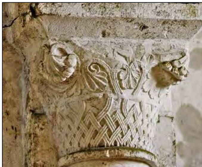
Figure III.3.21 – Chapiteau de la colonne engagée à l'ouest de la pile nord-est de la croisée du transept.
