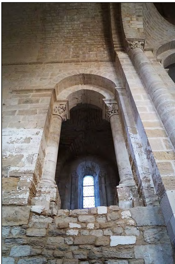
Figure III.8.10 – Vue de l'arcade surmontant le mur bahuts au nord de la sixième travée de la nef centrale.
