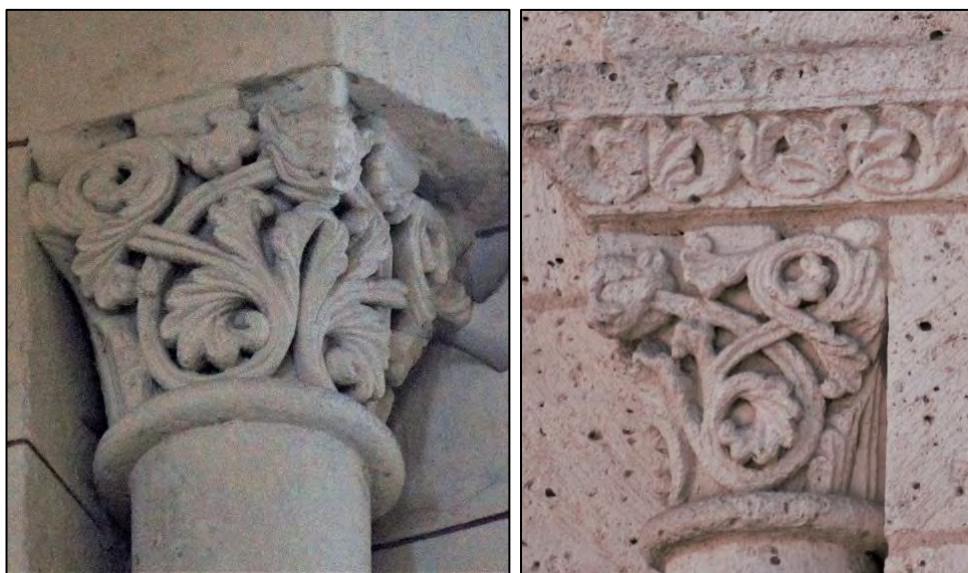
Figure III.1.62 – Chapiteau d'encadrement des baies de la nef. À gauche : chapiteau à l'ouest à l'intérieur de la première baie de la troisième travée. À droite : chapiteau à l'ouest à l'intérieur de la première baie de la troisième travée.
