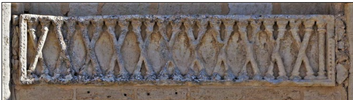
Figure III.8.86 – Plaque de chancel remployée dans l'arcature nord de la façade.
