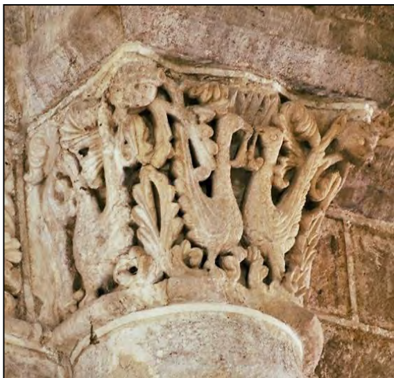
Figure III.8.46 – Chapiteau nord de la pile sud-ouest de la croisée sous coupole.
