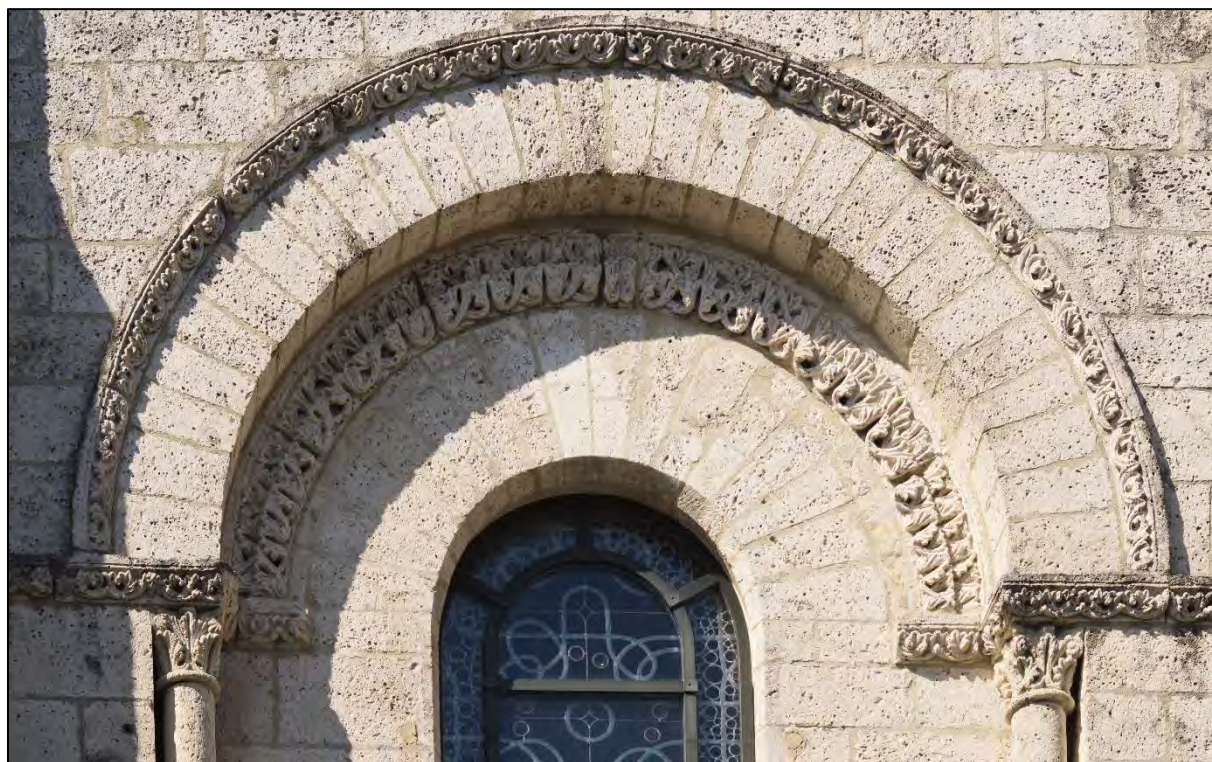
Figure III.1.67 – Baie au sud du bras sud du transept.
