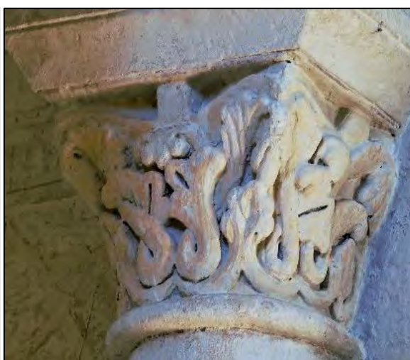
Figure III.4.17 – Chapiteau au nord du passage sud-ouest.
