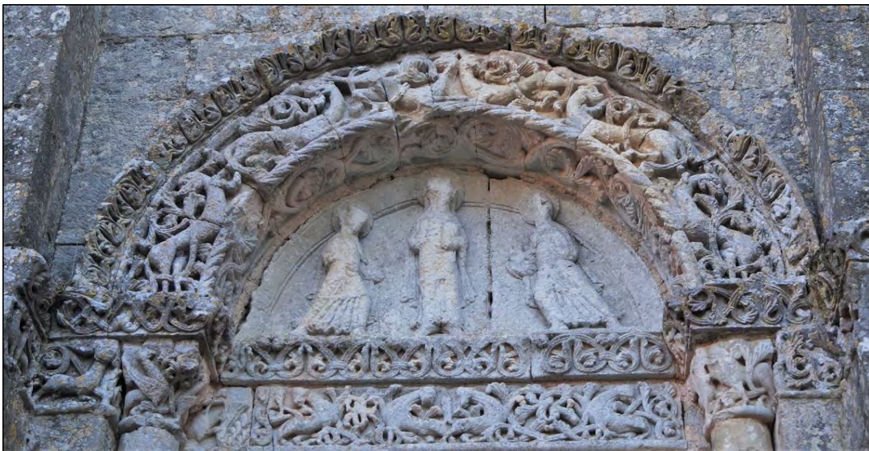
Figure III.8.18 – Vue en contreplongée de l’arcature au nord de la façade du transept.
