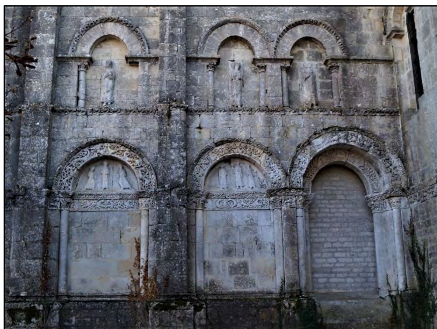
Figure III.8.14 – Face occidentale du bras de transept nord de l'abbaye Saint-Amant.
