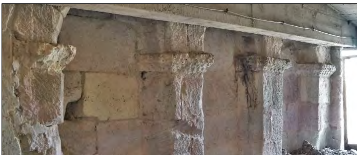
Figure III.2.30– Troisième niveau du clocher, pris dans les combles de la charpente actuelle.
