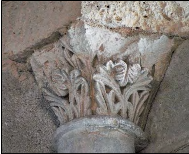
Figure III.2.66 – Chapiteau à l'ouest de la baie nord-ouest
