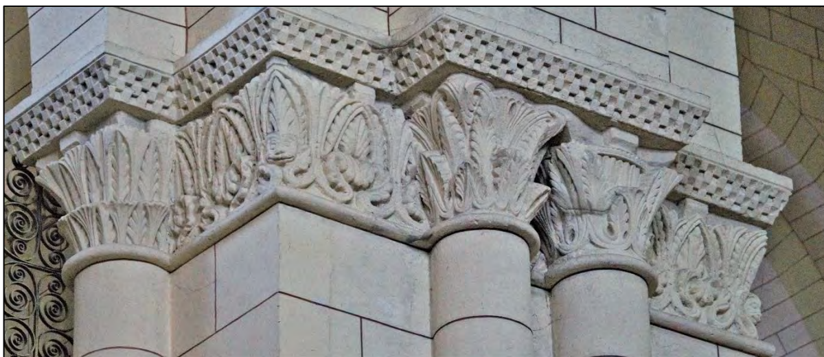
Figure III.1.51 – Chapiteaux continus et tailloirs de la pile au nord-est de la nef.
