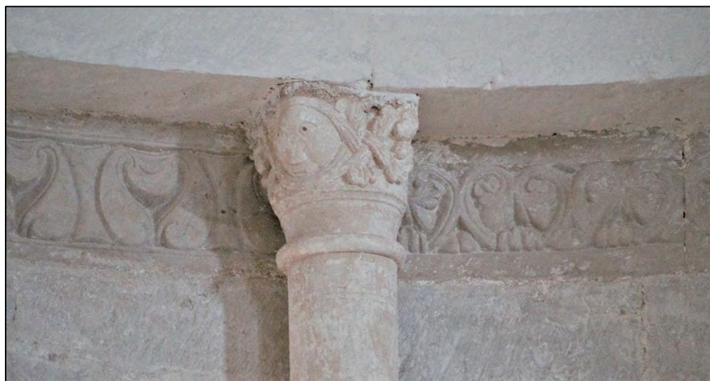
Figure III.6.52 – Chapiteau et frises au sud de la baie de l'absidiole orientée du bras sud du transept.
