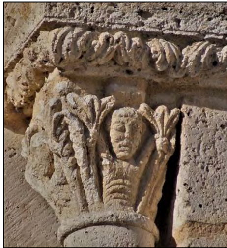
Figure III.1.90 – Chapiteau et tailloir au nord-est de l'abside.
