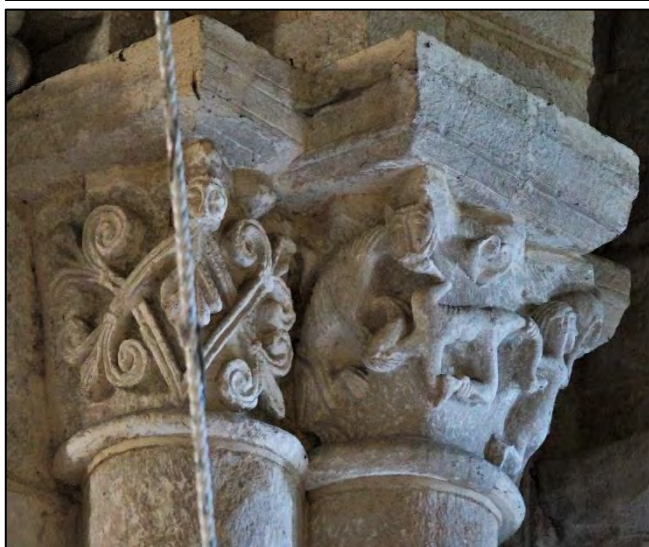
Figure III.7.13 – Vue depuis le sud-est des chapiteaux à l'est de la pile composée au nord-ouest de la croisée du transept.
