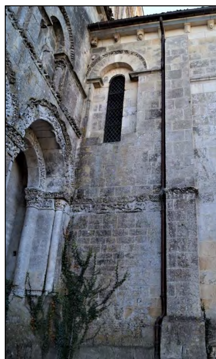
Figure III.8.13 – Jonction entre la face occidentale du bras de transept nord et le gouttereau nord de la nef.
