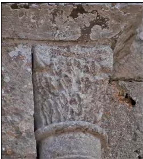
Figure III.6.58 – Chapiteau situé à l'extérieur au nord de la baie sud du mur gouttereau ouest du bras sud du transept.
