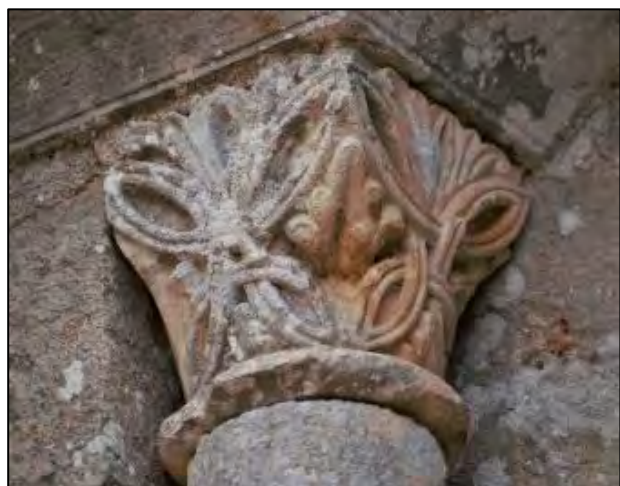
Figure III.6.41 – Chapiteau situé à l'extérieur à l'ouest de la seconde baie à l'ouest de la nef.
