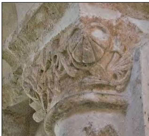
Figure III.3.36 – Chapiteau de la colonne engagée au sud de l’arc en plein-cintre ouvrant sur l’absidiole orientée nord.
