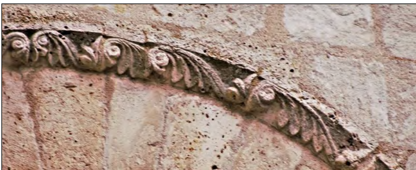
Figure III.2.52 – Archivolt à l'extérieur de la travée droite de chœur.
