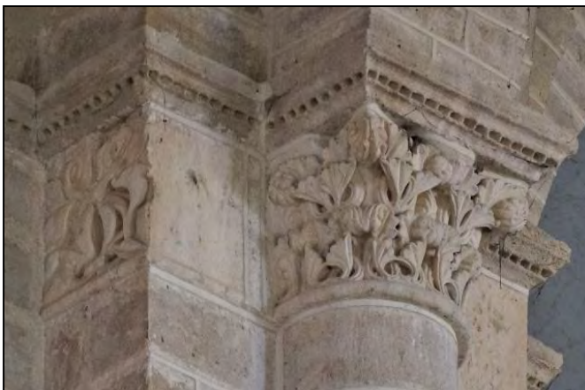
Figure III.8.42 – Chapiteau au sud de la pile nord-ouest de la croisée sous coupole.
