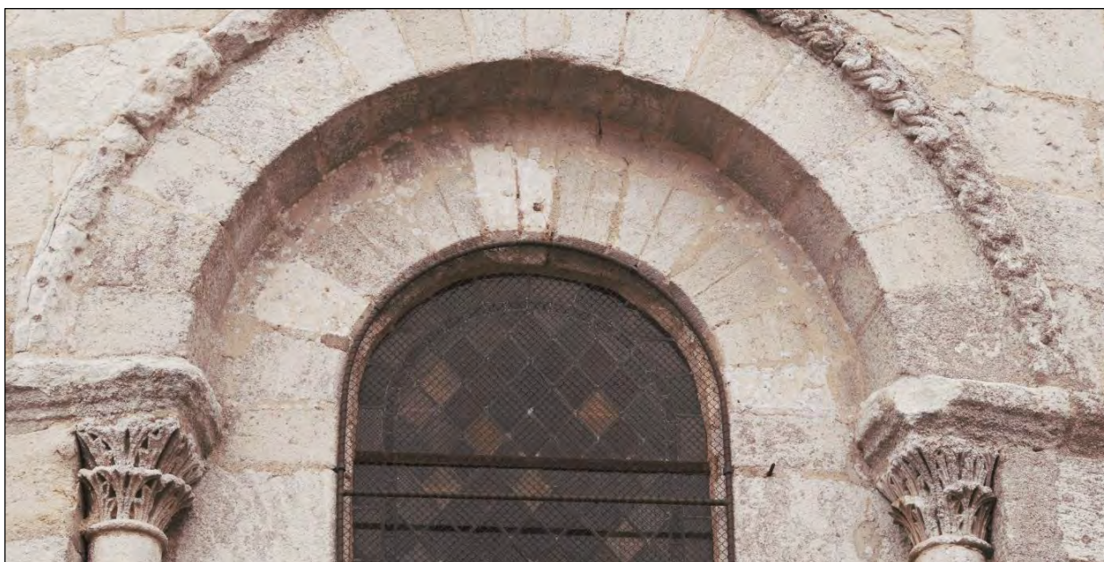
Figure III.2.74– Baie axiale, à l'extérieur du chevet.
