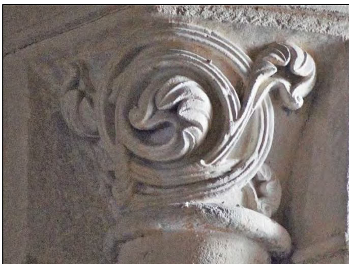
Figure III.2.61 – Chapiteau à l'est de la baie au sud-est de la travée avant l'abside.
