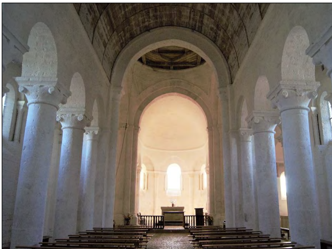
Figure III.6.3 – Vue de la nef depuis l'est.
