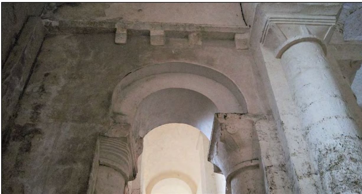
Figure III.3.40 – Bras sud du transept, vue en direction de la nef.
