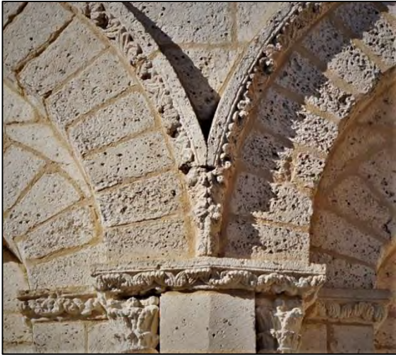
Figure III.1.89 – Chapiteaux tailloirs, lignes d'impostes et archivoltas à l'est de l'abside.
