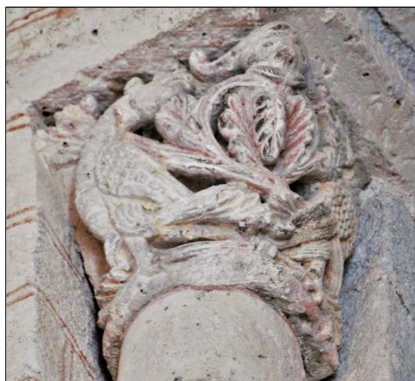
Figure III.2.20 – Chapiteau au nord de la baie gémisée, partie extérieure de la face occidentale de la tour.
