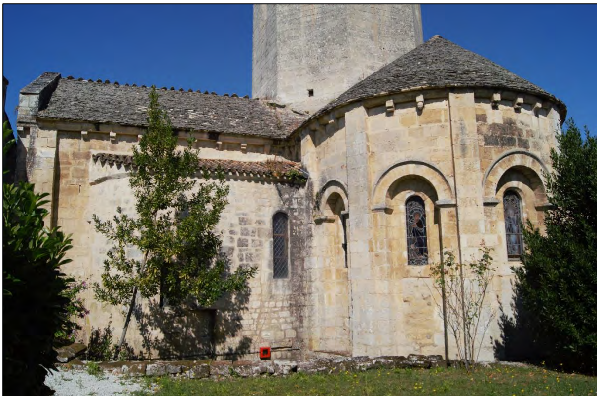
Figure III.4.4 – Vue du chevet depuis le sud-est.
