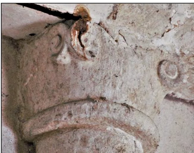
Figure III.3.31 – Chapiteau de la colonne engagée au nord de l'abside.
