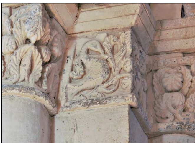
Figure III.4.15 – Plaques de la pile sud-ouest de la croisée du transept.
