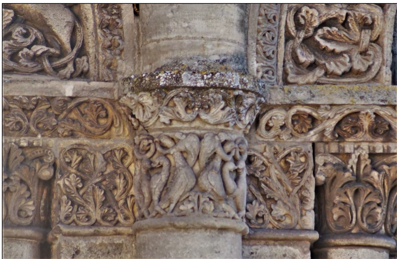
Figure III.1.24 – Frise, chapiteau, ligne d'imposte, voussures et archivoltas à l'interface entre les deux tympanes au sud de la façade occidentale.
