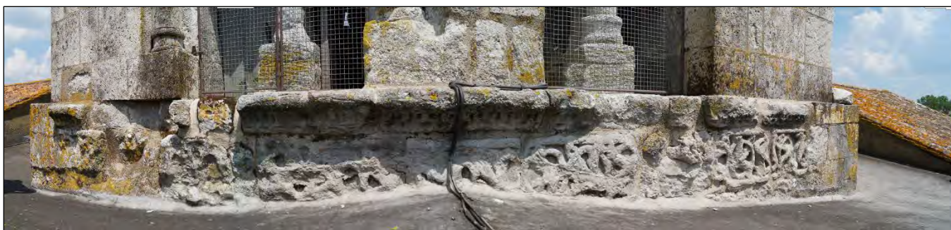
Figure III.2.31 – Troisième niveau du clocher, face orientale du clocher, frise
