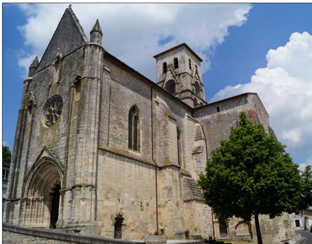
Figure III.2.4 – Vue générale depuis le sud- est.
