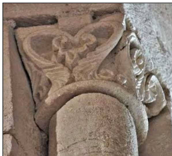
Figure III.8.109 – Chapiteau situé à l'ouest de la baie de la seconde travée du collatéral nord de la nef.
