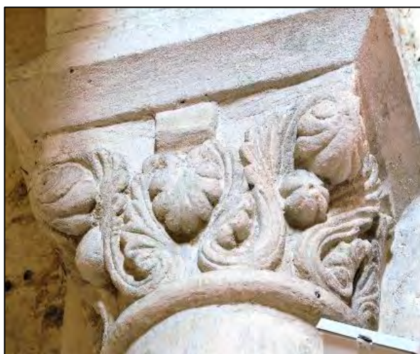
Figure III.4.16 – Chapiteau au sud du passage sud-ouest.
