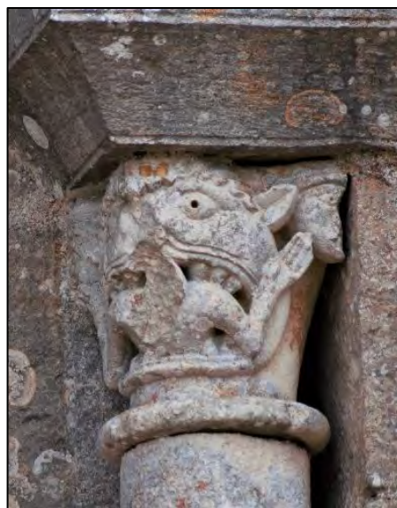
Figure III.6.40 – Chapiteau situé à l'extérieur à l'est de la première baie à l'ouest de la nef.
