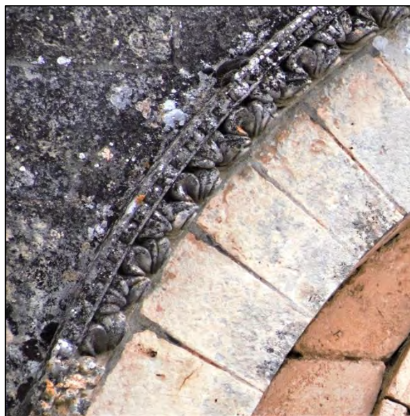
Figure III.5.25 – Ligne d'archivolte de l'arc de la travée au nord du second niveau.
