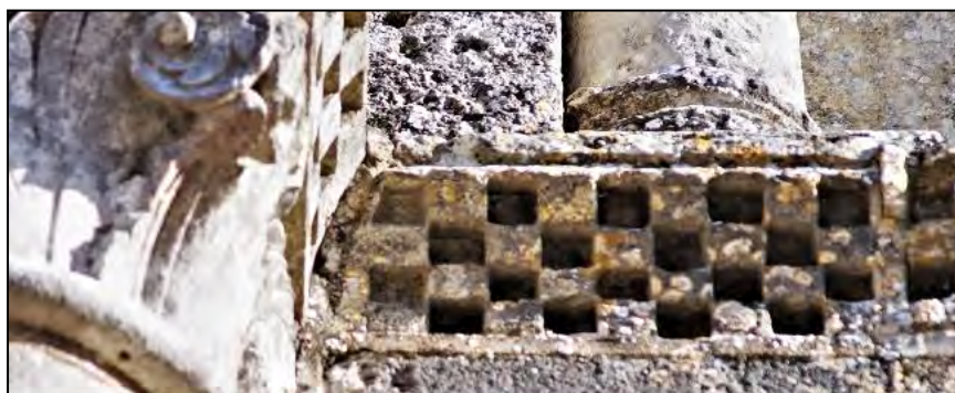
Figure III.8.70 – Ligne d'imposte continue entre les deux niveaux de la façade.
