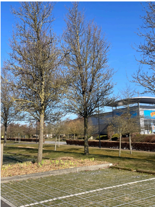
Places de stationnement perméables et végétalisées dans la ZAC du Mesnil Roux
