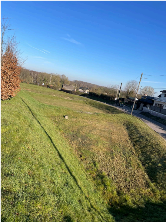
Bassins d'infiltration des eaux pluviales aux Campeaux
