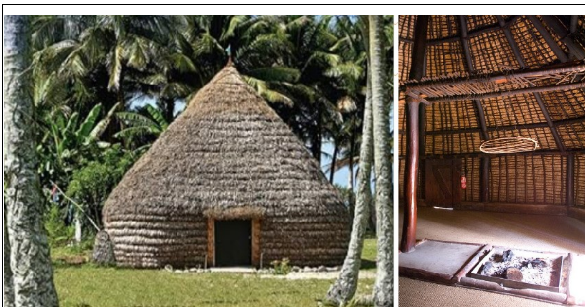
Illustration 5: Case traditionnelle Kanak vue de l'extérieur (à gauche) et vue de l'intérieur à droite avec un foyer dans lequel on allume un feu pour d'abord entretenir la paille qui la couvre, puis pour se réchauffer.
