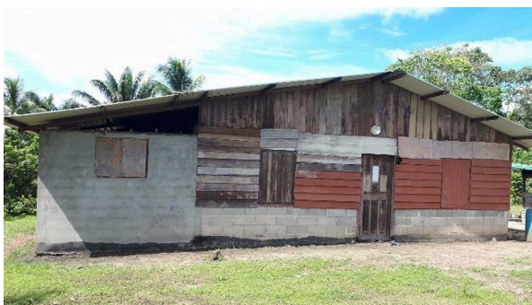
Figure 10. Vue d'une extension de maison. Source : David Guyot, 2022, Rapport de synthèse
