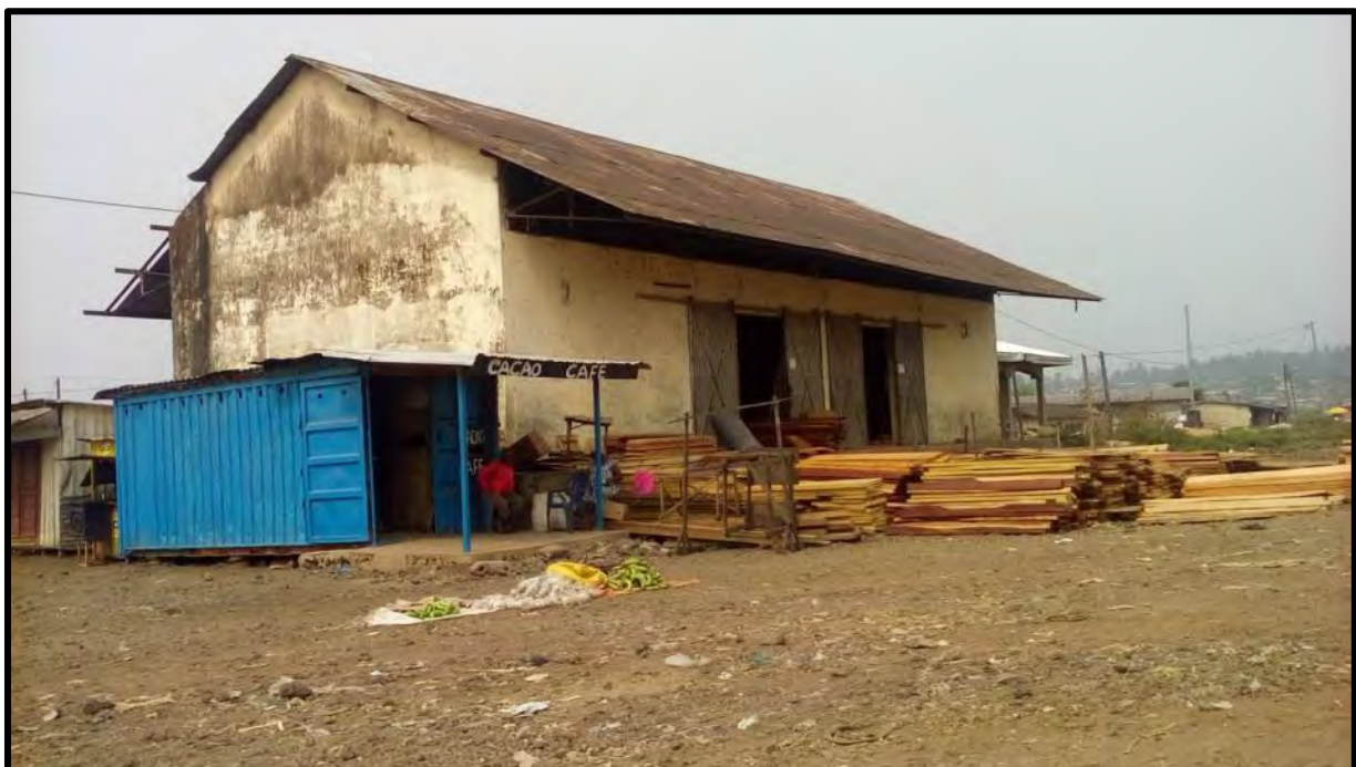
Photographie 1. Un entrepôt ferroviaire appartenant à l'ancienne gare de Manjo. Le rail a été démantelé en 1991 en raison de sa vétusté. Le bâtiment est aujourd'hui utilisé pour stocker des planches (Source : Cliché de l'auteur, février 2016).
