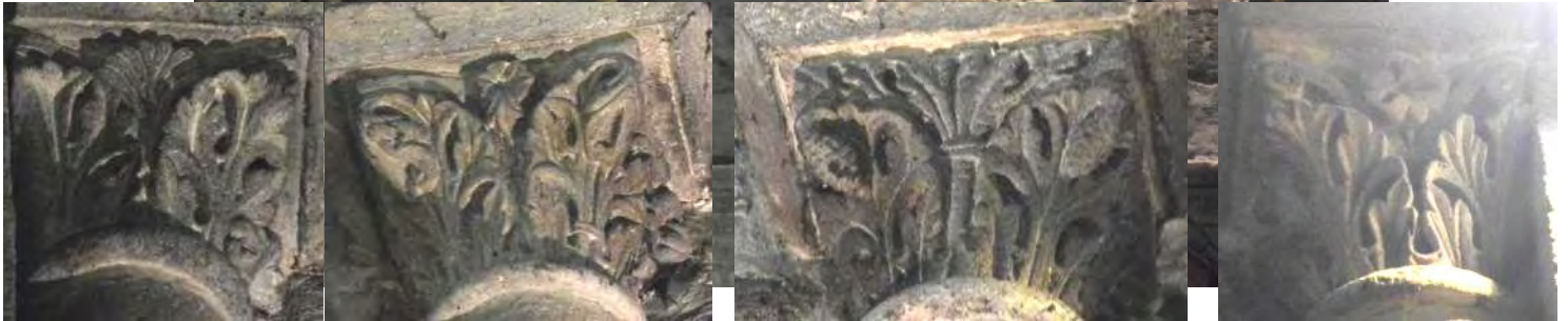
:Mur sud du bras sud
