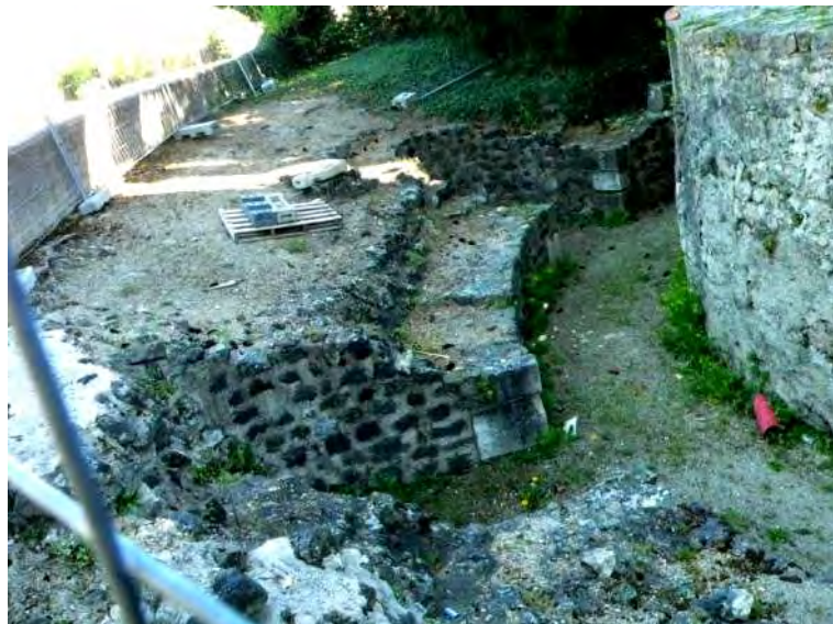
Fig. 52 : Ancien déambulatoire visible à l'extérieur
