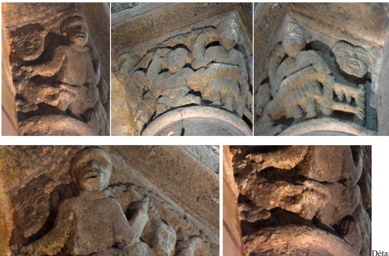
Fig. 224 : StrN : Pilier sud, chapiteau orienté au nord
