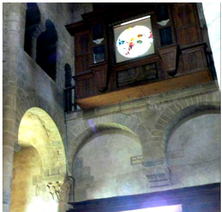
Fig. 42 : Mur intérieur ouest
