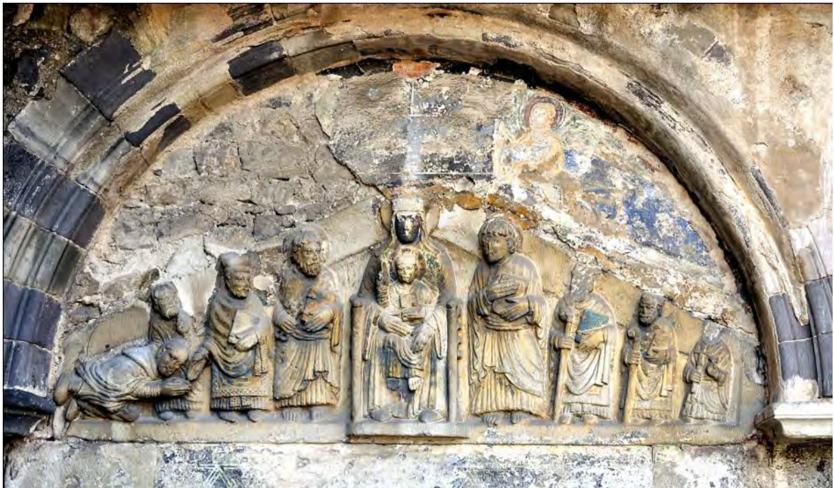
Fig. 423 : Linteau de l'entrée du cloître
