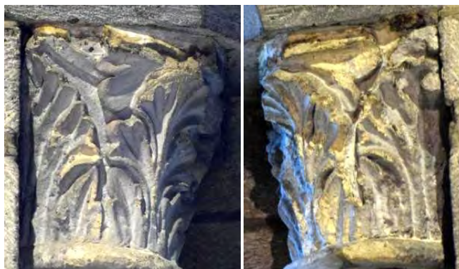
Fig. 222 : Chapelles des bras du transept
