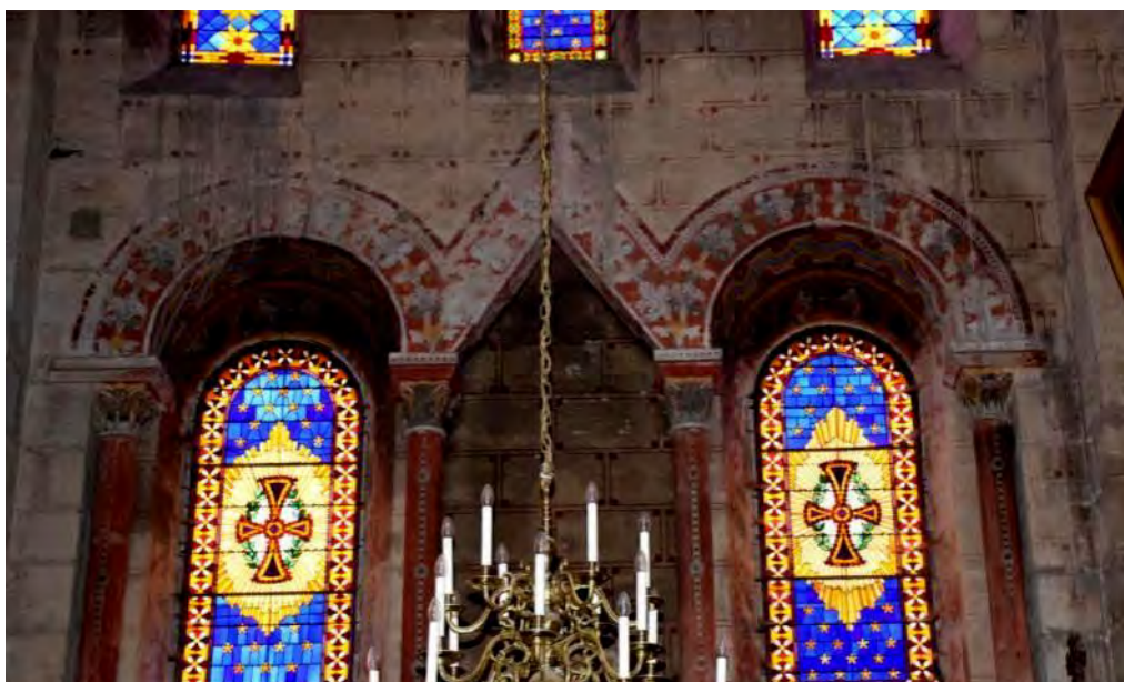
Fig. 233 :Mur des bras du transept
