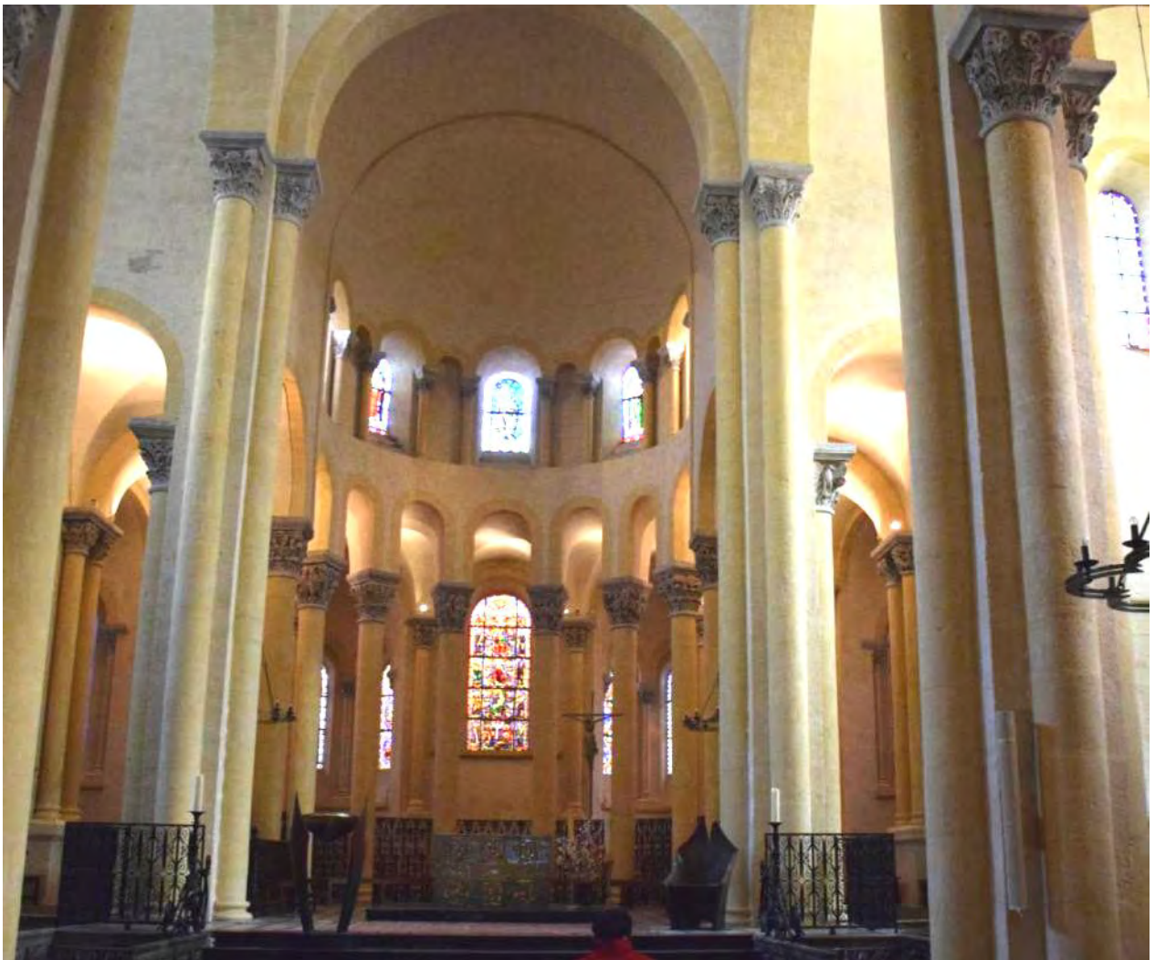
Fig.12 : Vue d'ensemble du chœur
