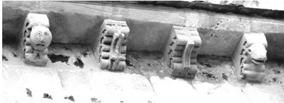
Transept nord, côté est
