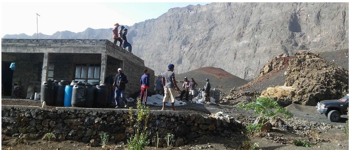
Figure 8.11. Construction d'une maison en béton (novembre 2016 ; Pedro Danilo Fontes).
