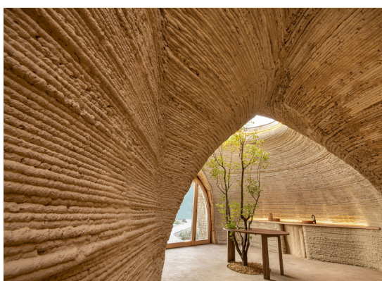
FIGURE 54 (GAUCHE HAUT ET BAS) — Massimo Morretti, photos du projet de maison « Tecla », impression 3D en terre, 2021, Italie
