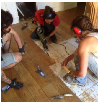
Figure 17 : Test de décollage à la scie-sabre
