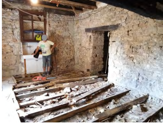
Figure 28 : Démolition du sol d'origine
