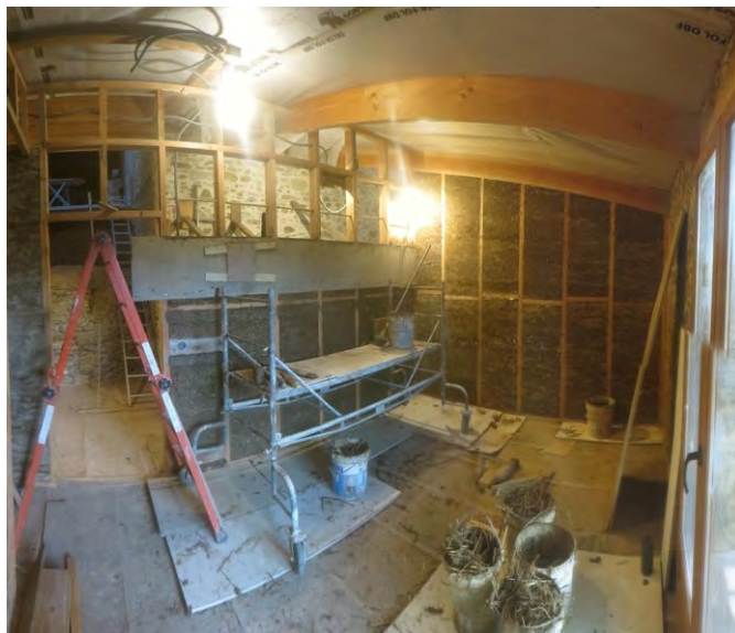
Figure 21 : Cloison en terre-paille, seaux de mélange et échafaudage
