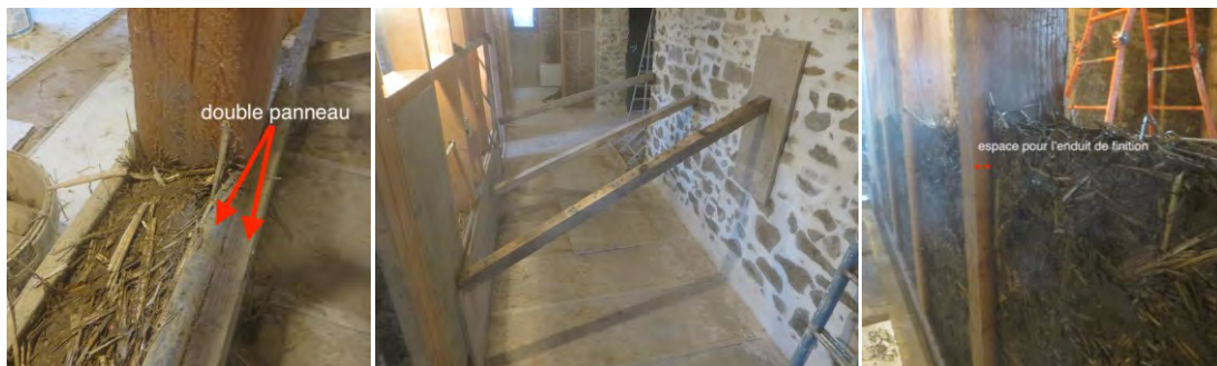
Figure 20 : Banchage de la cloison
