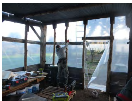
Figure 13 : Construction de l'auvent
