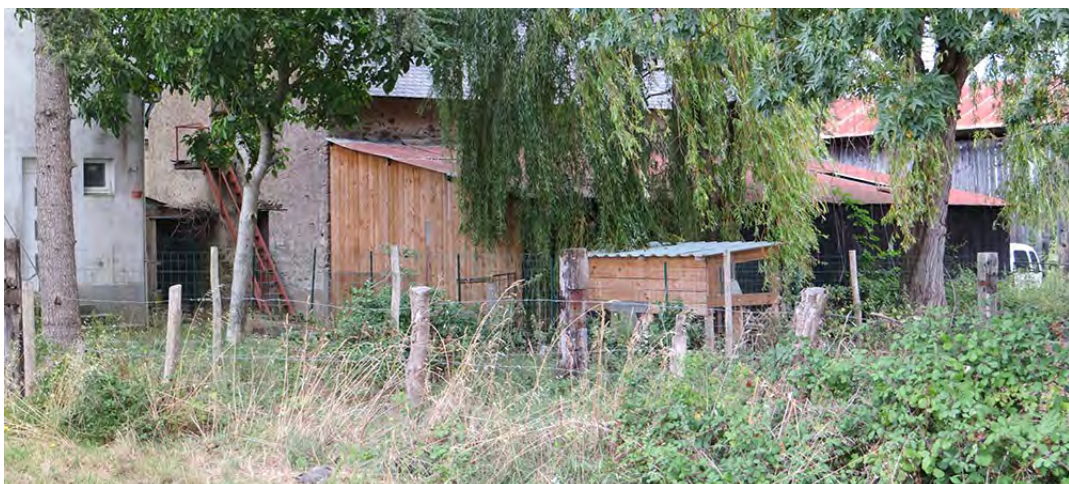
Figure 6 : Appentis avant démolition – Source image : blog des autorénovateurs
