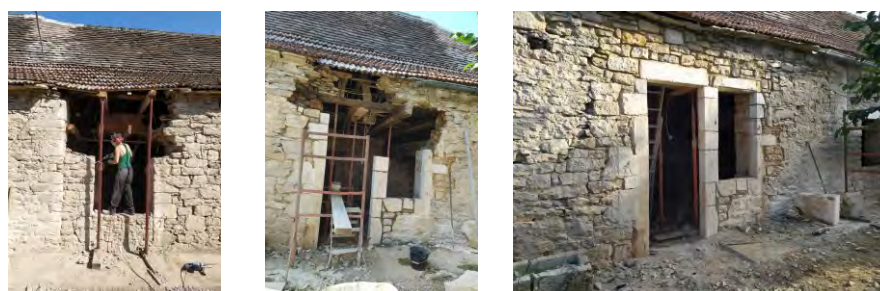
Figure 27 : Création d'ouvertures vers l'extérieur
