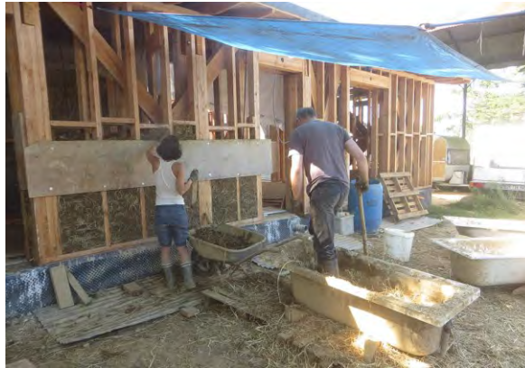
Figure 10 : Pose du terre-paille (mur extérieur)
