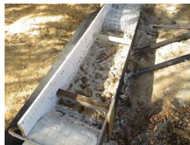
Figure 9 : Fondations cyclopéennes
