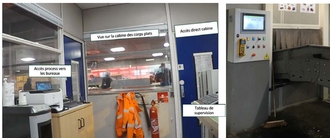
Figure 58. À gauche, photographie depuis la cabine de supervision du CDT B, à droite, photographie de l'écran de supervision (IHM) situé en cabine de tri CDT C
