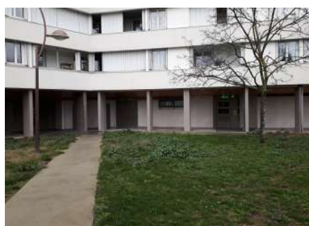
Coursive au RDC
