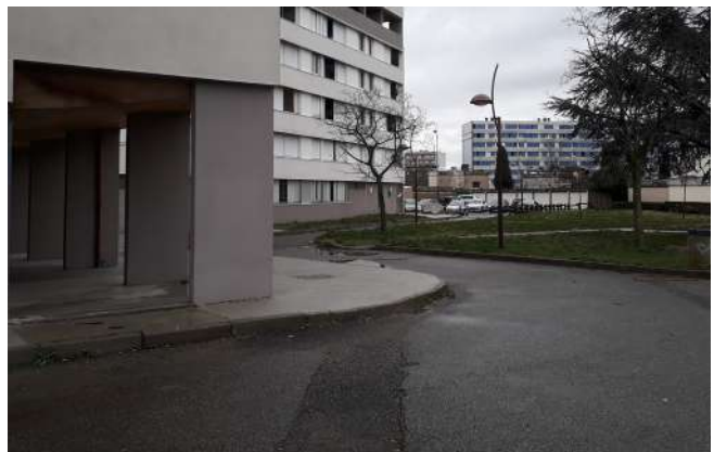
Voie pompier et aire de retournement au Sud
