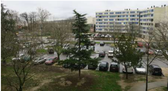
Parking de 65 places côté chemin de Lestang
