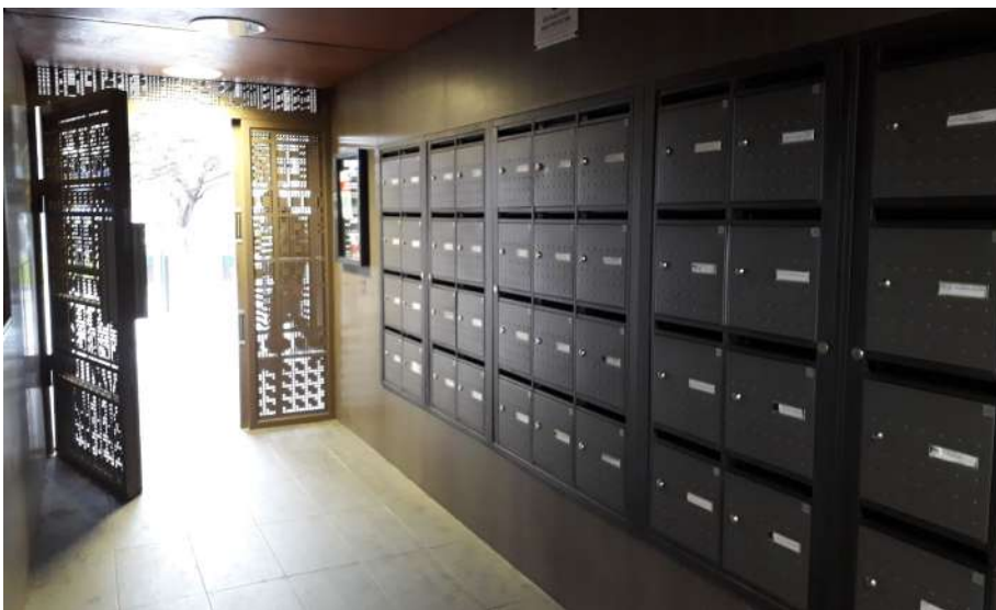
Intégration des boîtes à lettres
