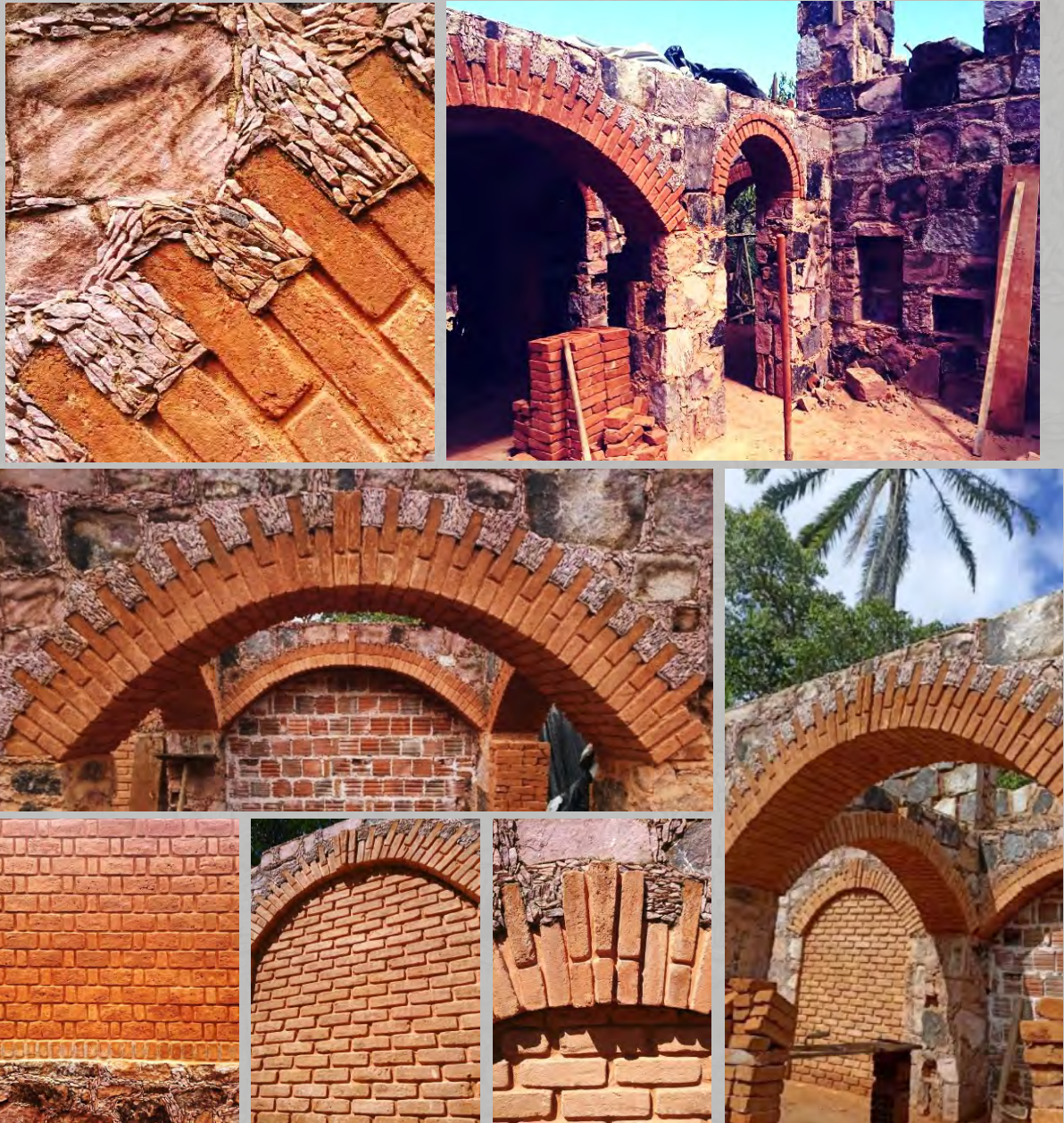
De divers angles du chantier d'une maison particulière, à Bahia, 2022.
