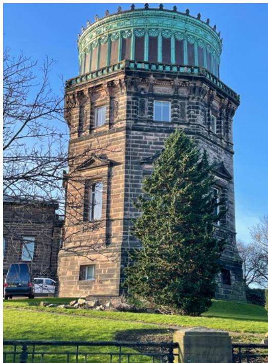
Figure 11 Photo de l'Observatoire Royal d'Édimbourg
