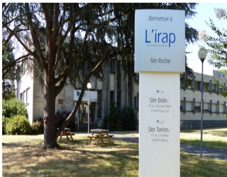
Figure 8 L'IRAP, site Roche à Toulouse 29
