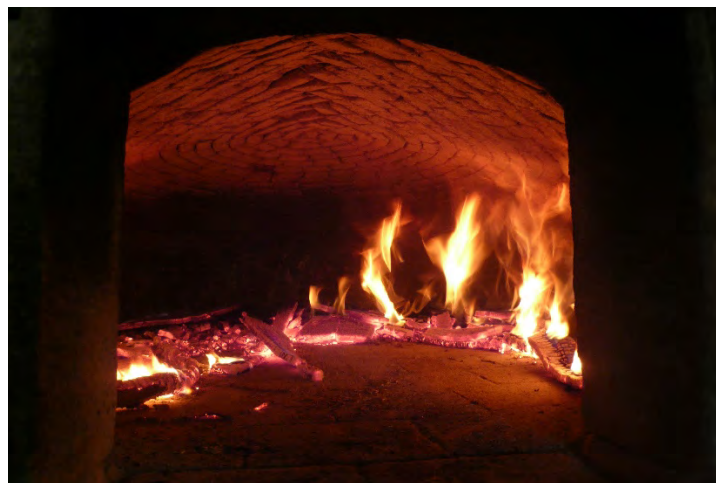
Illustration 4 – Four bâti à chauffe directe ; C. Barbier
