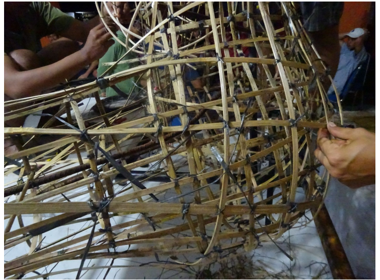
Illustration 47: Maillage de la structure en bambou 2 - 31/01/23
