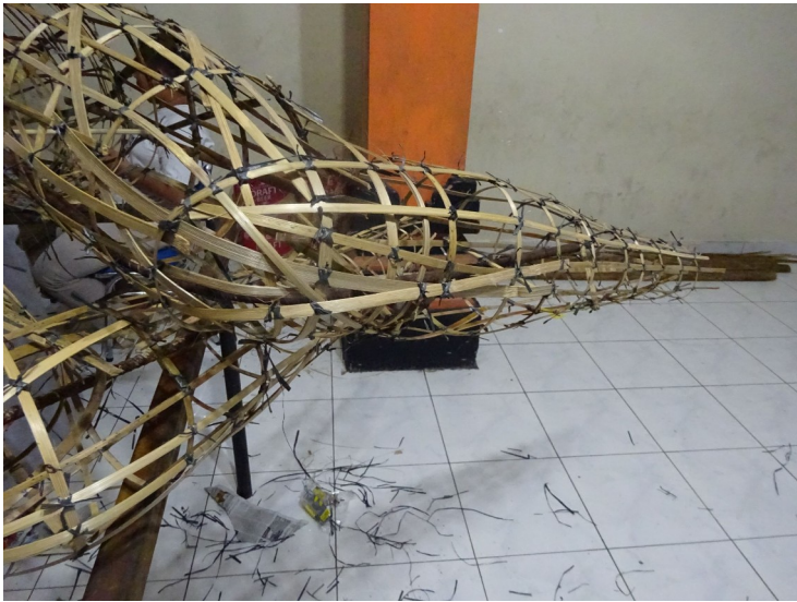
Illustration 46: Maillage de la structure en bambou - 31/01/23
