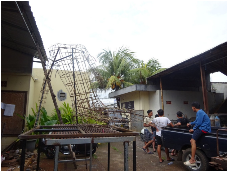
Illustration 42: Renforcement de la structure en métal - 30/01/23
