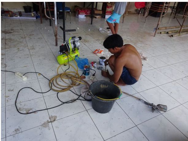
Illustration 102: Préparation de l'imperméabilisant - 09/03/23
