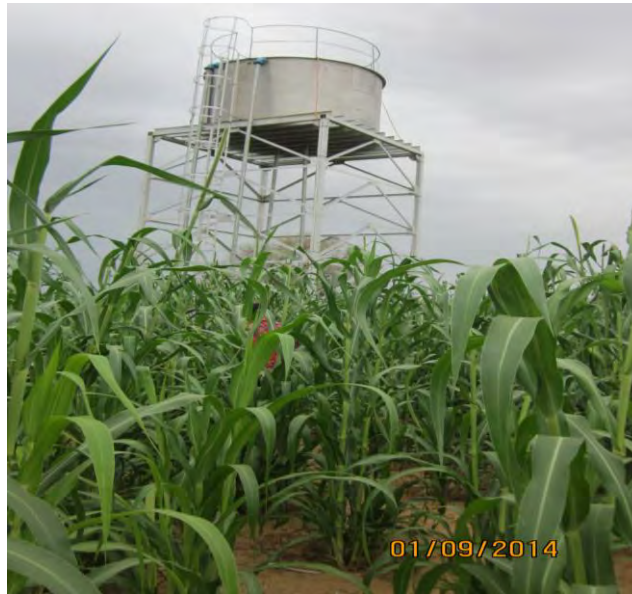
Photo 84 : la mini adduction d'eau potable de Doumba
