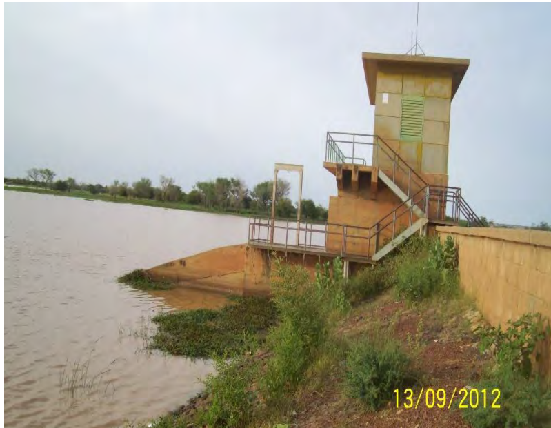
Photo 24 : le barrage-réservoir de Téra
