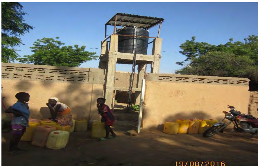
Photo 72 : un poste d'eau autonome construit par Moussa Morey dans le quartier Foutankaira, (ville de Téra)
