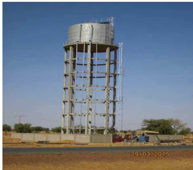
Photo 83 : le château d'un système multi villages dans la commune rurale de Dargol
