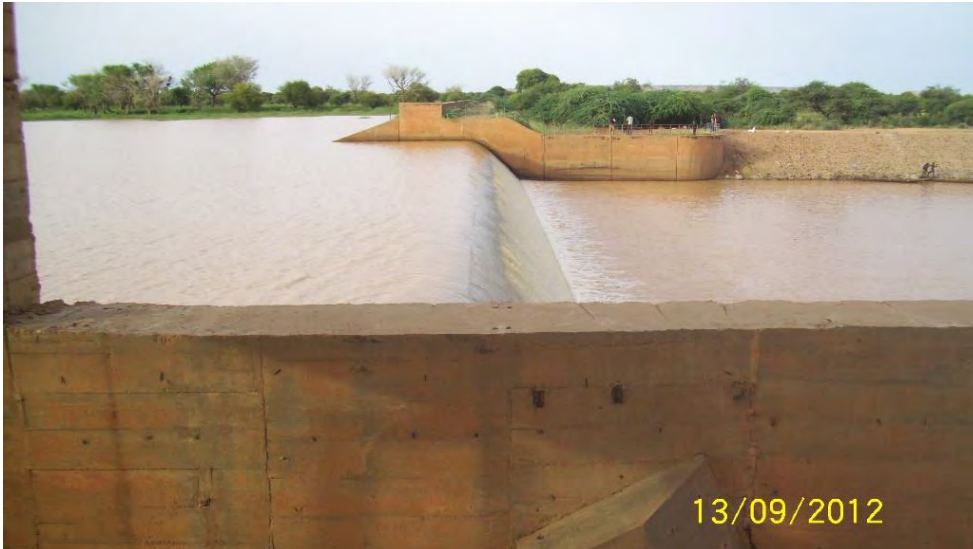
Photo 14 : le barrage-réservoir sur le Dargol à Téra, un exemple d'ouvrage de maîtrise de l'eau Source : Moussa Yayé, 2012
