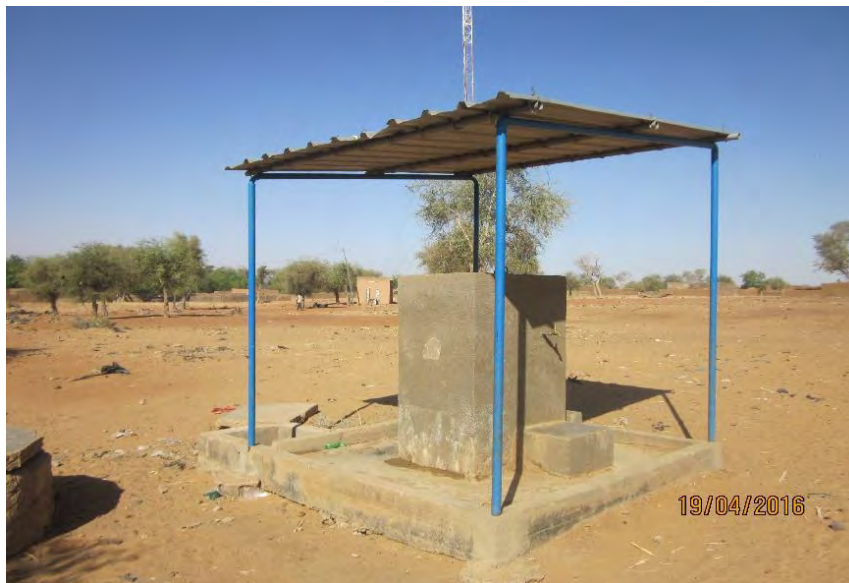
Photo 89 : une des 6 bornes fontaines construites dans le cadre de la PAEPA
