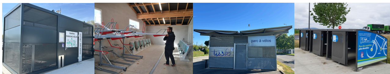
Figure 17 : Photographies des PVS GOT Plaisance Monestié (photo 1), Muretain Emob gare Muret (photo 2), Sicoval Station V (photo 3), conseil départemental de la Haute Garonne (photo 4), 2026, Louis RIEU
