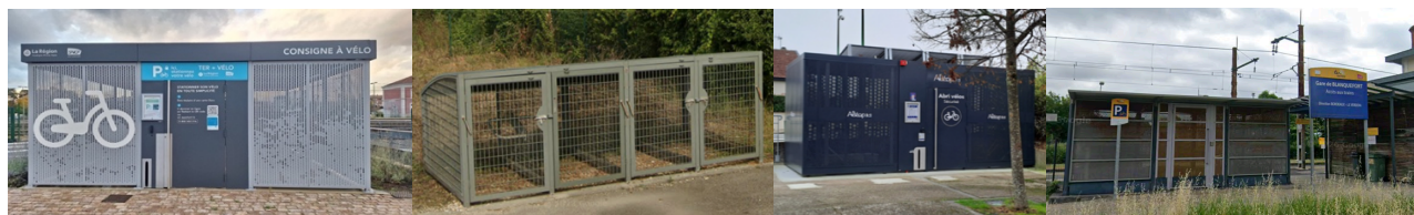
Figure 28 : Photographies des PVS Région AURA (photo 1 et 2), Pays de la Loire (photo 3), Nouvelle Aquitaine (photo 4), 2026.
