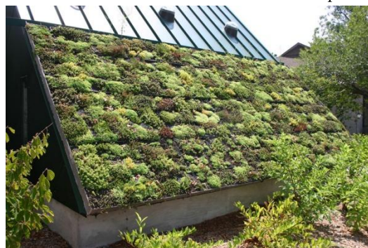
Une toiture partiellement végétale
