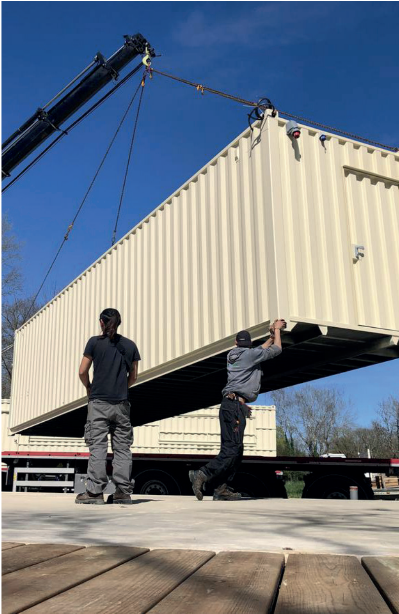
Figure 105. Installation de la structure de Bivouak. La guinguette est réalisée à partir de préfabriqués qui abritent une cuisine et des espaces de stockage. Bivouak est ainsi entièrement démonté à la fin de la saison. Photographie © Charente Libre. 2024. Utilisation à des fins éducatives. Source : https://media.charentelibre.fr/19018812/1200x-1/img-6925.jpg?v=1711095375
