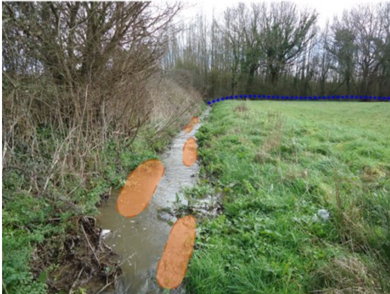
Figure 47 : Aménagement de banquettes sur le dernier linéaire du secteur 1
