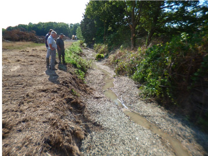
Figure 31 : Tracé d'un lit d'étiage pour le Douavit (1er projet de restauration du Sah) grâce à la recharge granulométrique
