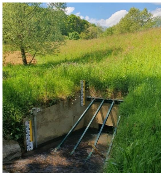
Figure 4 : Bassin écrêteur à Narcastet, pour éviter les débordements en aval en créant une retenue, avec ici le système anti-embâcle du pertuis et les repères de crue. Source : L. Marchal
