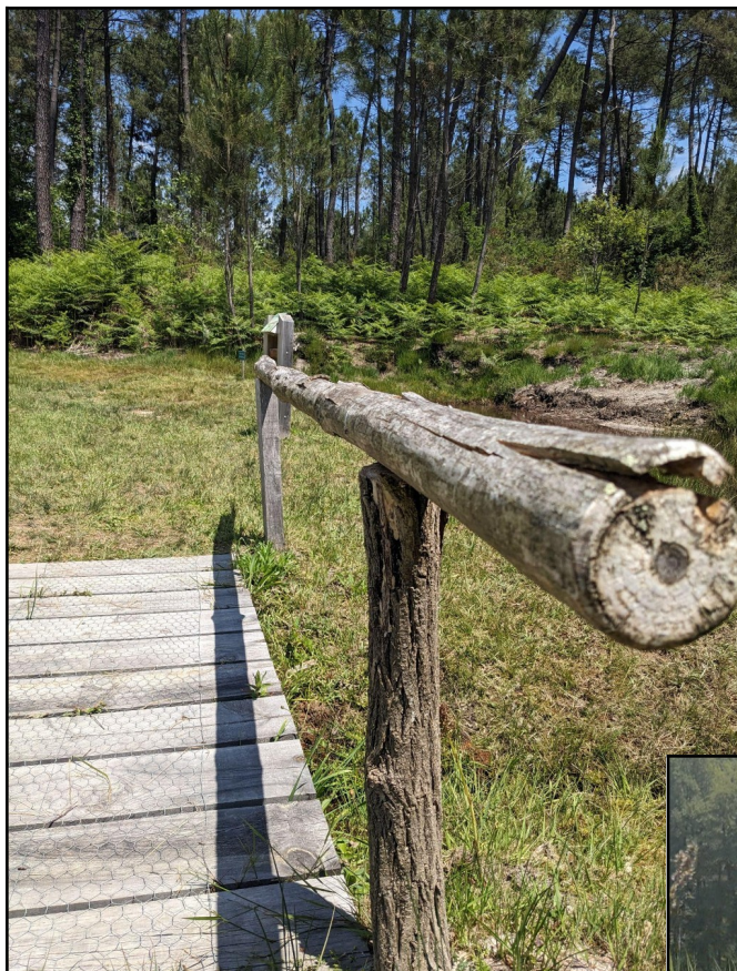
Figure 23 : Photographie D'une barrière après réparation @Y. ABERCHANE
