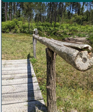
Figure 23 : Photographie D'une barrière après réparation @Y. ABERCHANE
