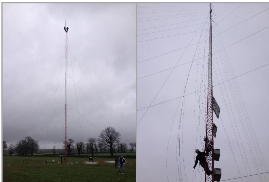
Figure 15 : Installation du mât de mesure sur un projet Eurocape
