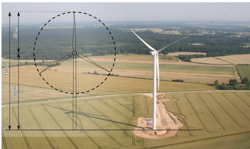
Figure 34 : Croquis d'une découpe d'éolienne à partir d'une installation d'Eurocape
