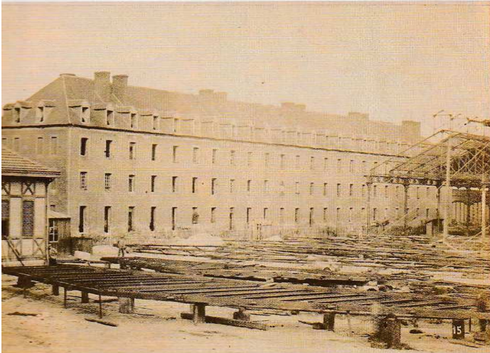
Ch. Lallement, Album Usine du Creusot , 1881, photographie, écomusée Creusot-Montceau. Bâtiment des « mécaniciens »
