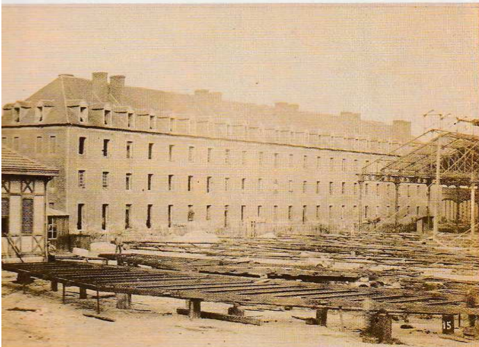
Ch. Lallement, Album Usine du Creusot , 1881, photographie, écomusée Creusot-Montceau. Bâtiment des « mécaniciens »
