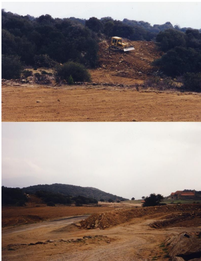
Figure 42: Photographie des travaux d'aménagement pour le golf, mars 1996 (Archives du prieuré)
