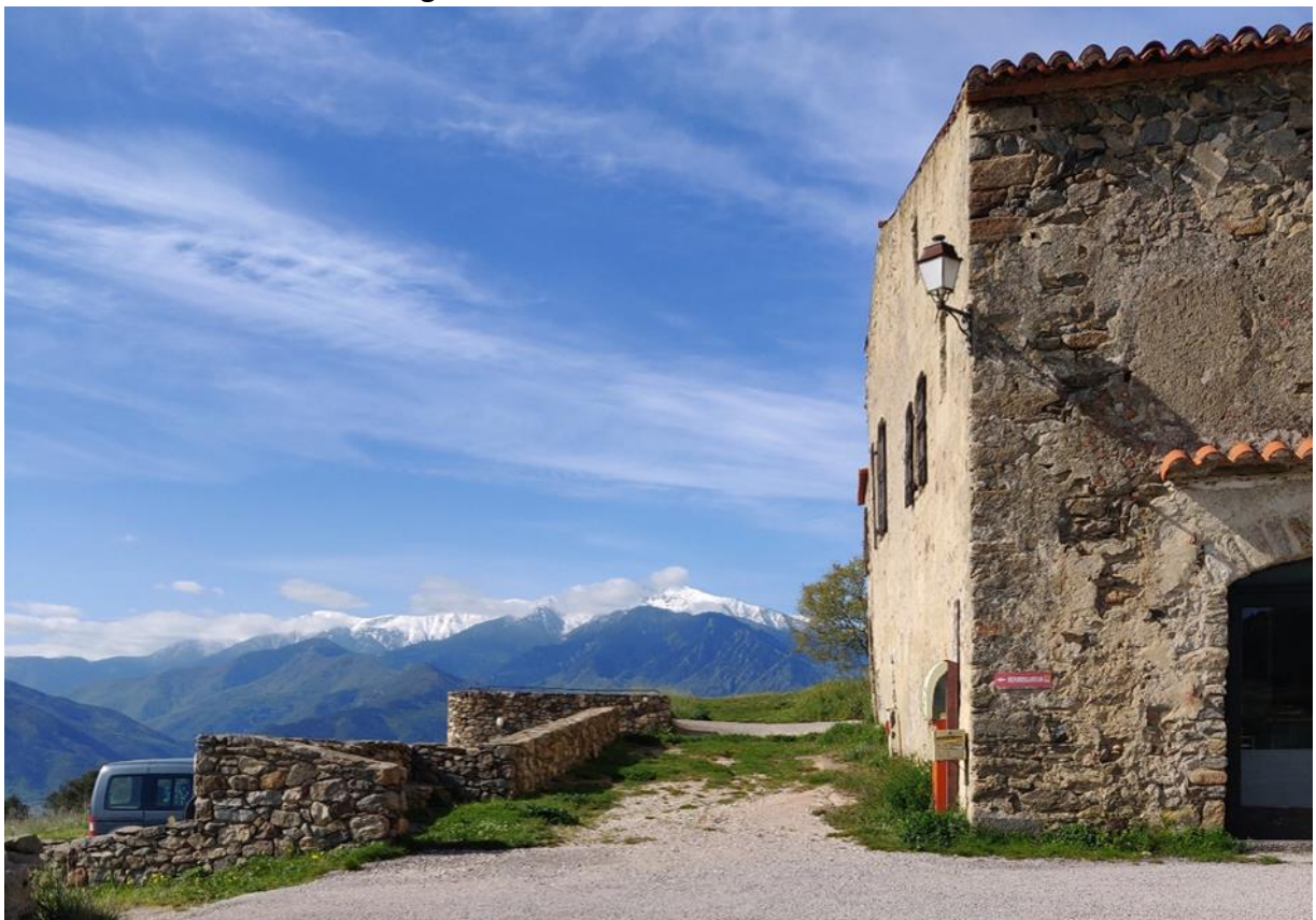
Figure 38: Vue sur le pic du Canigou depuis la façade Est (Sophia Dufour)
