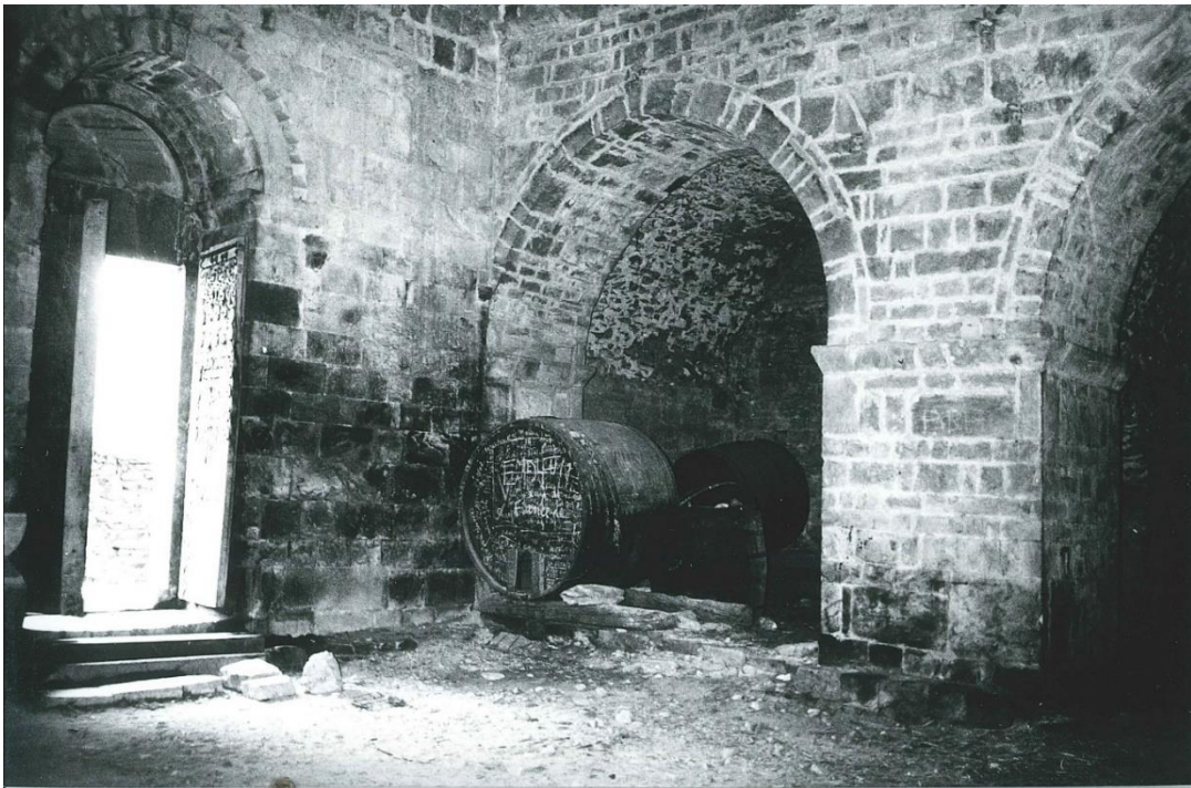
Figure 36: Photographie de l'église en février 1961 (Source : archives prieuré)
