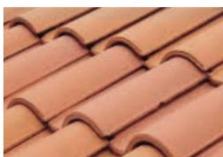
Figure 5 : Toiture en tuile canal
