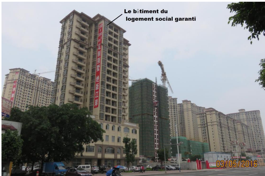
Figure 15 : Le bâtiment du logement social garanti dans le coin du quartier
