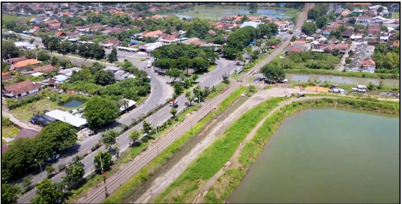
Figure 20 : Photo aérienne oblique prise par drone en limite nord-ouest du périmètre endigué du LUSI, dans le secteur du village de Ketapang protégé par une levée © Raja Drone, janvier 2021
