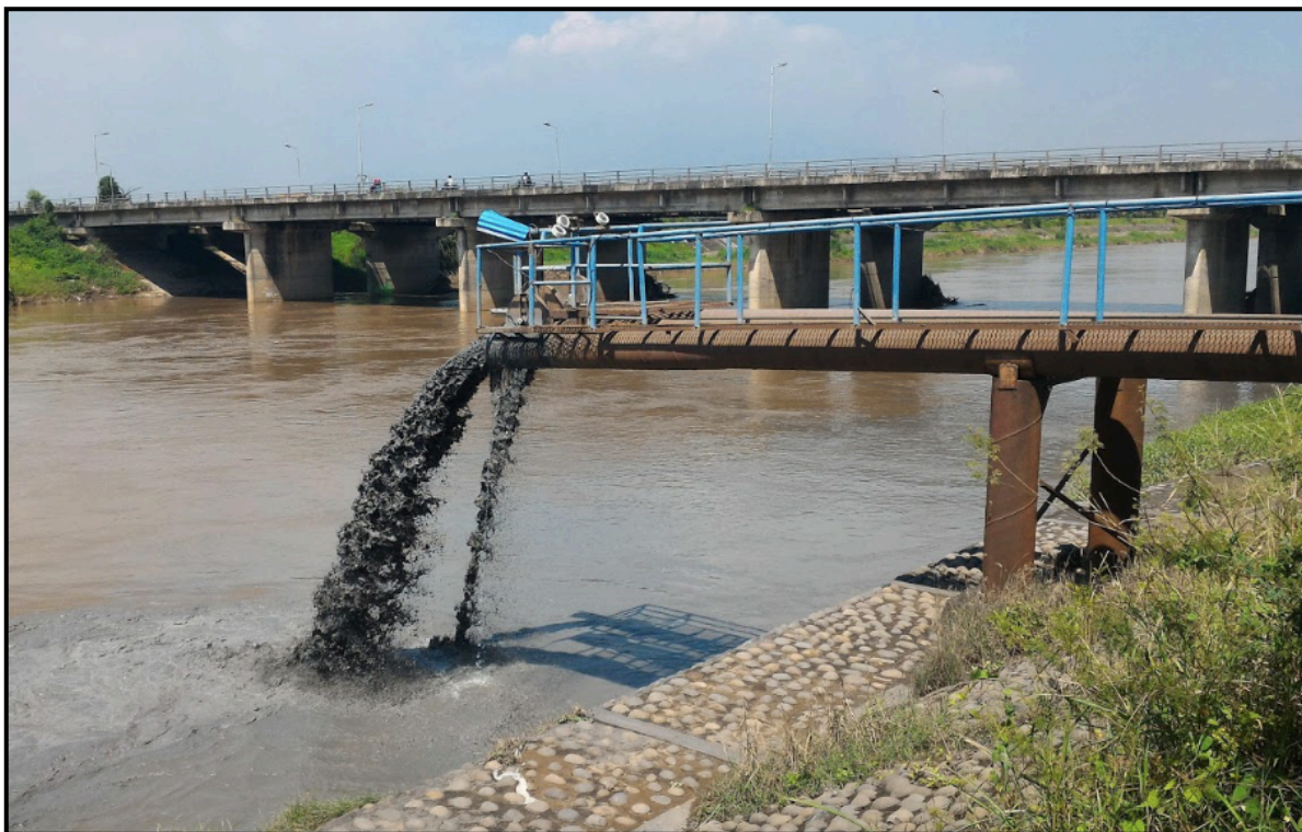
Figure 23 : Sortie du conduit évacuant une partie de la boue émise par le LUSI et se déversant dans la rivière Porong, au sud de la zone © Adang Awh, 2017
