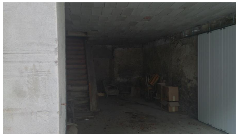
Figure 30: Les habitations après le passage de la crue
