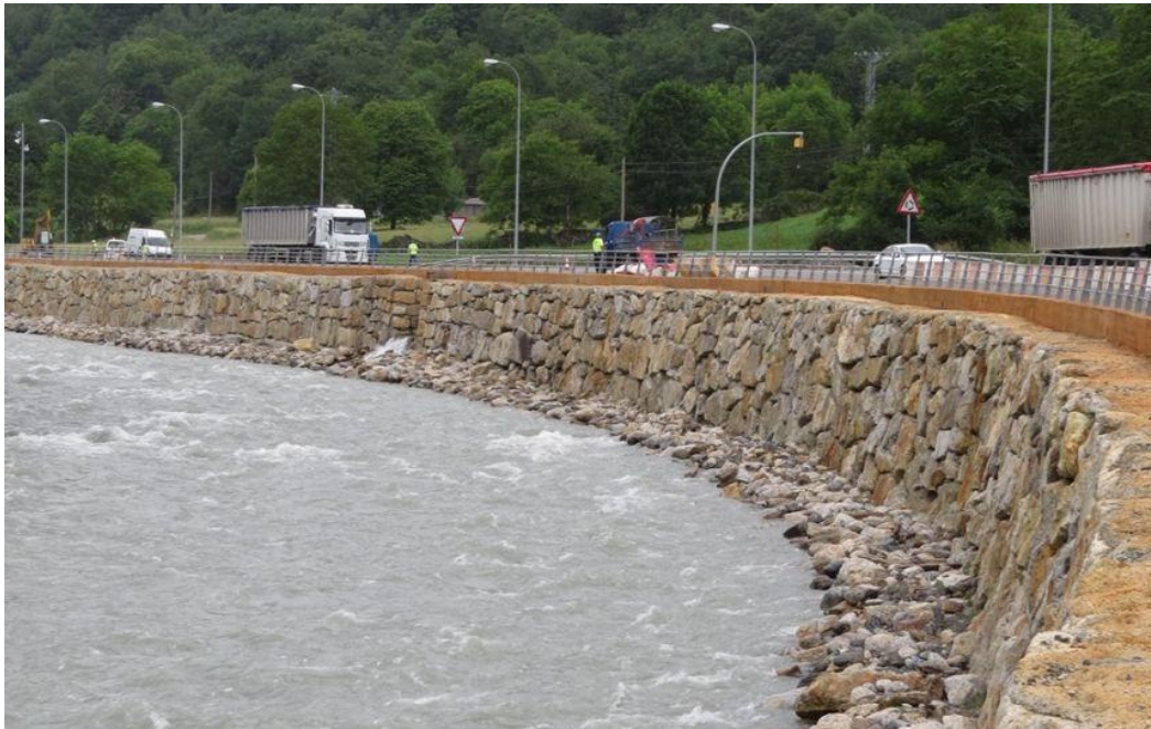
Figure 35: Enrochement sur la Garonne du côté espagnol Source : http://www.metronews.com
