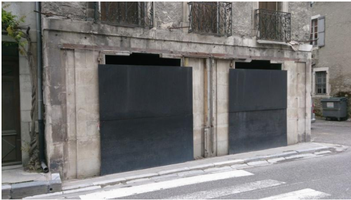
Figure 28: Les façades ont été abimées par la crue
