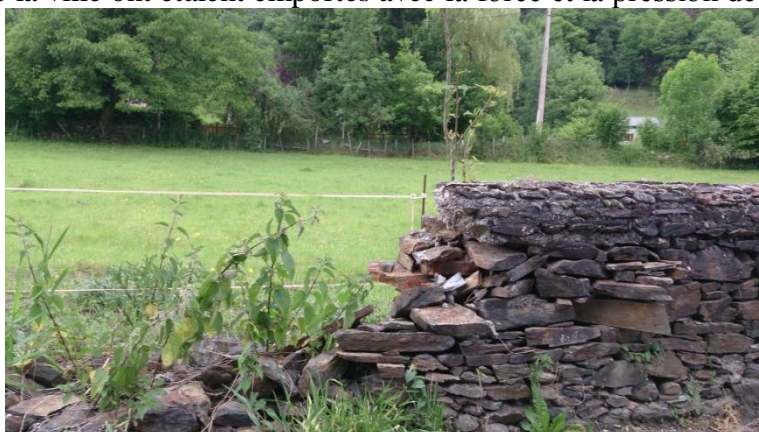
Figure 21: Muret détruit lors de l'inondation à Fos.
