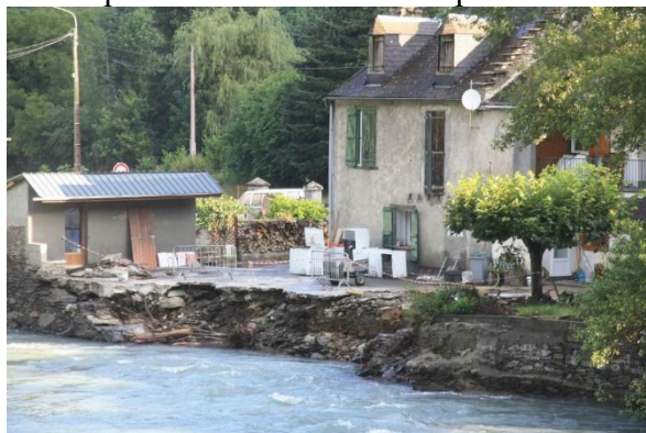
Figure 20: Bâti résidentiel ayant été fortement endommagé à l'entrée de Fos
