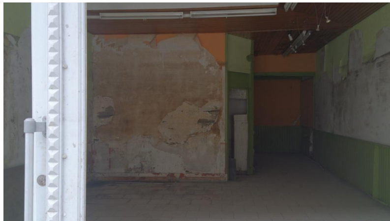
Figure 29: l'intérieur d'une maison de Saint-Béat
