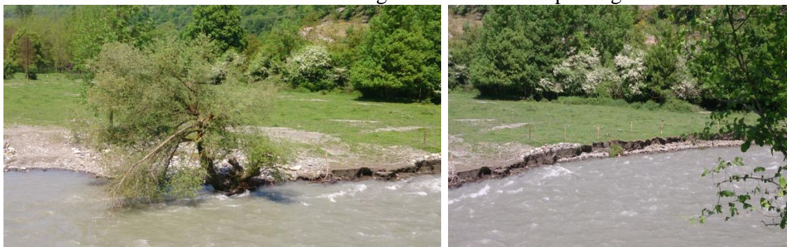
Figure 25 : berges de la Garonne à Arlos
