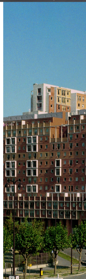
Photo après livraison 1982
