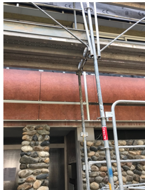
Figure 58 Photographies du chantier. Source : C Dupuis
