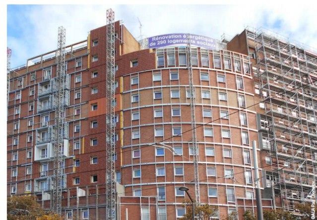
Photo pendant la pose de l'isolation et de la structure métallique extérieure, 2015
