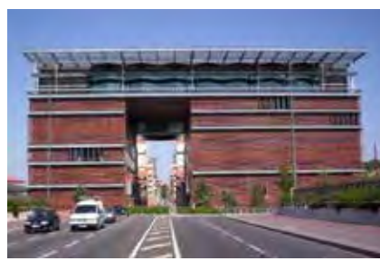
Figure 45 Médiathèque José Cabanis (Source : Pinterest.fr)
