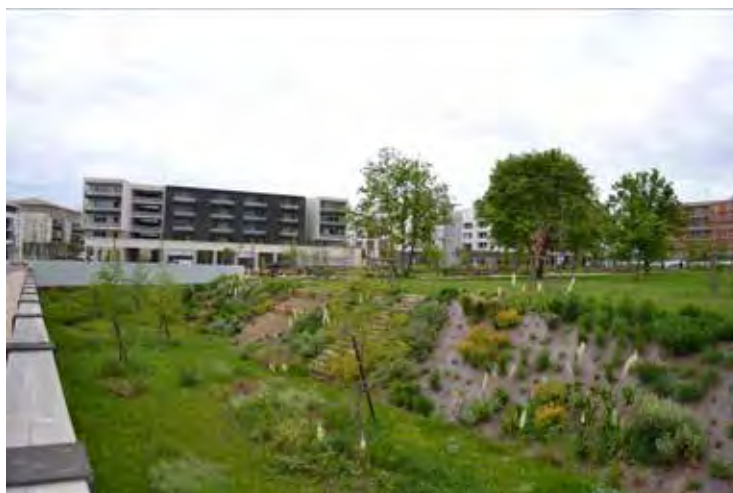
Figure 29 Une noue paysagère dans le quartier de Vidailhan à Balma (Source : Eco-quartiers.fr)
