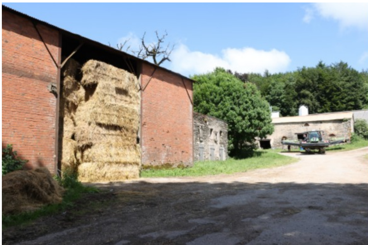
Figure 34: Vue sur l'un des bâtiments des Moussels
