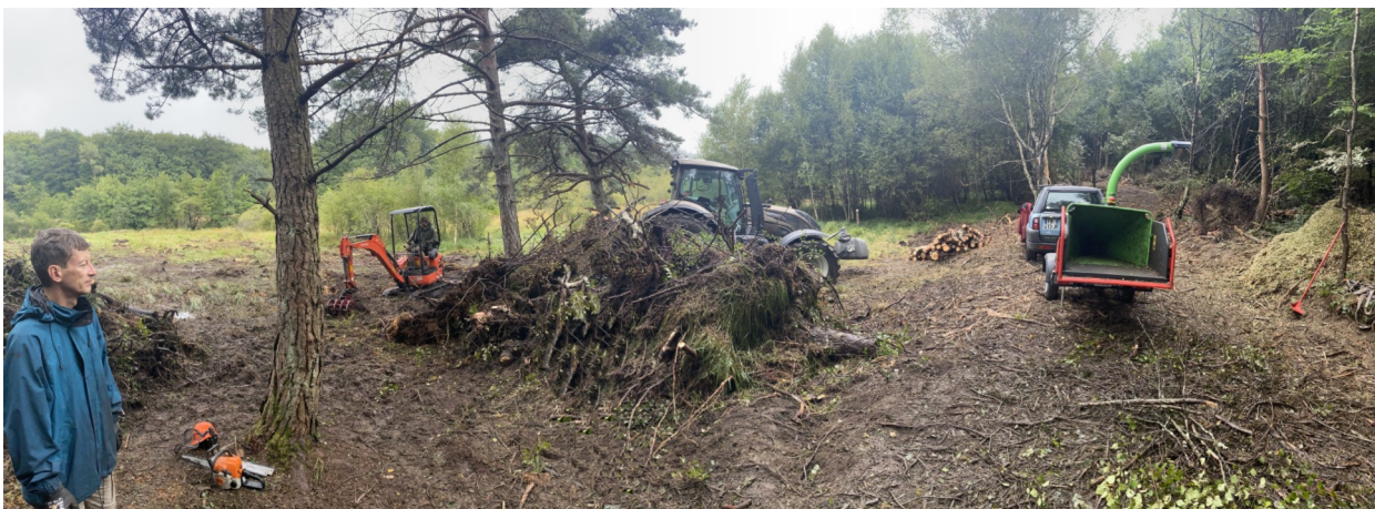
Figure 8: Photographie du chantier (Léo Souillard, 2024)
