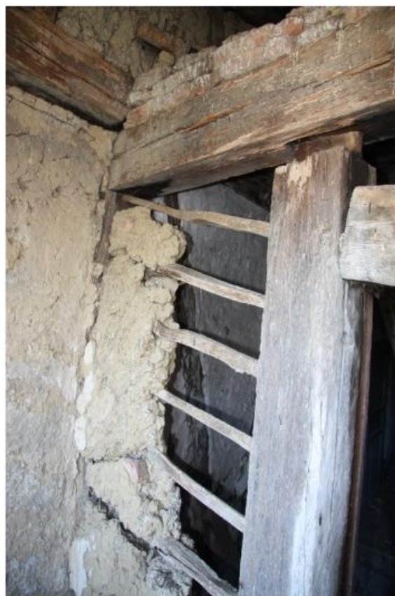
Figure 54 : Mise en œuvre de torchis sur une armature d'éclisses (25 rue Tourneuve) © Joris Moron
