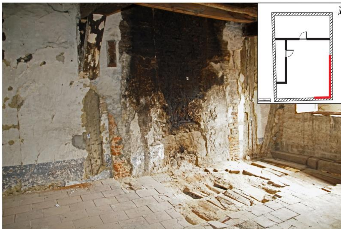
Figure 67 : Traces d'arrachements de la cheminée (paroi est) © Joris Moron
