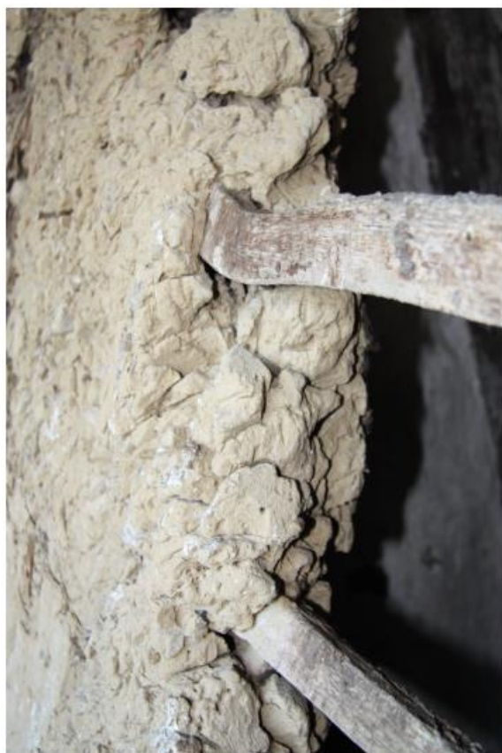
Figure 54 : Mise en œuvre de torchis sur une armature d'éclisses (25 rue Tourneuve) © Joris Moron
