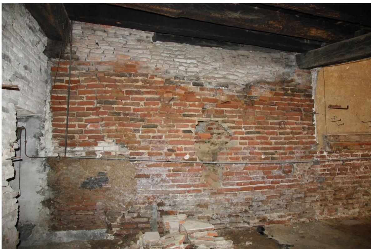
Figure 64 : Paroi est du rez-de-chaussée de la maison n°21 rue Tourneuve © Joris Moron
