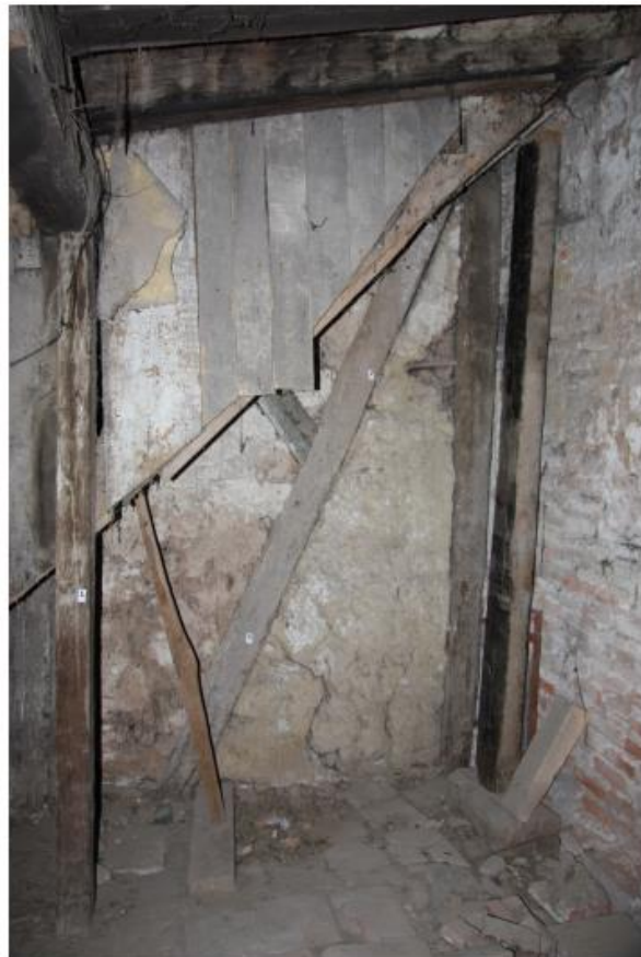
Figure 74 : Parois est (brique) et ouest (torchis) de la pièce arrière © Joris Moron
