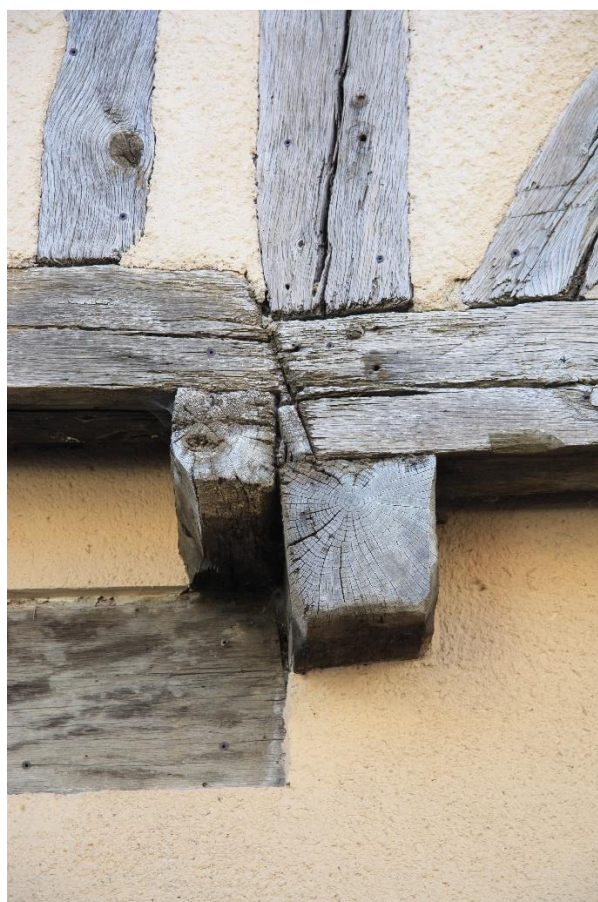
Figure 103.2 : Mise en œuvre des sablières de chambrée des n°6 et 8 (1 er étage) © Joris Moron
