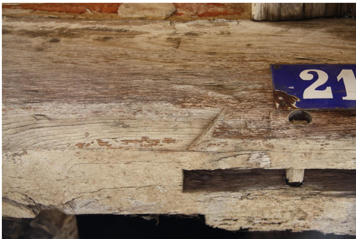
Figure 83.2 : Alignement du poteau disparu et du cadre défini par le chanfrein (21 rue Tourneuve) © Joris Moron
