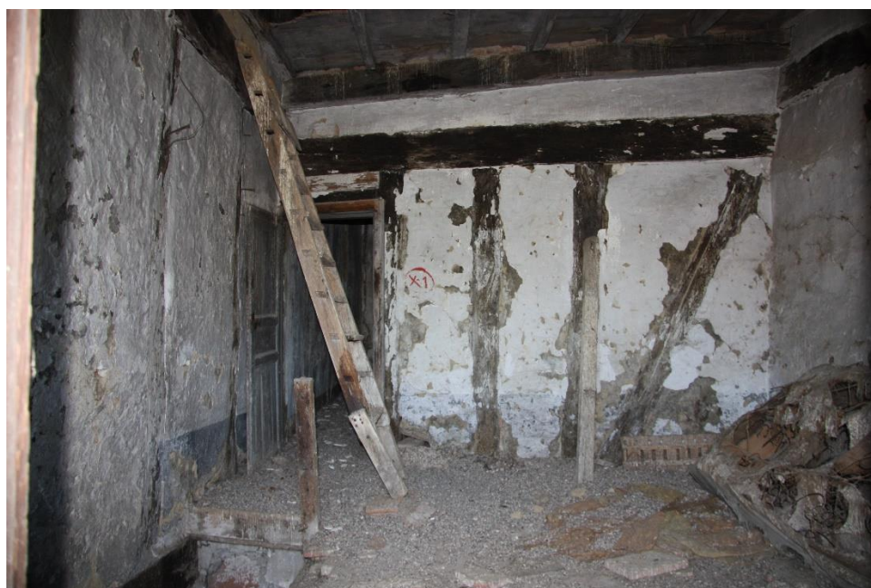
Figure 79.2 : Prise de vue depuis le passage entre la galerie et la pièce 1 (25 rue Tourneuve) © Joris Moron
