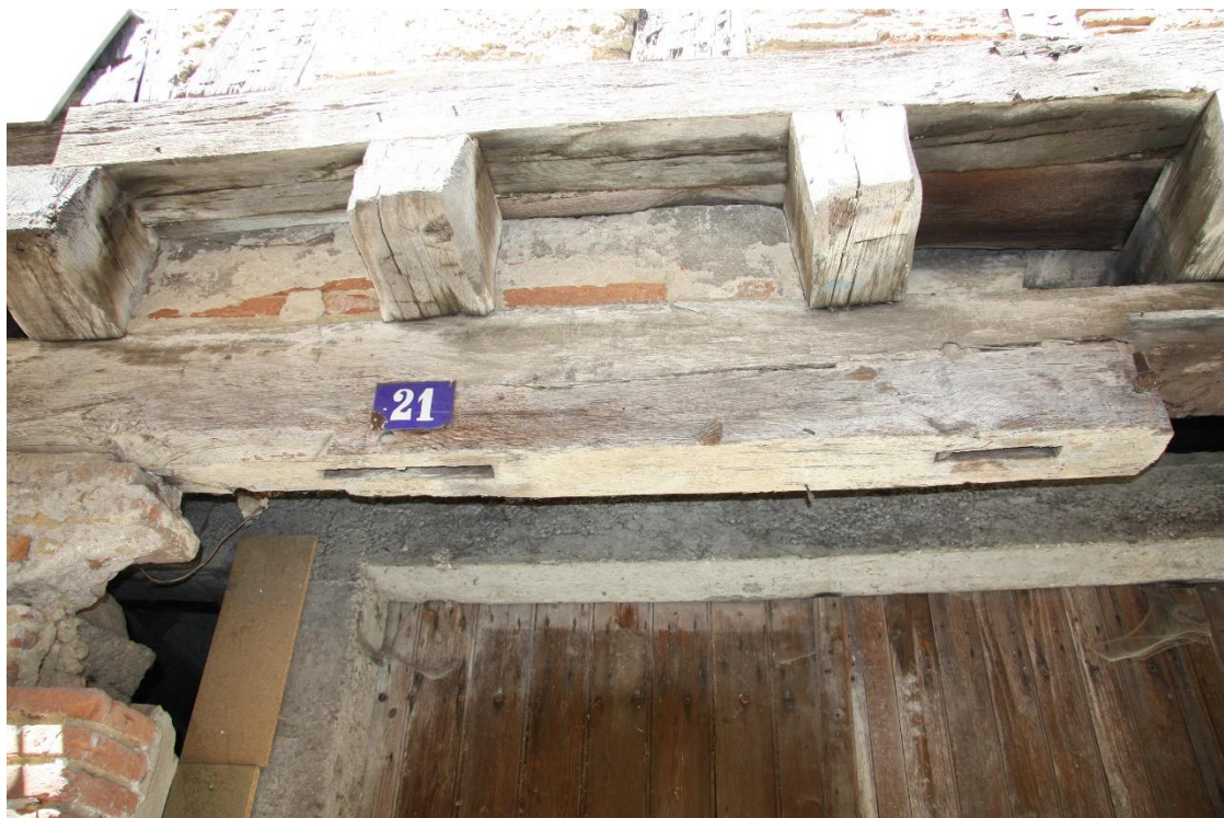
Figure 82 : Photographie des mortaises n°1 (gauche) et 2 (droite) sur le relevé (21 rue Tourneuve) © Joris Moron
