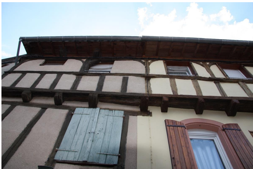
Figure 90 : Galerie répartie sur les façades des n°41 et 43 rue Tortueuse © Joris Moron
