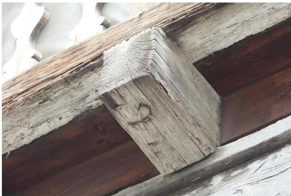
Figure 60.2 : Chevillage de deux éléments dans un plan horizontal (17 rue Tourneuve) © Joris Moron
