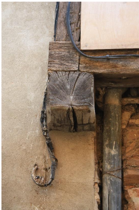
Figure 50 : Calle mise en œuvre en compensation de la sablière disparue © Joris Moron
