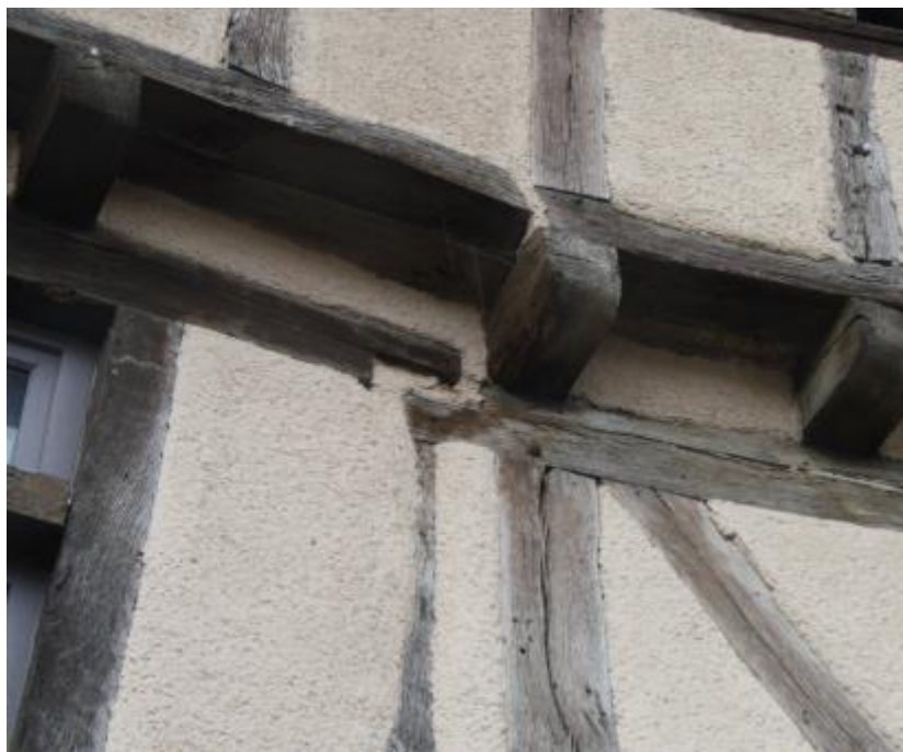
Figure 103.1 : Assemblage à mi-bois entre les sablières de plancher des n°6 et 8 © Joris Moron
