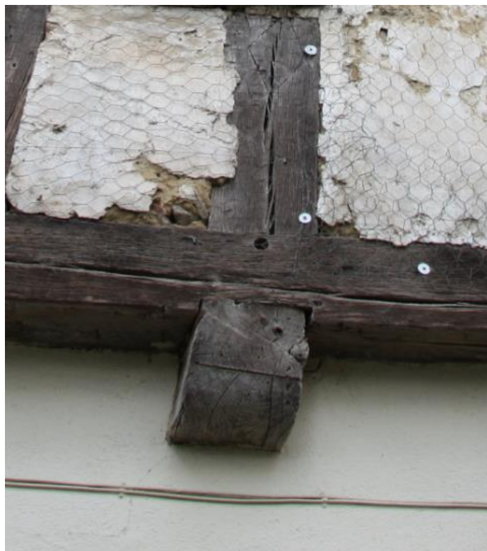
Figure 60.1 : Chevillage de deux éléments dans un plan vertical (25 rue Tourneuve) © Joris Moron
