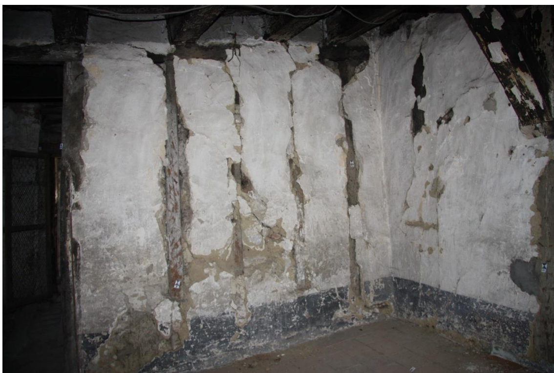
Figure 68 : Revêtement des parois de la pièce à vivre © Joris Moron
