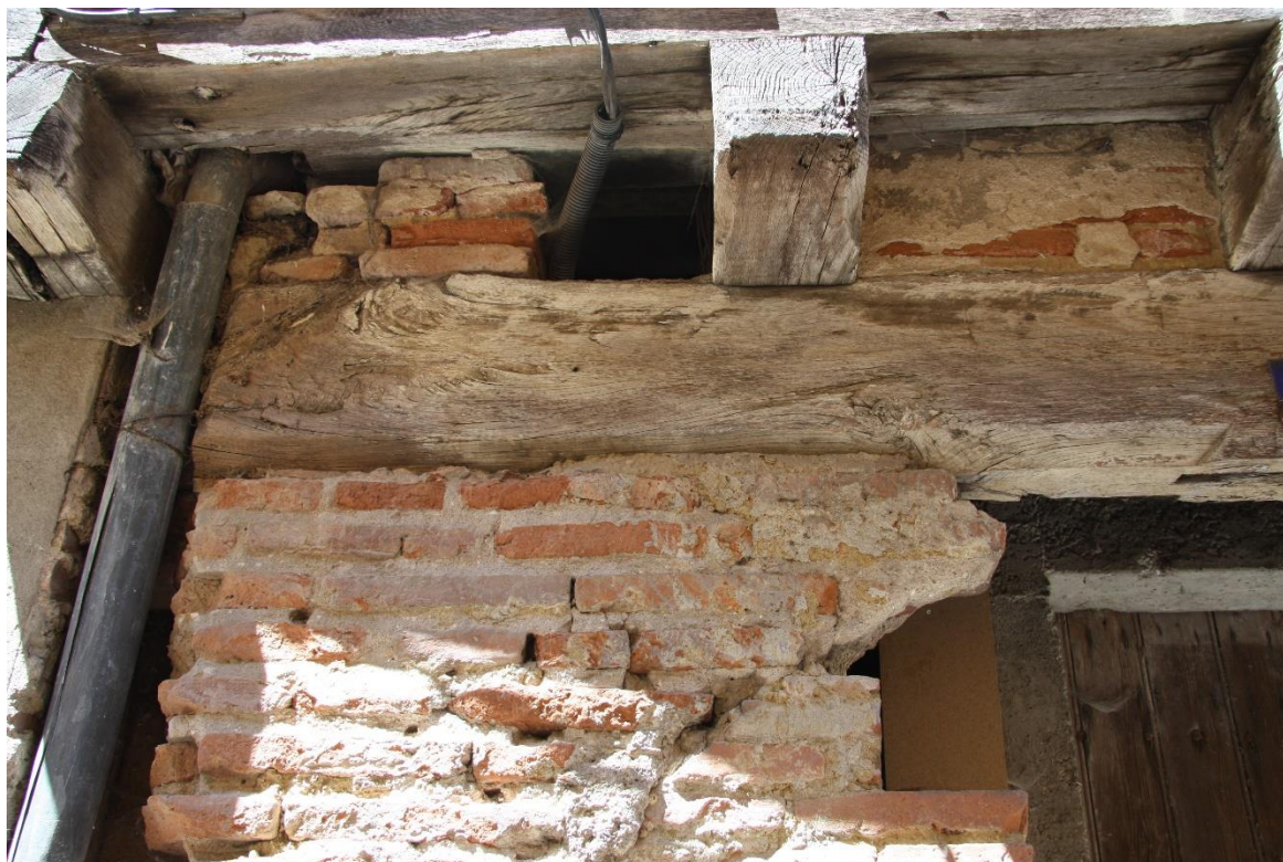
Figure 83.1 : Photographie du chanfrein aménagé en partie basse de la sablière (21 rue Tourneuve) © Joris Moron
