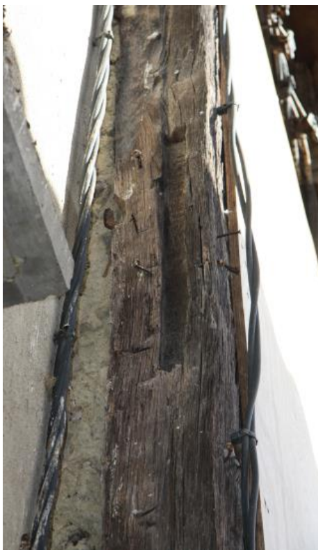
Figure 48 : Mortaise aménagée dans le poteau entre les n°19 et 21 (1 er étage) © Joris Moron
