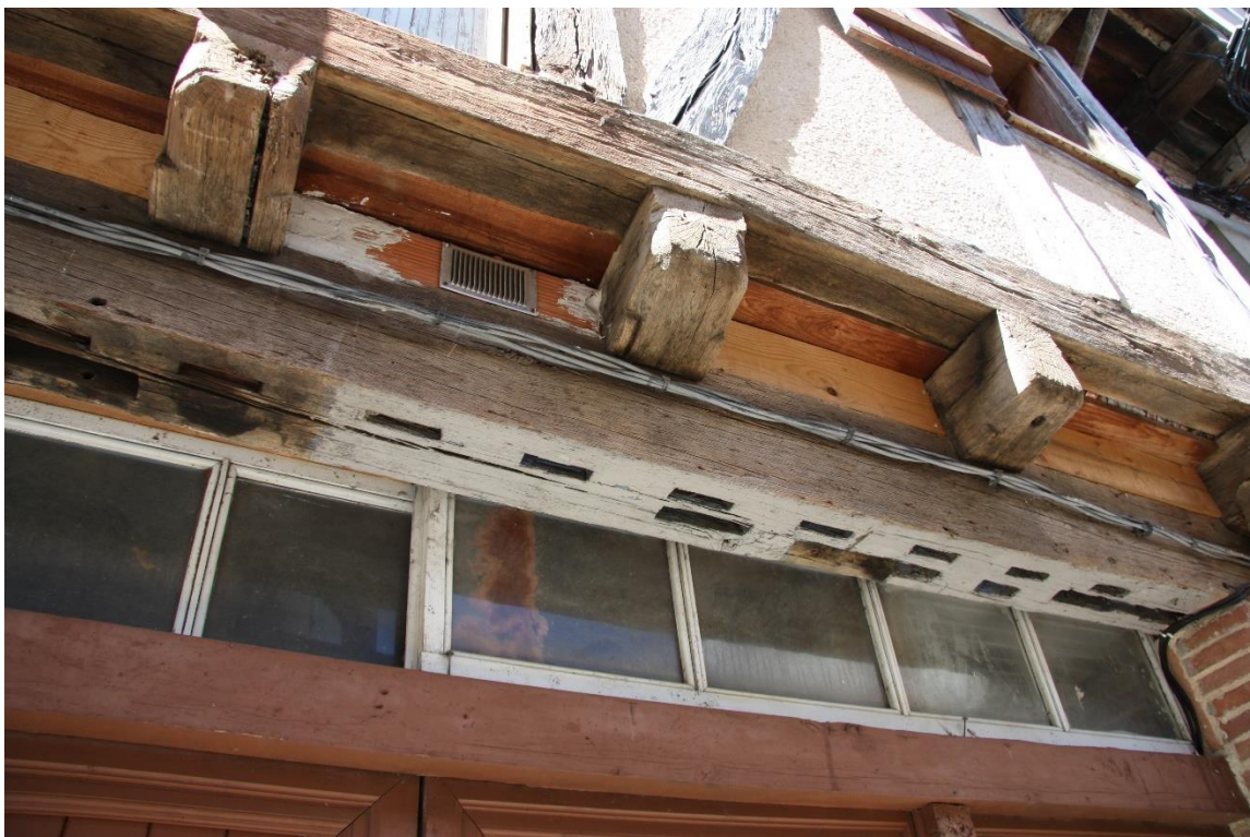
Figure 84 : Mortaises réalisées dans la face inférieure de la sablière (17 rue Tourneuve) © Joris Moron
