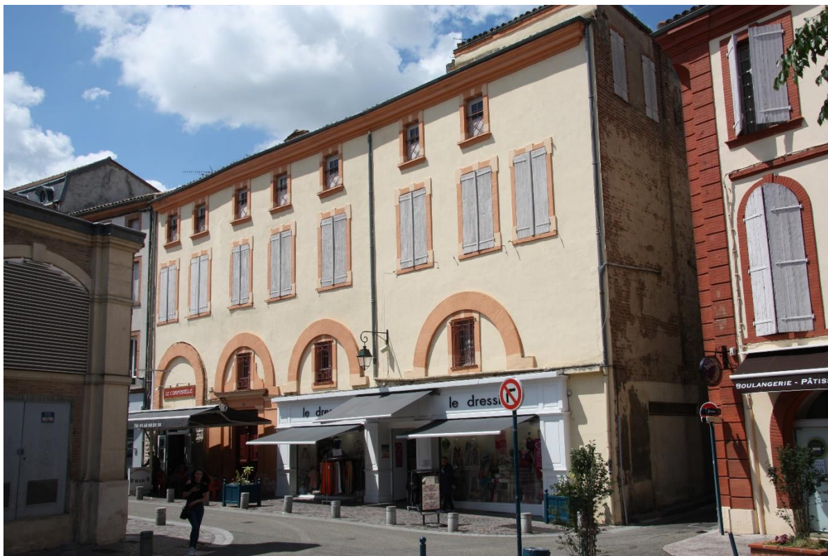
Figure 142 : Façade sud (sur rue Malaveille) de la « maison Lobios » © Joris Moron
