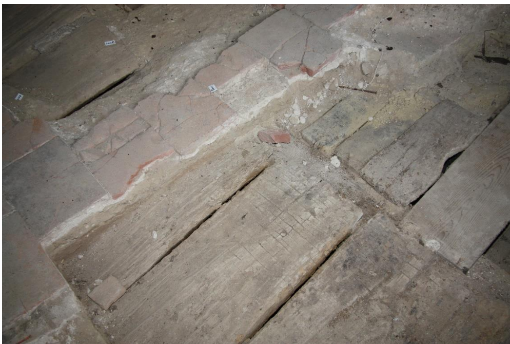
Figure 72.1 : Planches formant la première « couche » du niveau de sol © Joris Moron
