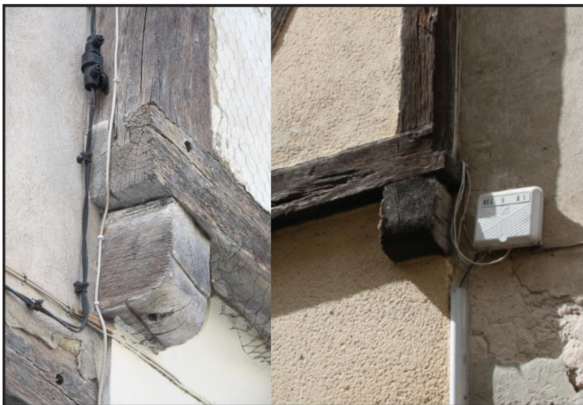
Figure 51.1 : Sablière de chambrée sciée au n°25 de la rue Tourneuve (à gauche) Figure 51.2 : Attente aménagée dans l'about de la sablière du n°23 de la rue Tourneuve (à droite)
