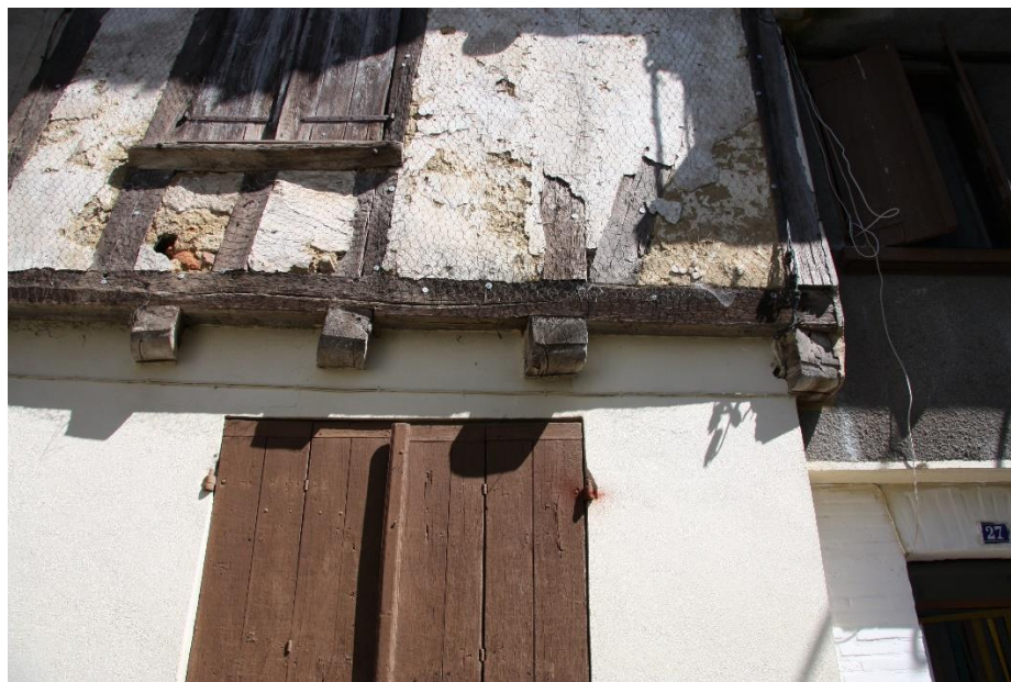
Figure 53 : Abouts de solives d'encorbellement d'angle (25 rue Tourneuve) © Joris Moron
