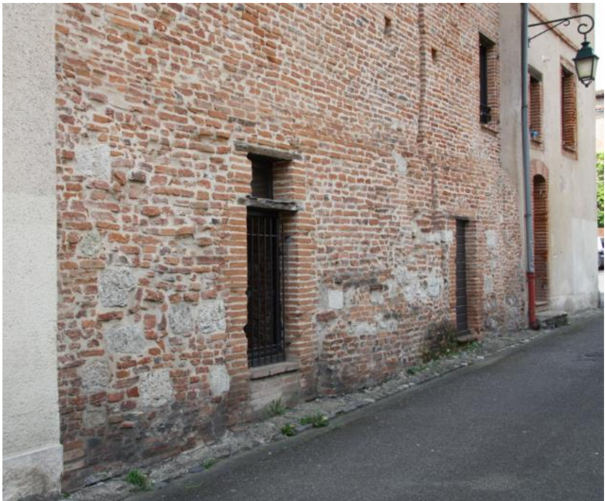
Figure 33 : Vestiges présumés du rempart en partie basse de l'élévation © Joris Moron
