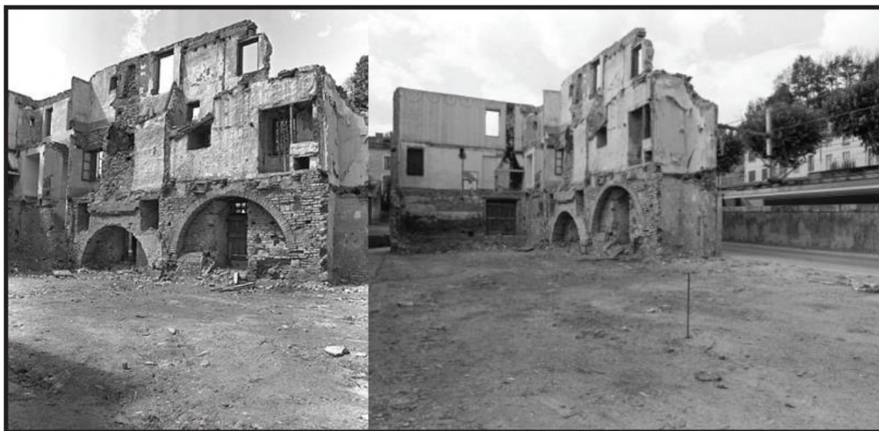
Figure 43.2 : Photographies prises après la démolition d'une partie de l'îlot ouest © Jean-François Peiré
