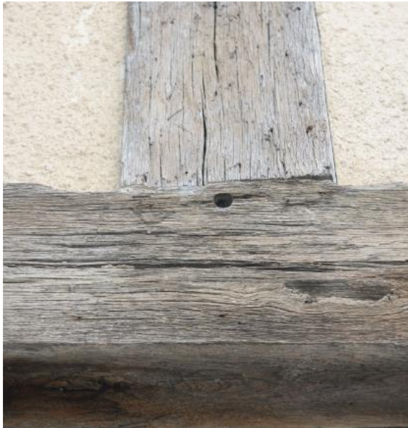
Figure 61 : Exemple de marques d'assemblage ou de charpentiers en V (17 rue Tourneuve) © Joris Moron
