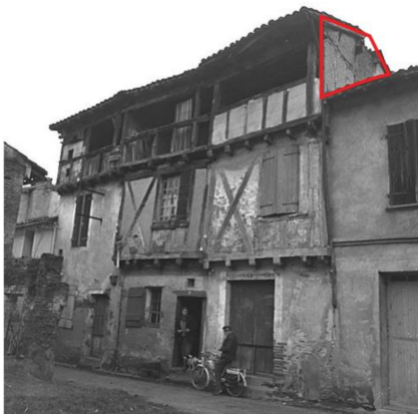
Figure 106 : Pan de bois apparent en façade nord de la construction n°6 rue Dérúa (état en 1969) D.A.O. : Joris Moron
