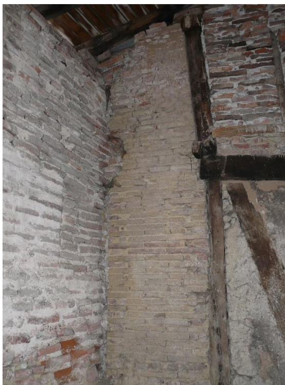
Figure 77.2 : Paroi est de l'unité ouest (25 rue Tourneuve, 1 er étage) © Joris Moron
