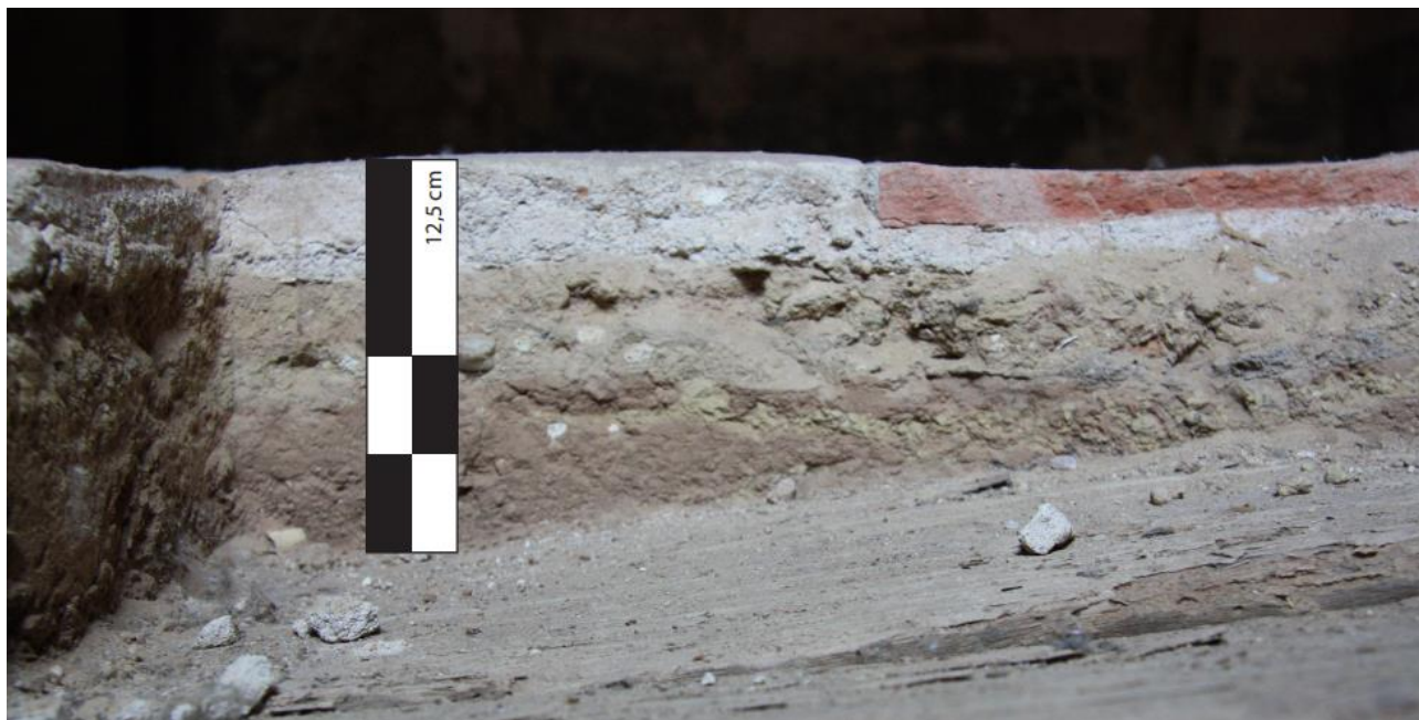
Figure 73 : Couche de terre rapportée entre le plancher et les tomettes © Joris Moron
