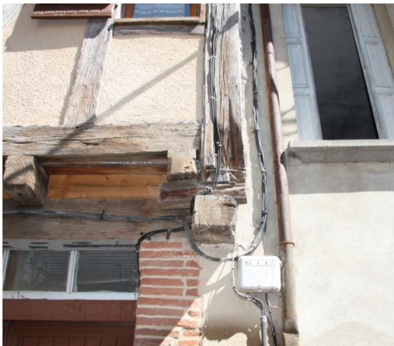
Figure 46 Perturbation de la structure en bois à la suite de la démolition du niveau voisin © Joris Moron
