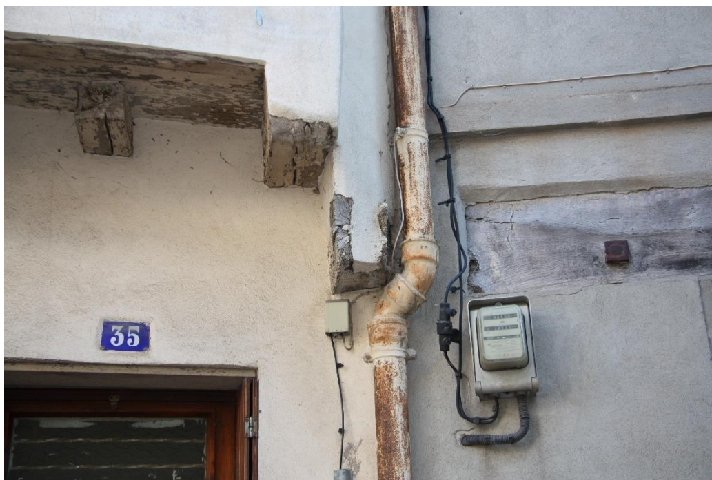
Figure 89 : Solive à la jonction entre les façades n°35 et 37 © Joris Moron
