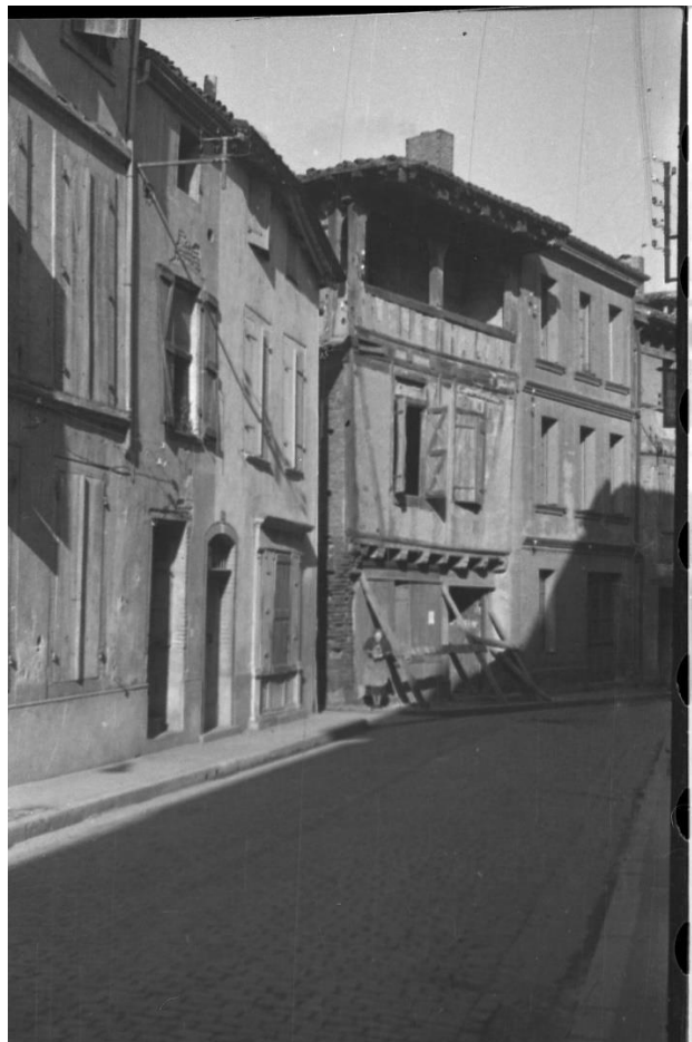
Figure 116 : Façade disparue à l'angle du Cul Roussol, Moissac (état au début du XX e s.) © Inconnu
