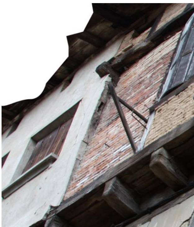
Figure 49 : Mortaise aménagée dans le poteau entre les n°19 et 21 (2 e étage) © Joris Moron
