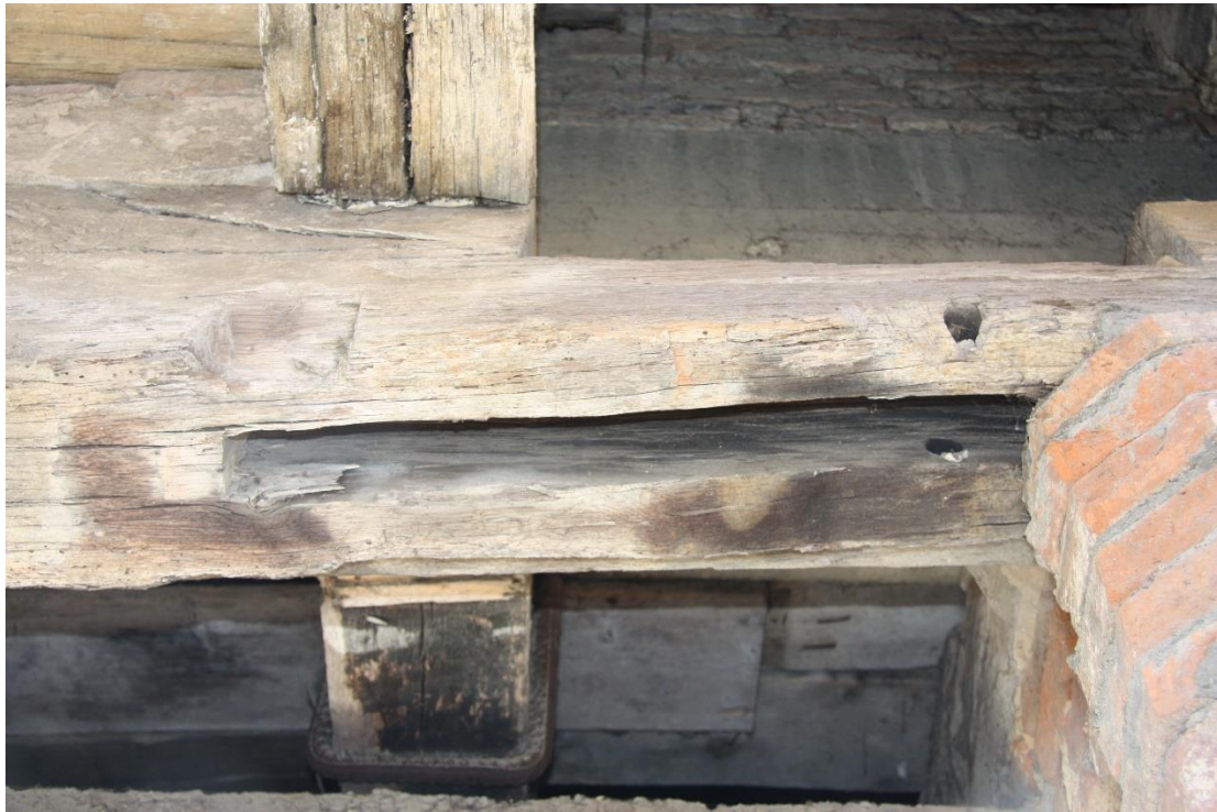
Figure 81 : Photographie de la mortaise aménagée la plus à l'est dans la sablière (21 rue Tourneuve) © Joris Moron
