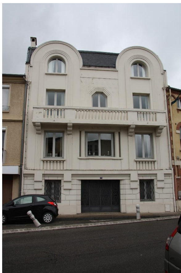
Figure 10.2 : Façade de la construction sise au n°7 du faubourg Sainte-Blanche © Joris Moron
