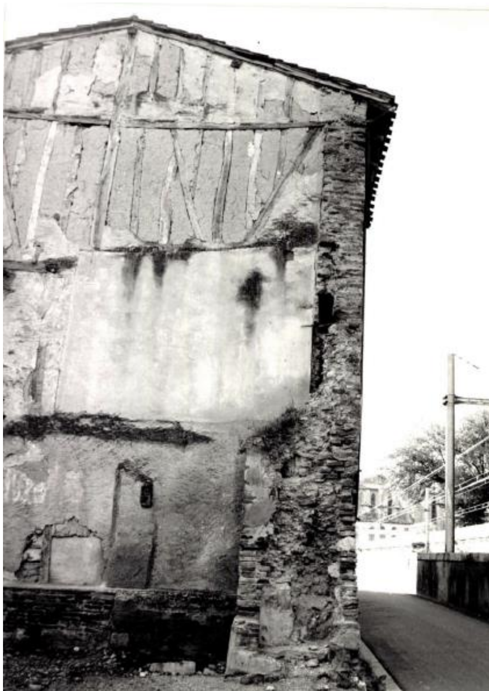
Figure 32 : Photographie du supposé mur de rempart après démolition © Jean-François Peiré
