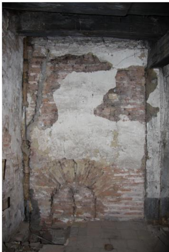
Figure 74 : Parois est (brique) et ouest (torchis) de la pièce arrière © Joris Moron
