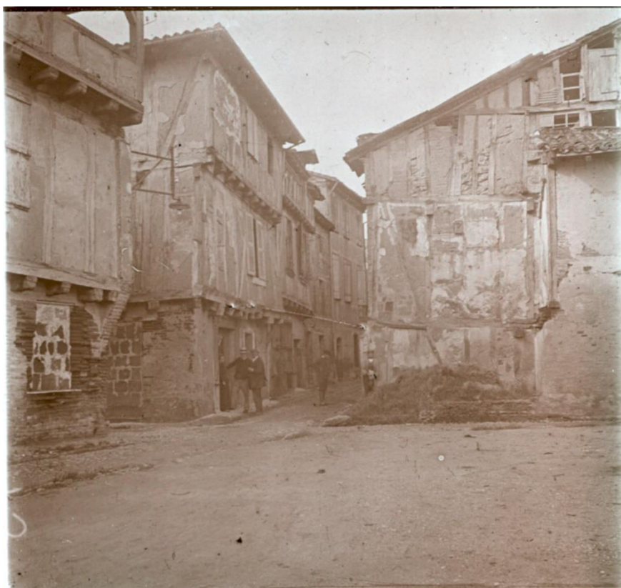
Figure 143 : Élévations en pan de bois disparues (angle sud-ouest de l'actuelles Place des palmiers) © Inconnu
