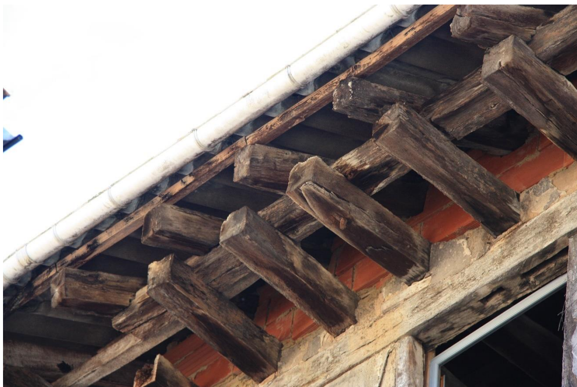
Figure 85 : Système de soutènement des chevrons débordants de la charpente de toiture (13 rue Guileran, Moissac) © Joris Moron
