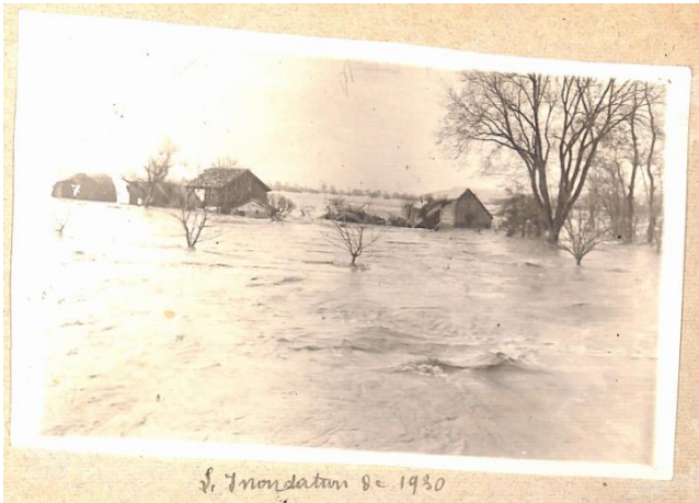
Figure 9.1 : Grande inondation de 1930 © Armand Viré
