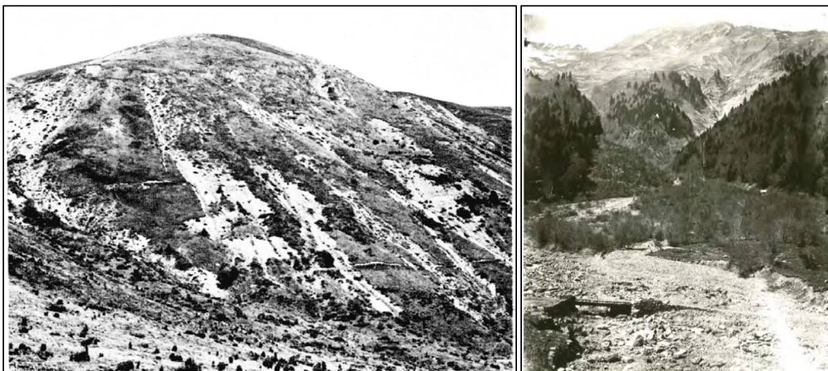
Figure 3.16 : Photographie de 1927 d'érosions du versant à Labach au-dessus de Cathervielle dans le bassin du Larboust provoquées par les pluies de 1865 et 1875 in Métaillé, 1988 et photographie du Laou d'Esbas en 1887 par le service RTM in ETRM, 2012.
