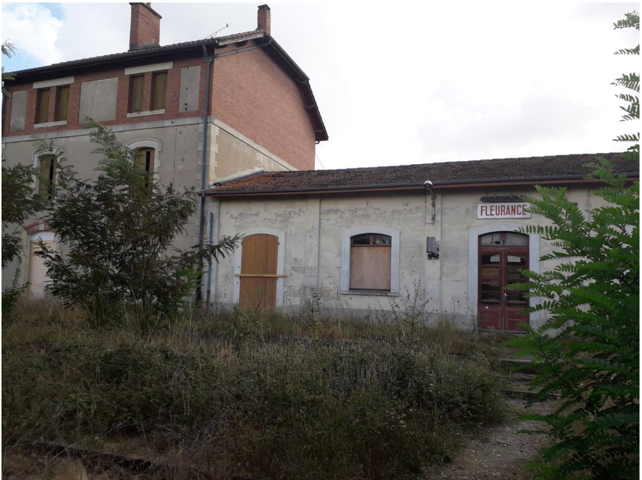
Figure 37 : Ancien bâtiment voyageurs de la gare de Fleurance le 10 septembre 2019 (photographie personnelle)
