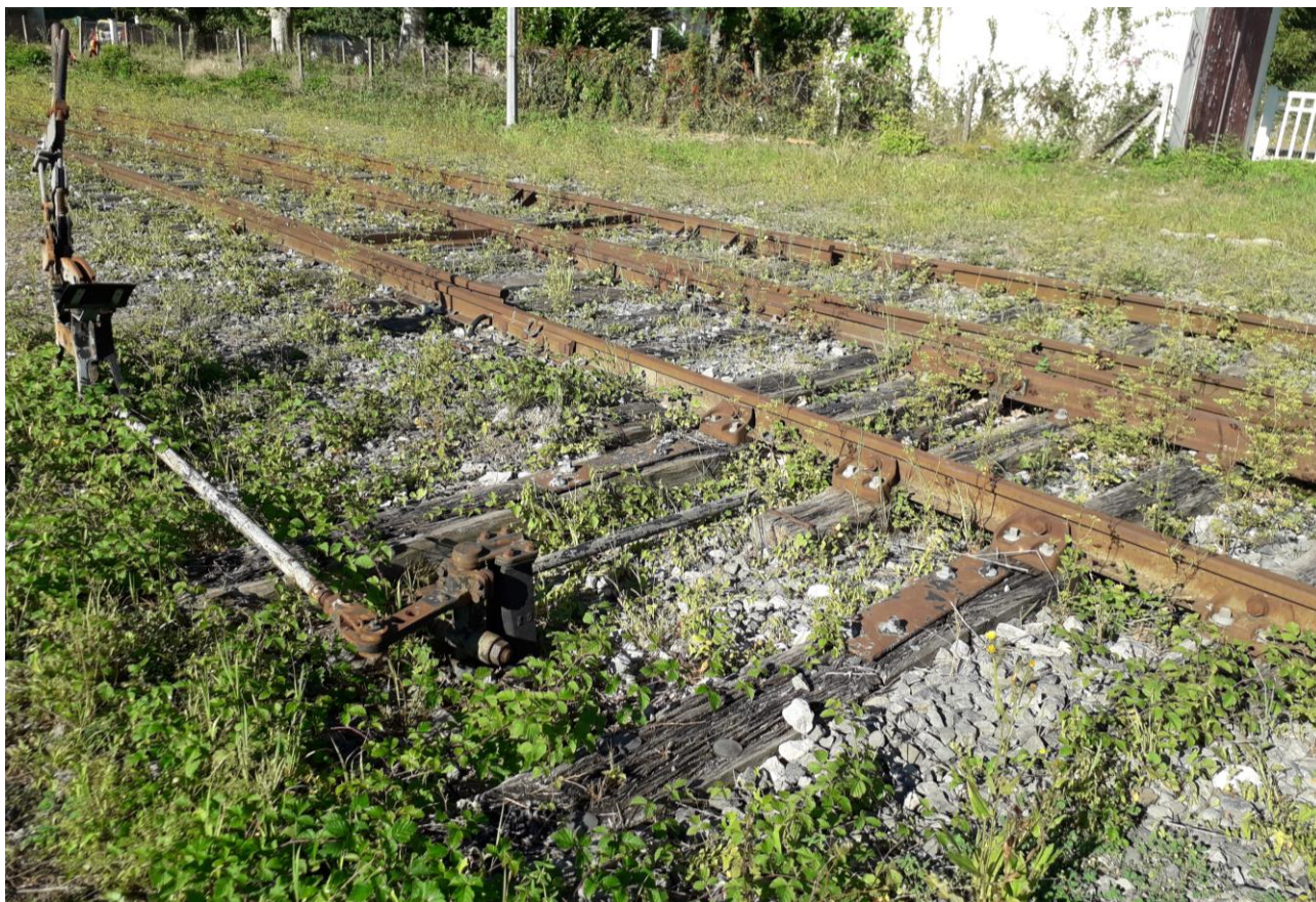
Figure 12 : Armement de la voie et aiguillage à Marignac, sur la ligne Montréjeau-Luchon, le 9 septembre 2019 (photographie personnelle)
