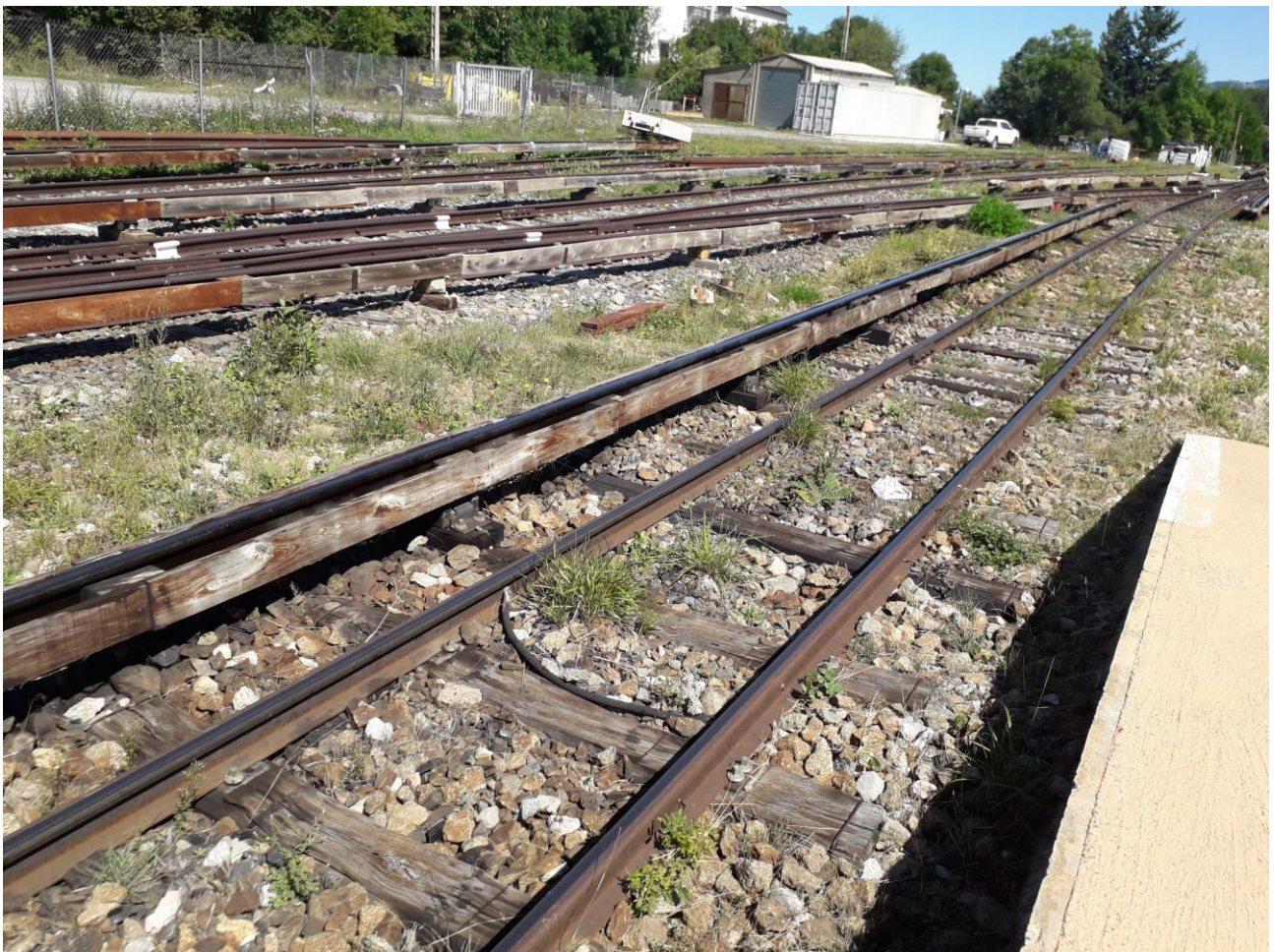
Figure 13 : Plateforme de la voie de la ligne du Train Jaune en gare de Mont-Louis La Cabanasse, le 6 septembre 2019 (photographie personnelle)
