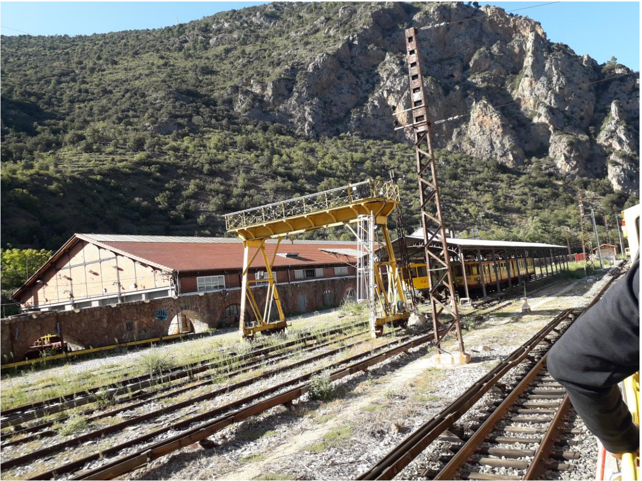
Figure 62 : Stockage de voitures du Train Jaune avec au fond l'atelier de maintenance dédié à la ligne de Villefranche-de-Conflent, le 6 septembre 2019 (photographie personnelle)
