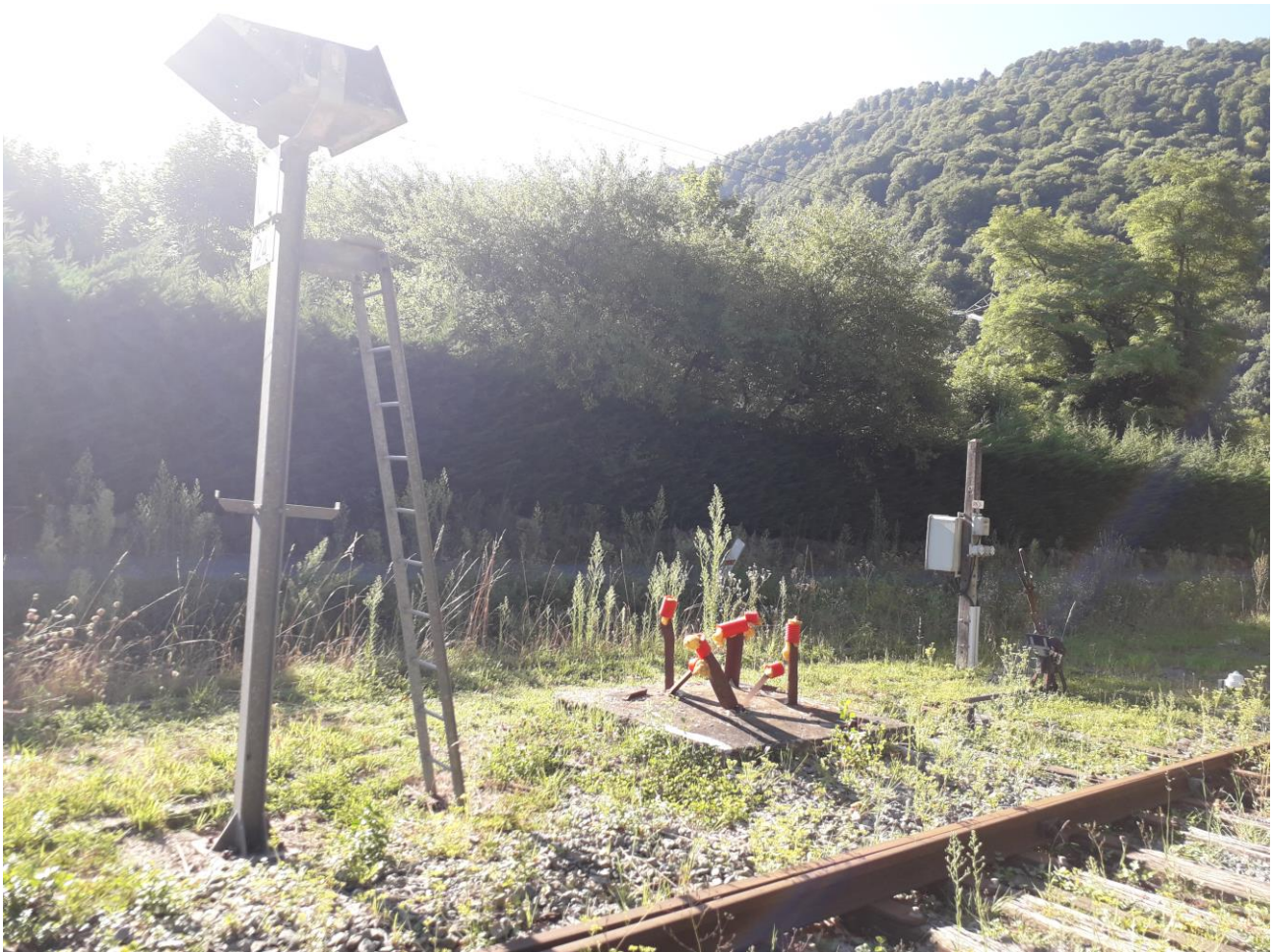
Figure 43 : Pied d'un ancien poteau caténaire à Marignac le 9 septembre 2019 (photographie personnelle)
