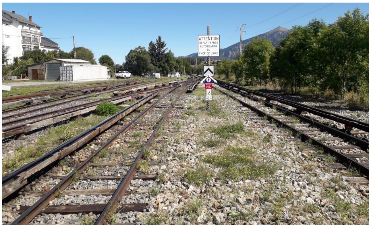
Figure 66 : Signalisation en gare de Mont-Louis, le 6 septembre 2019 (photographie personnelle)
