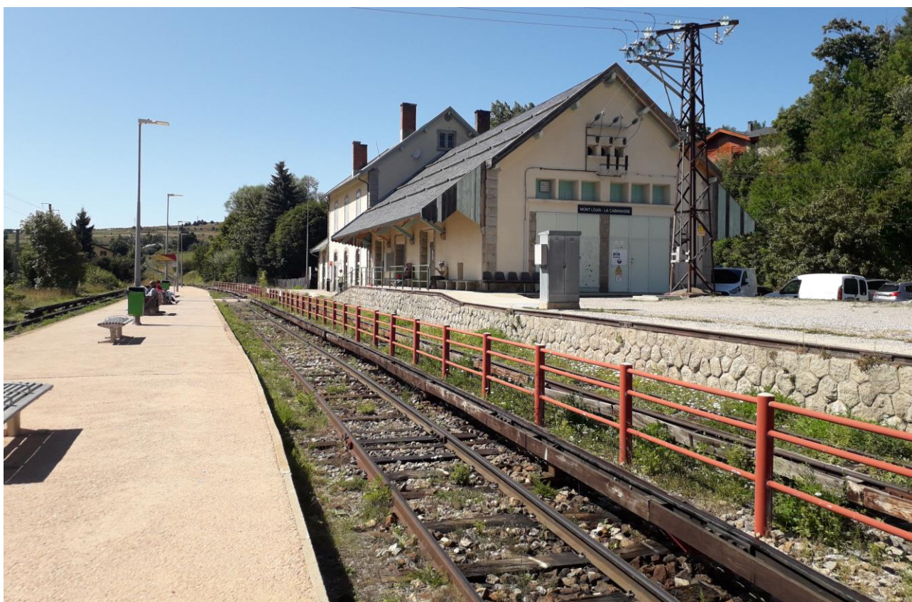
Figure 65 : Etat de la voie et des quais au niveau de la gare de Mont-Louis La Cabanasse, le 6 septembre 2019 (photographie personnelle)
