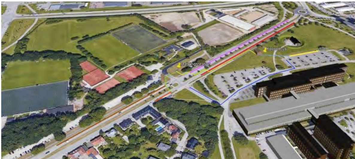
Figure 25 : Implantation de l'infrastructure sur une voie réservée aux bus en proche périphérie de la ville de Lund. Source : Présentation en vue de contribuer à la troisième conférence des systèmes de routes électriques (ERS) à Frankfort en mai 2019, http://media.electricroads.org/2019/04/S3-Zethraeus-ELONROAD-A-charging-infrastructure-for-cities.pdf , vérifiée le 12/12/2020
