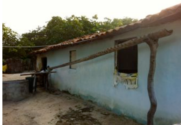
Figure 1.4 - Récupération des eaux pluviales - Gouttière et puits
