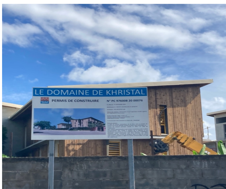
Figure 56 Démolition et reconstruction Domaine de Khristal
