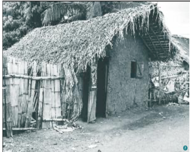
Case traditionnelle de Mayotte, vers 1980 Construite en terre, bois et fibre végétale. Type de construction aujourd'hui quasiment disparu.
