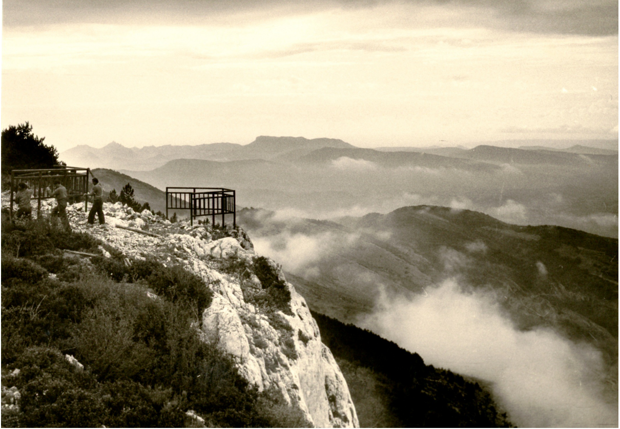
Construction d'un belvédère sur le Ventoux, du côté de Malaucène. Photo : Firmin Meyer
