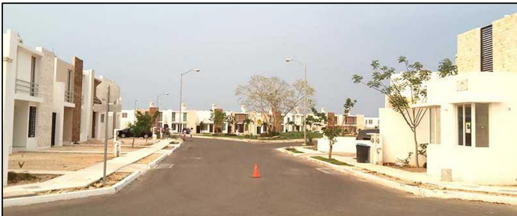
Photo 2 : Ciudad Caucel, logement moyen en résidence fermée. Photographie : Ojeda F.
