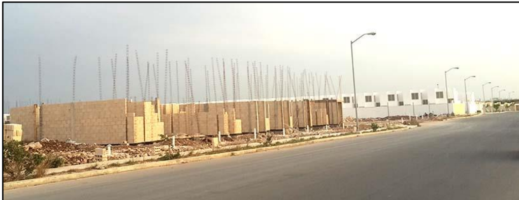
Photo 4 : Ciudad Caucel, logements encore en construction. Photographie : Ojeda F.
