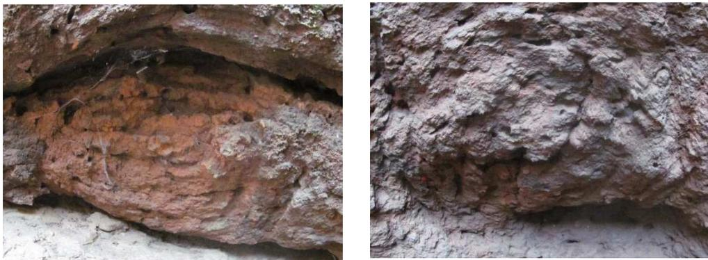
*Figure 35 : Encroûtement dans le puits de mine résultant d'une altération météorique*
