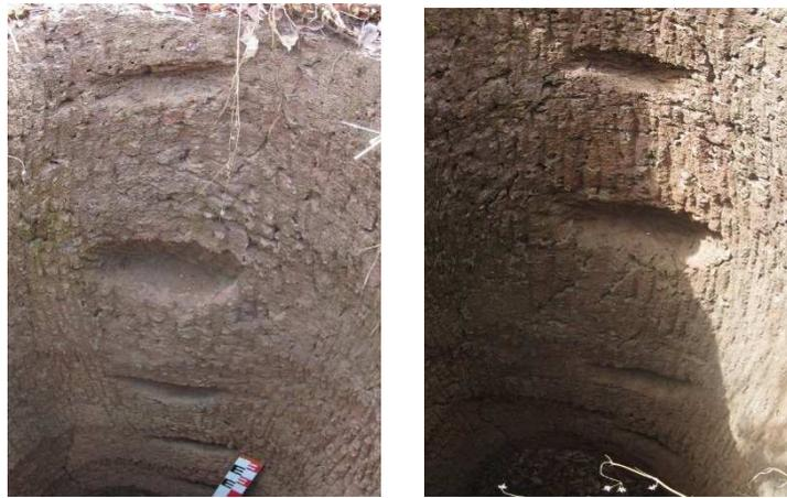
Figure 34 : Puits de mine matérialisé par les encoches parallèles et équidistantes
