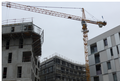
Figure 17 : Entre grues et chantiers, Mermoz Nord, mars 2016.
