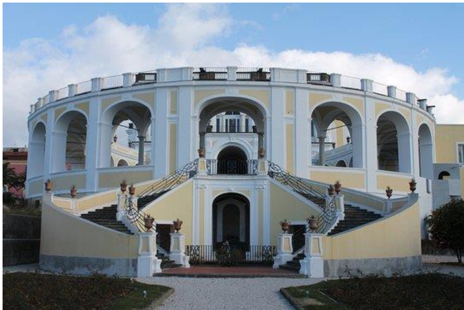
Faisant suite au portique le double escalier qui conduit au parc et au bord de mer.
